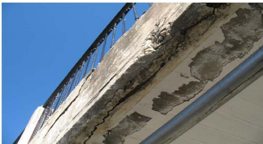
Εικόνα 25: Ομοιόμορφη διάβρωση
