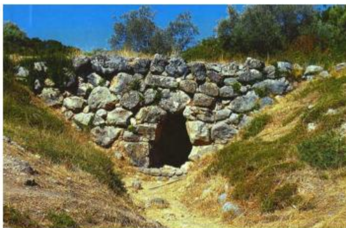
Εικόνα 1: Η Γέφυρα της Καζάρμας
