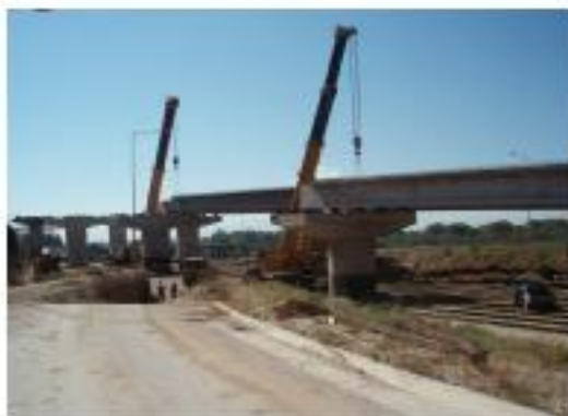
Εικόνα 11: Τοποθέτηση προεντεταμένων δοκών πάνω στα μεσόβαθρα
