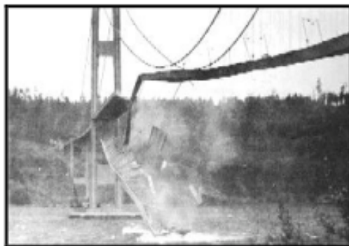
Εικόνα 16: Η Κατάρρευση της Γέφυρας στην Ουάσιγκτον
