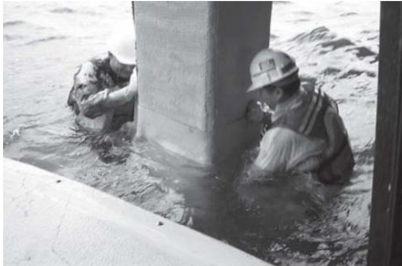
Εικόνα 36: Εφαρμογή και τοποθέτηση FRP κατά το σύστημα pre-preg
