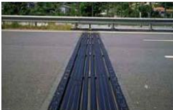
Εικόνα 8: Ελαστομεταλλικός αρμός διαστολής
