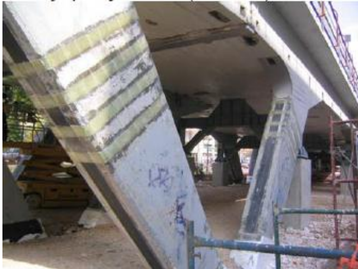
Εικόνα 26: Ενίσχυση Υποστυλωμάτων γέφυρας στον ΗΣΑΠ Αμαρουσίου απο σύνθετα υλικά
