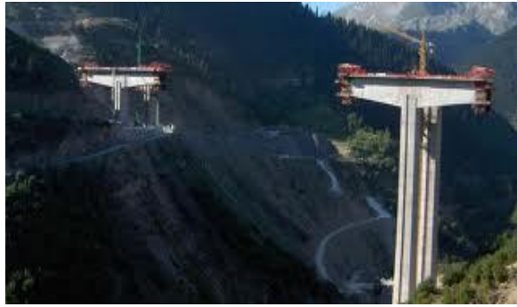
Εικόνα 15: Κατασκευή κοιλαδογέφυρας στην ΕΓΝΑΤΙΑ ΟΔΟ με προβολοδόμηση
