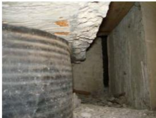
Εικόνα 19: Διογκωμένο Εφέδρανο
