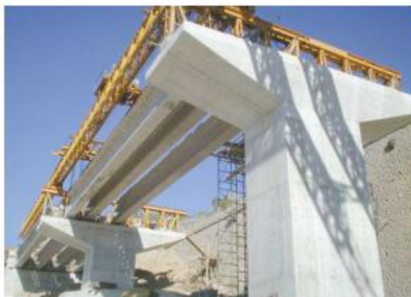
Εικόνα 12: Προεντεταμένες δοκοί πάνω στα μεσόβαθρα
