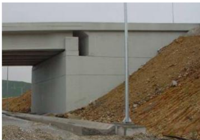
Εικόνα 6: Ακρόβαθρο Γέφυρας
