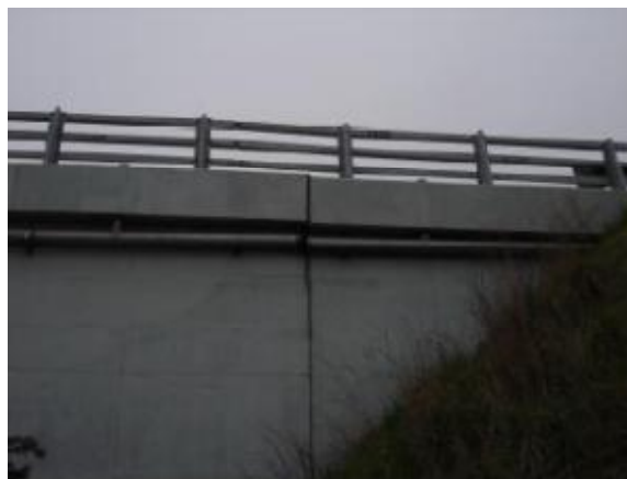
Εικόνα 20: Καθίζηση ακροβάθρου
