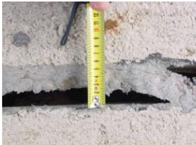
Εικόνα 21: Διάνοιξη αρμού απο οριζόντια και κατακόρυφη μετακίνηση
