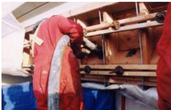
Εικόνα 29: Επανασκυροδέτηση Δοκού
