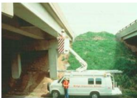
Εικόνα 18: Οπτικός έλεγχος με χρήση ανυψωτικού μηχανήματος
