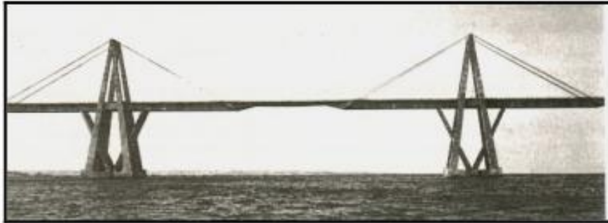
Εικόνα 5: Η πρώτη καλωδιωτή γέφυρα απο σκυρόδεμα στην Βενεζουέλα
