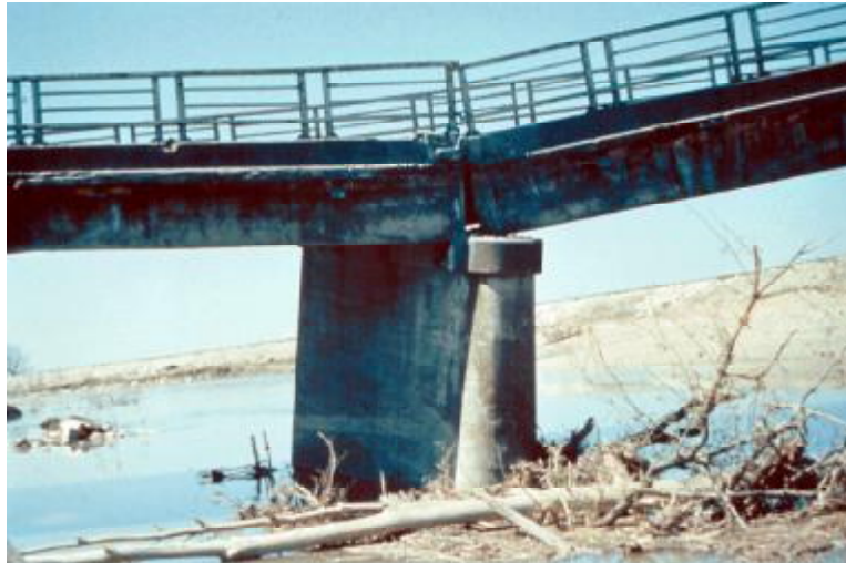
Εικόνα 24: Κατακόρυφη μετακίνηση του μεσόβαθρου
