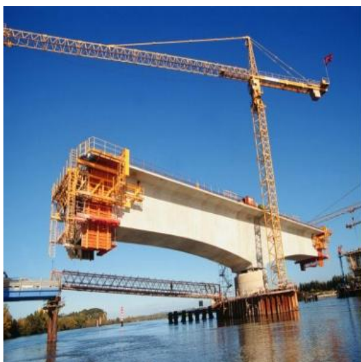
Εικόνα 14: Κατασκευή με την μέθοδο της προβολοδόμησης στην θάλασσα
