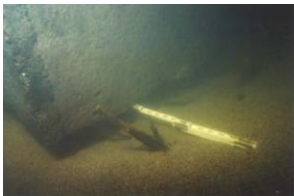
Εικόνα 23: Υποσκαφή ακροβάθρων
