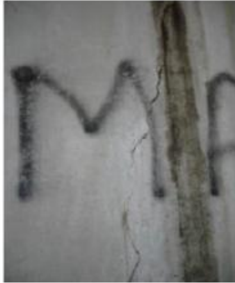
Εικόνα 22: Ρωγμές ακρόβαθρου
