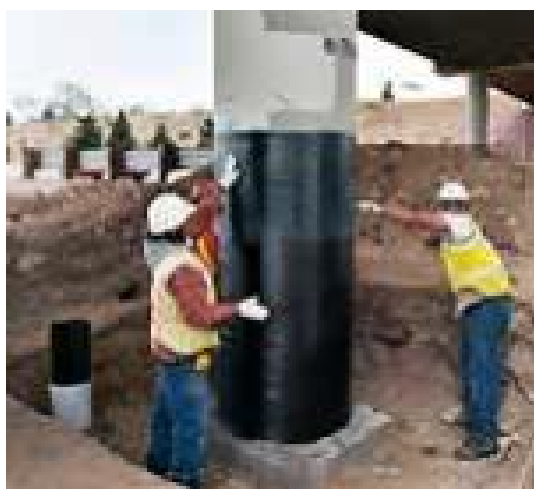
Εικόνα 31: Βασική Τεχνική Εφαρμογής Σύνθετων υλικών σε κυλινδρικό βάθρο γέφυρας
