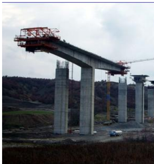
Εικόνα 13: Κατασκευή με την μέθοδο της προβολοδόμησης
