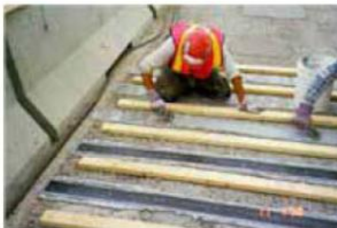
Εικόνα 39: Ενίσχυση καταστρώματος της γέφυρας Country Hills Boulevard
