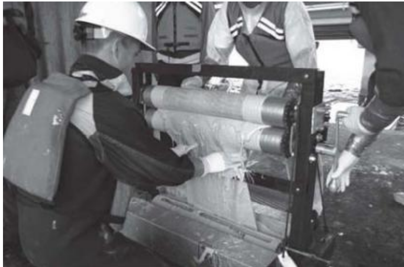
Εικόνα 37: Εφαρμογή και τοποθέτηση FRP κατά το σύστημα wet lay-up
