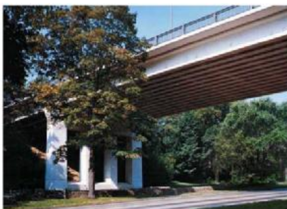
Εικόνα 10: Η Πρώτη γέφυρα από Προεντεταμένο Σκυρόδεμα στις ΗΠΑ
