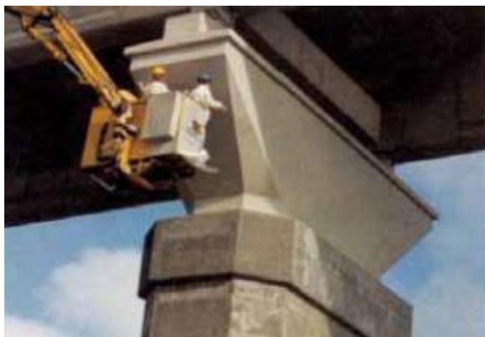
Εικόνα 30: Εφαρμογή Τσιμεντοκονιάματος σε βάθρο γέφυρας
