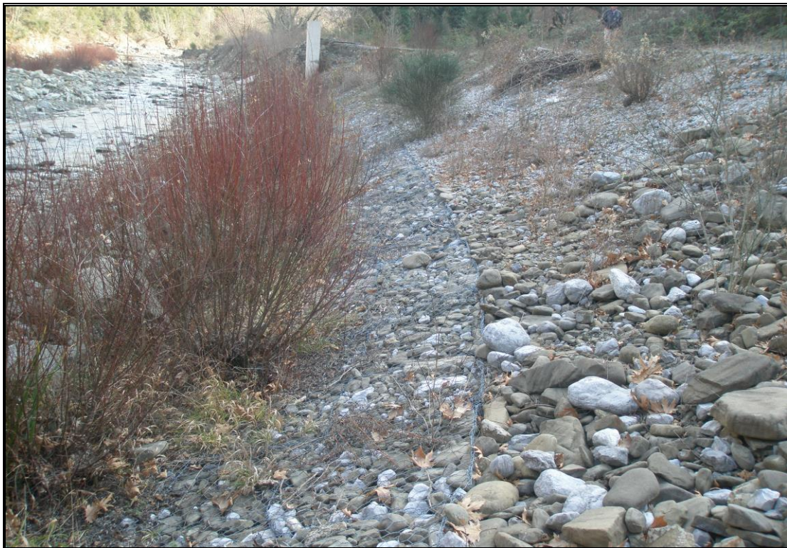
Φωτ. 6.8: Ειδικά διαμορφωμένο πρανές δυτικής όχθης με συρματοπλεγμα.
