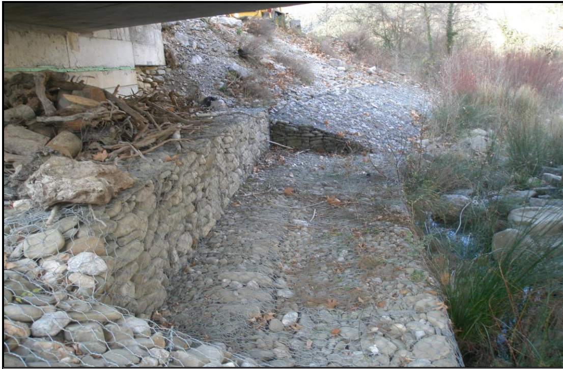
Φωτ. 6.7: Ενίσχυση δυτικής παρειάς με λιθοπλήρωτα συρματοκιβώτια (σαραζανέτια).
