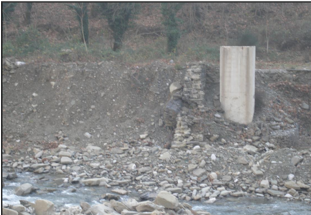
Φωτ. 6.12: Παραμένον ακρόβαθρο προϋπάρχουσας γέφυρας.
