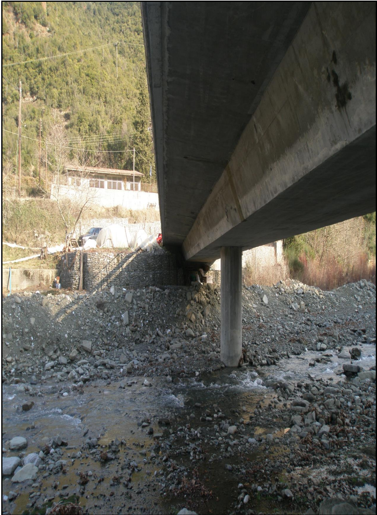
Φωτ. 6.2: Γενική άποψη φορέα μονολιθικής πλαισιακής μορφής από προεντεταμένο σκυρόδεμα.
