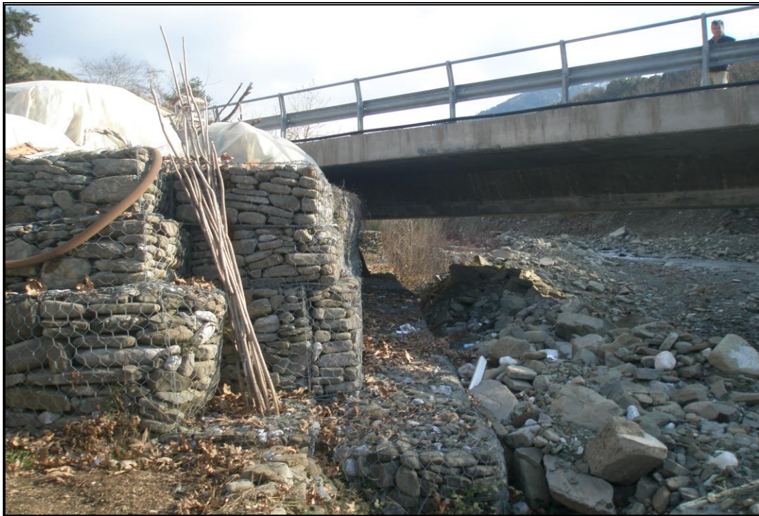
Φωτ. 6.6: Ενίσχυση ανατολικής παρειάς με λιθοπλήρωτα συρματοκιβώτια (σαραζανέτια).
