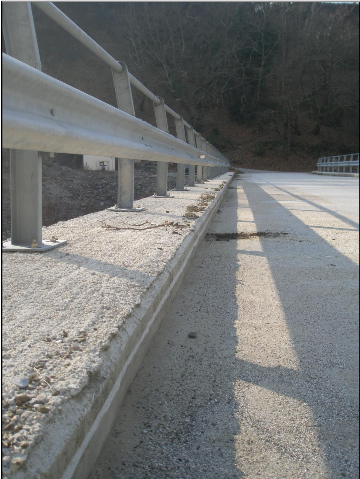
Φωτ. 6.10: Προστατευτικά κικλιδώματα και κράσπεδο.
