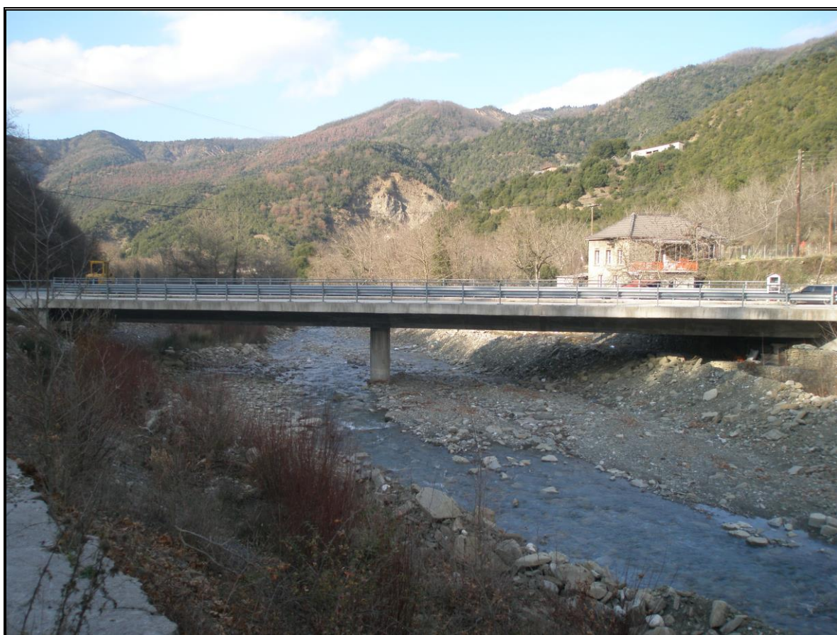
Φωτ. 6.1: Νότια όψη γέφυρας.
