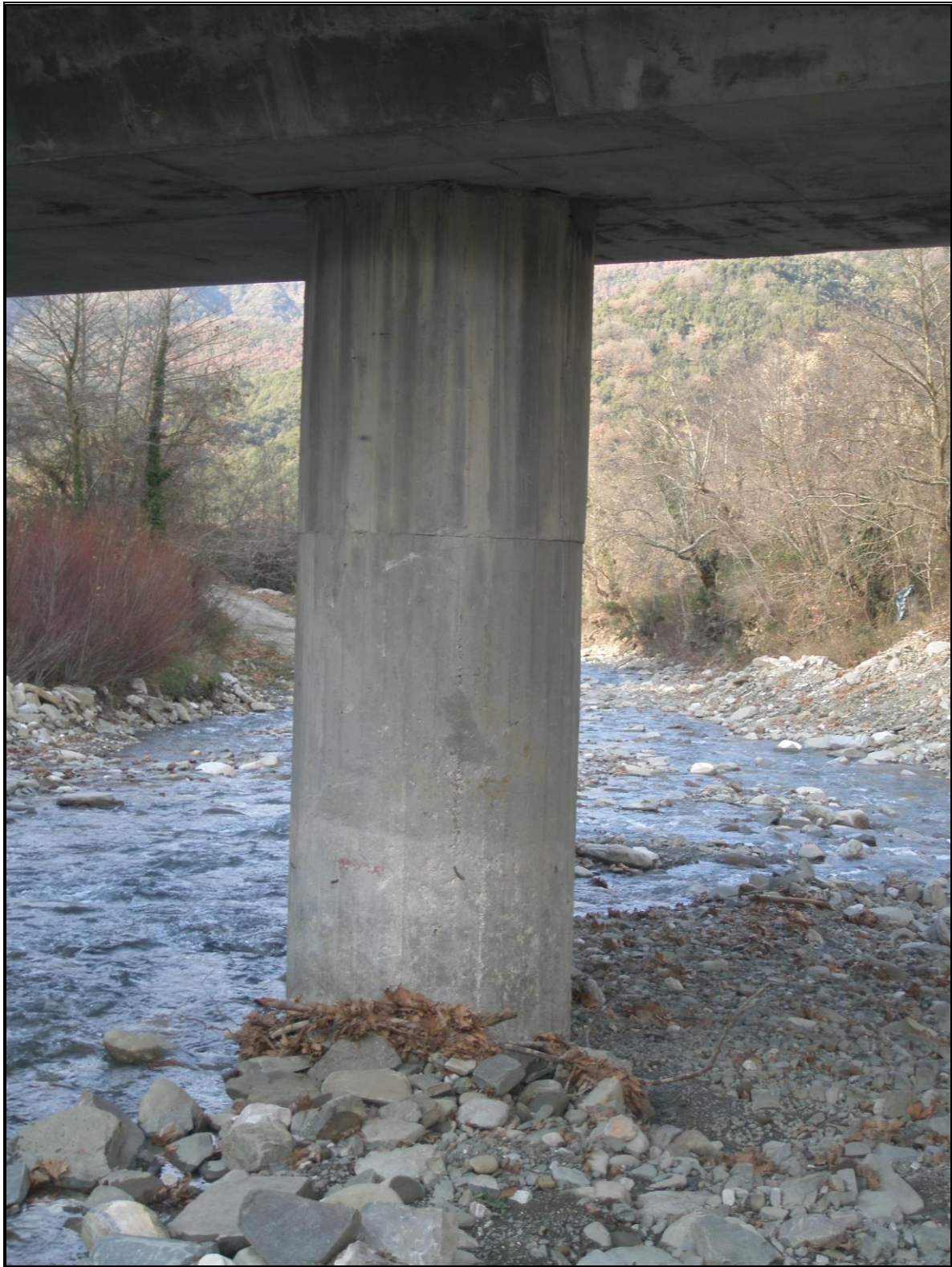
Φωτ. 6.3: Μεσόβαθρο κυκλικής διατομής.
