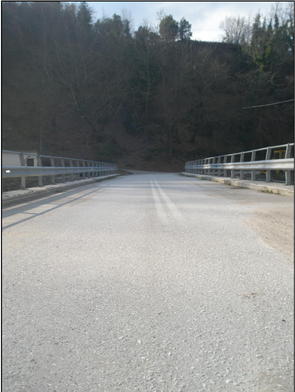
Φωτ. 6.9: Οδόστρωμα γέφυρας.
