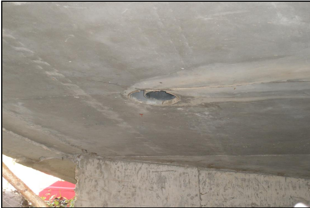
Φωτ. 6.11: Λεπτομέρεια αγωγού αποχέτευσης όμβριων υδάτων καταστρώματος.
