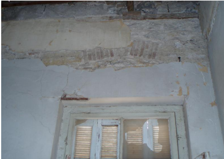
Εικόνα 48:Ανακουφιστικό τόξο σε εξωτερικό άνοιγμα του α' ορόφου
