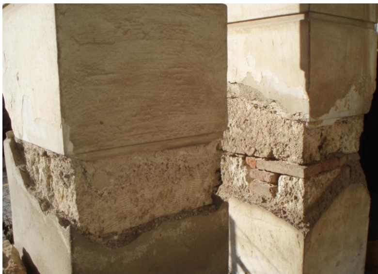
Εικόνα 164: Αποκολλημένα επιχρίσματα από τους κίονες στήριξης του εξώστη
