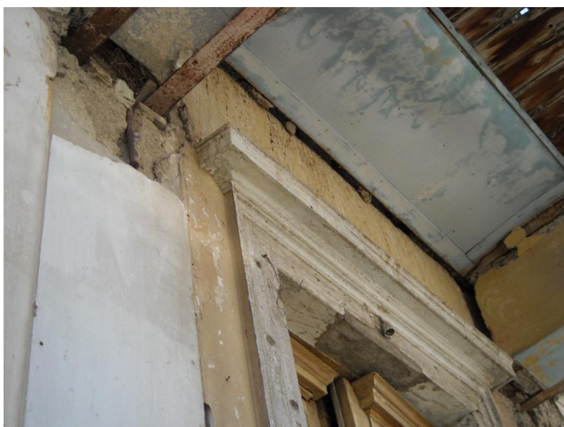
Εικόνα 166: Η οροφή του πρόπυλου της βόρειας όψης του κτιρίου
