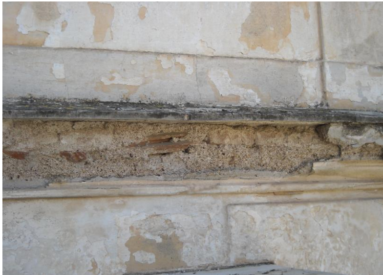
Εικόνα 102:Λεπτομέρεια αποκολλημένου τραβηχτού κονιάματος
