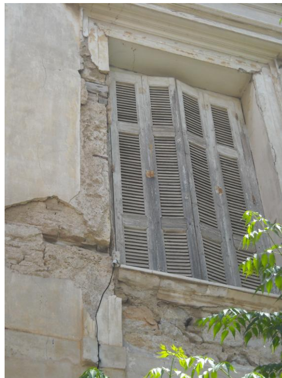
Εικόνα 63: Εξωτερικό κούφωμα α' ορόφου
