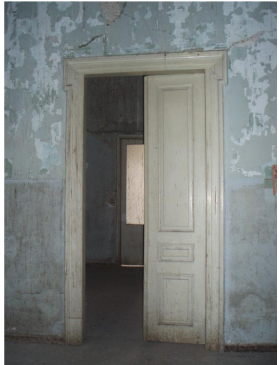
Εικόνα 67:Εσωτερικό κούφωμα του Α' ορόφου
