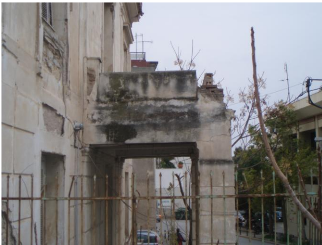
Εικόνα 91:Εμφάνιση μικροοργανισμών και αποκολλημένα επιχρίσματα σε τμήμα του εξώστη
