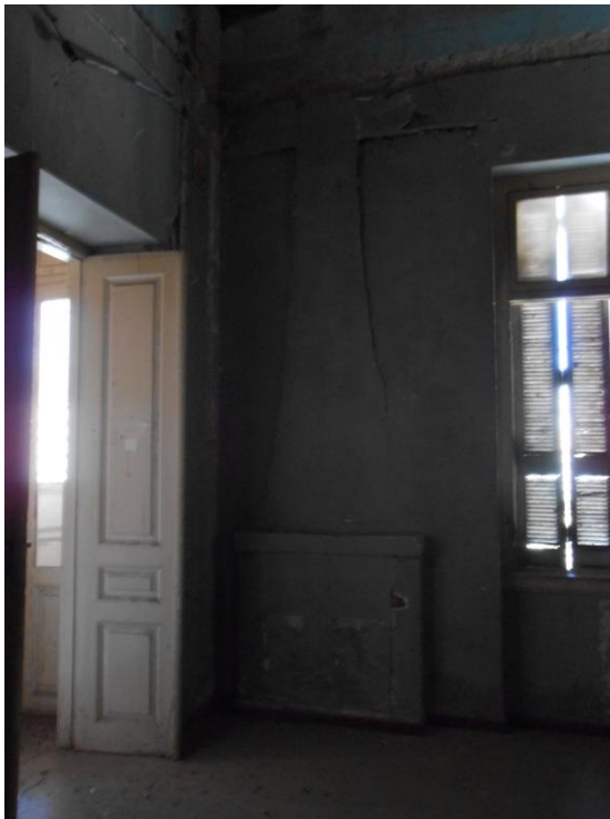
Εικόνα 156:Ο χώρος II8 του α' ορόφου
