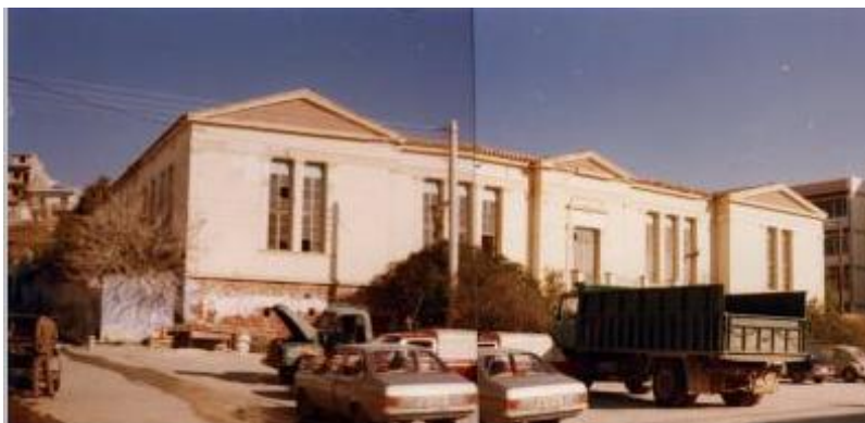
Εικόνα 9: 1 ο Δημοτικό Σχολείο Μεγάρων (Συγγρού) εν καιρώ αποκατάστασης, Νότια όψη
