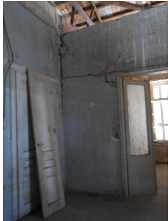
Εικόνα 155:Ο χώρος II3 του α' ορόφου
