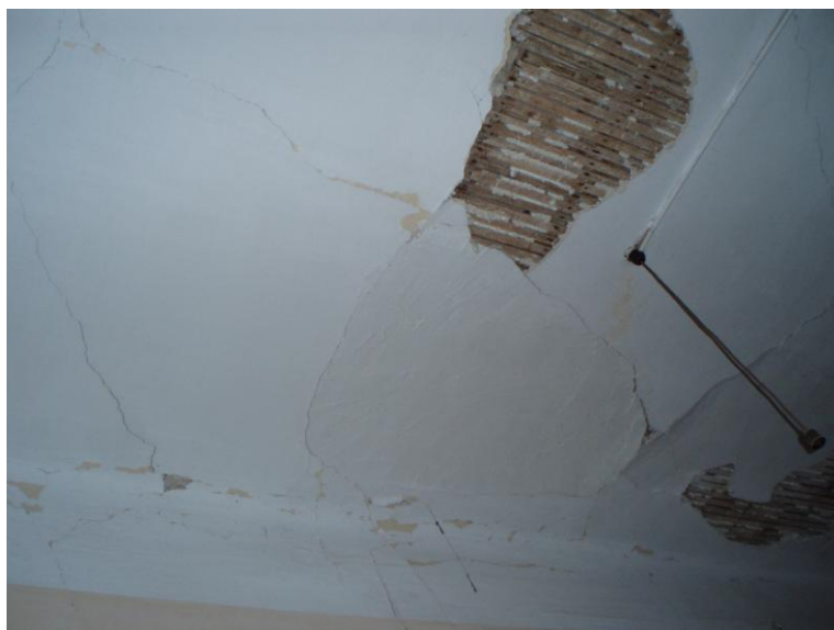
Εικόνα 98:Αποκολλημένο επίχρισμα στην οροφή του ισόγειου
