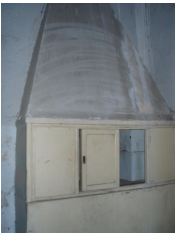
Εικόνα 35: Η εστία στο χώρο II6 του ορόφου
