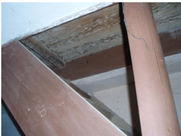
Εικόνα 20: Η κλειστή δίοδος του κλιμακοστασίου προς τον όροφο
