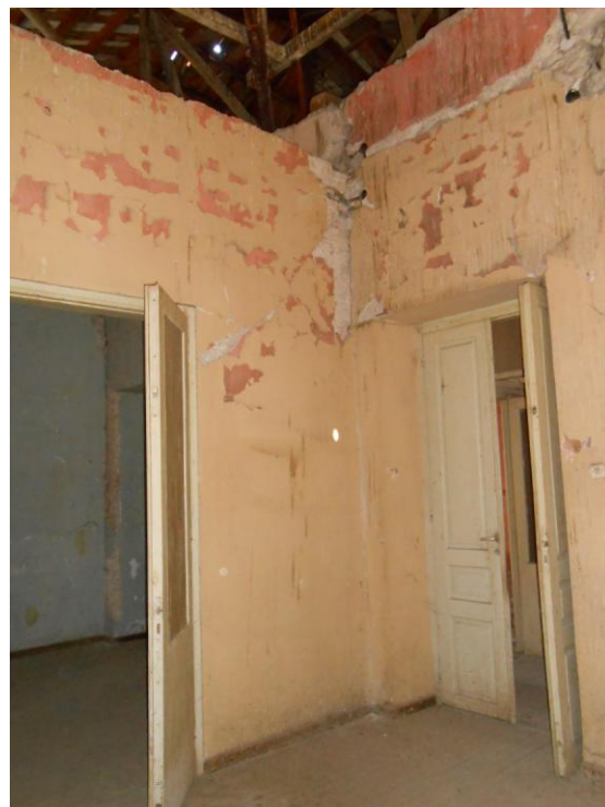
Εικόνα 34: Ο χώρος II4 του ορόφου
