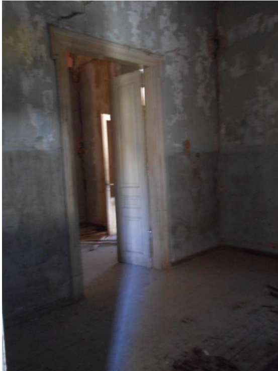
Εικόνα 29:Ο χώρος ΙΙ2 του ορόφου
