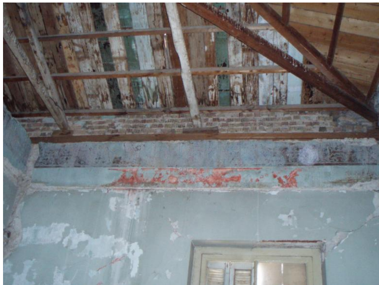
Εικόνα 111:Λεπτομέρεια του α' ορόφου όπου φαίνεται η καθολική καθαίρεση της οροφής
