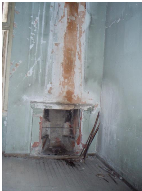
Εικόνα 77: Το τζάκι στο χώρο Π7 του α' ορόφου
