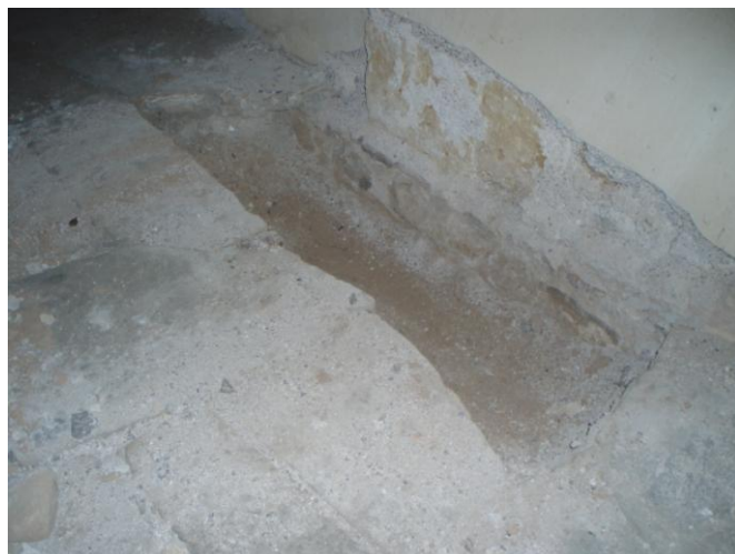
Εικόνα 54:Δοικμαστική τομή στο πάτωμα του χώρου I4 του ισογείου
