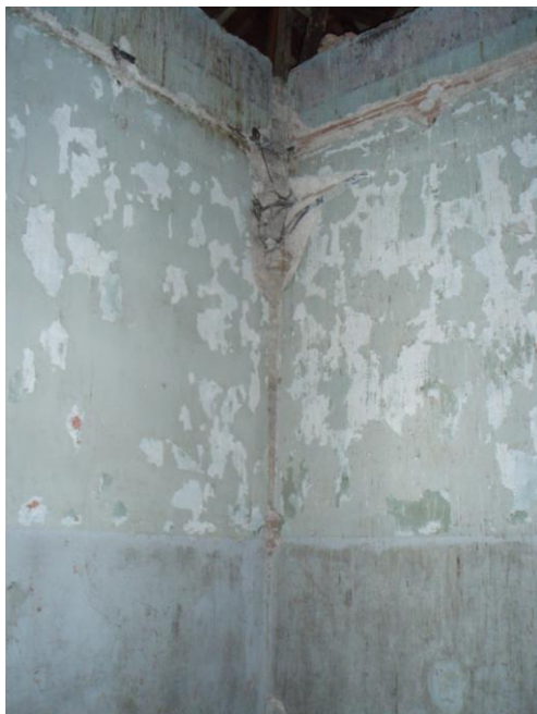
Εικόνα 76: Ηλεκτρολογικές εγκαταστάσεις του α' ορόφου
