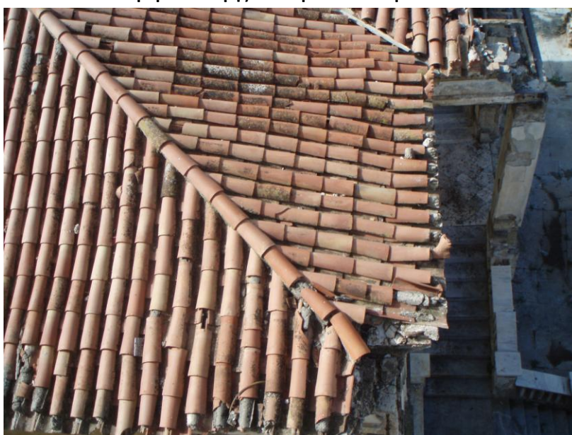
Εικόνα 51:Λεπτομέρεια στέγης εξωτερικά του κτιρίου
