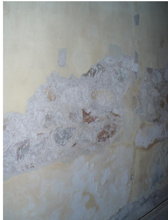
Εικόνα 81: Λεπτομέρεια εξωτερικού τοίχου στο χώρο ΙΙ8 του ισογείου
