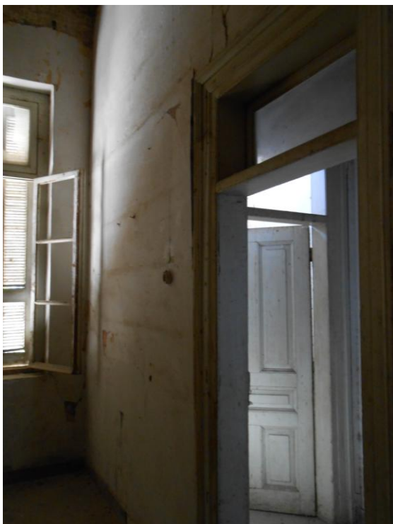
Εικόνα 33: Ο χώρος II6 του ορόφου
