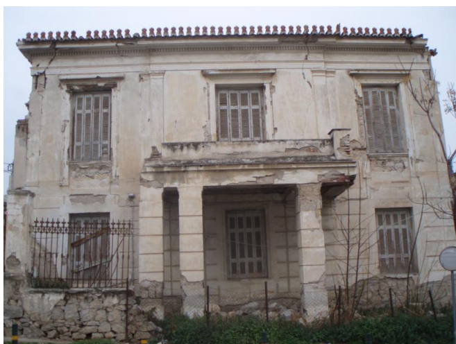
Εικόνα 40:Ανατολική όψη του κτιρίου
