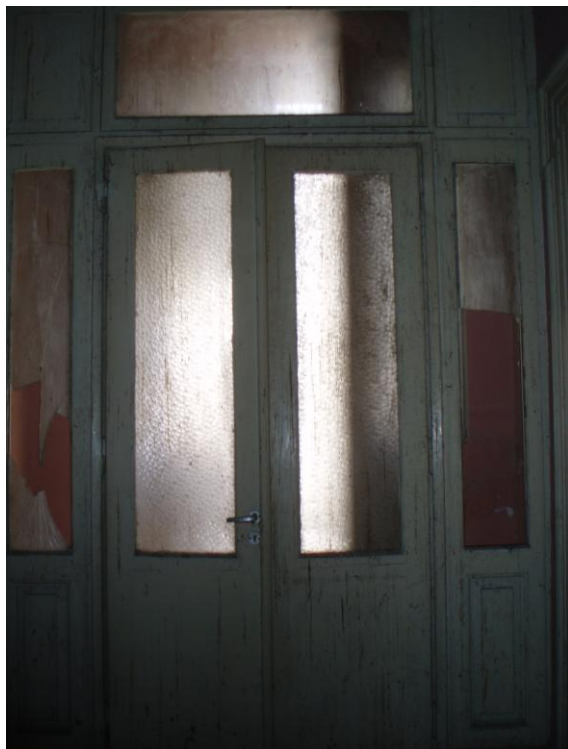
Εικόνα 27: Η είσοδος του ορόφου μέσω αυτού του μικρού προθαλάμου
