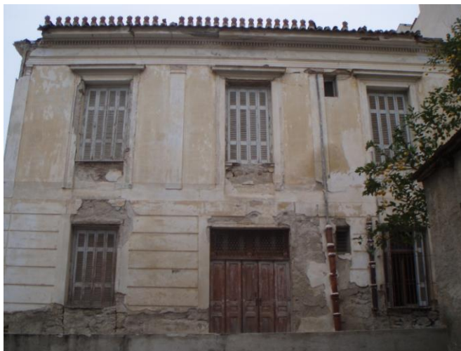
Εικόνα 39:Νότια όψη του κτιρίου
