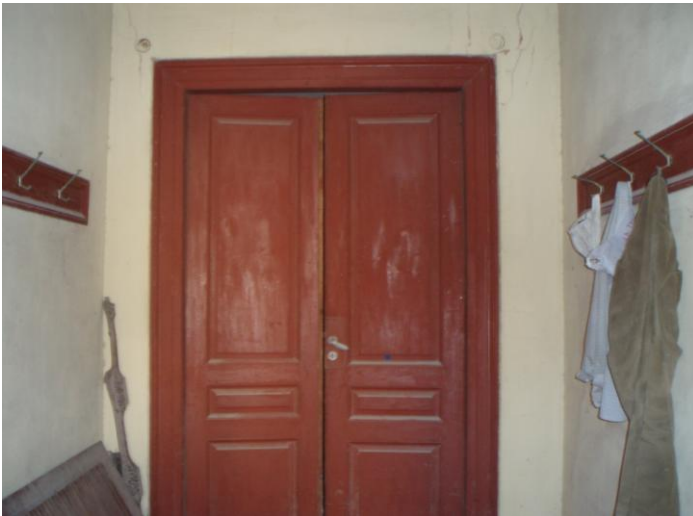
Εικόνα 66:Εσωτερικό κούφωμα του ισογείου
