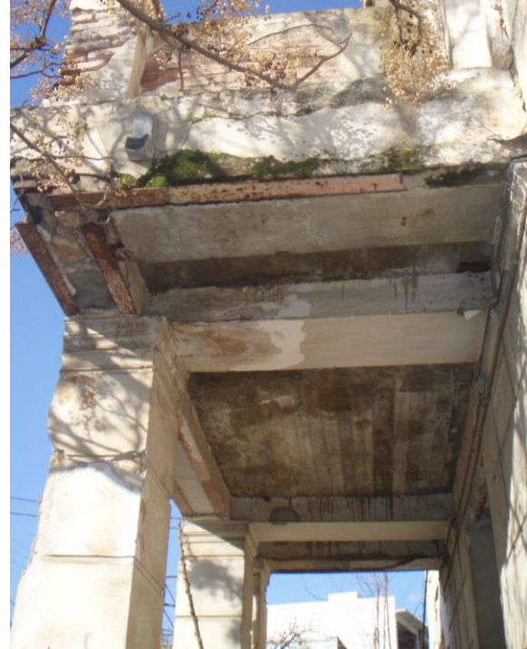
Εικόνα 61:Λεπτομέρεια της οροφής του εξώστη, όπου διακρίνεται η δεύτερη κατασκευαστική φάση του.
