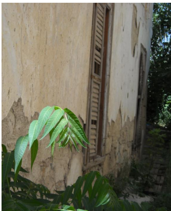
Εικόνα 64: Εξωτερικό κούφωμα ισογείου δυτικής όψης
