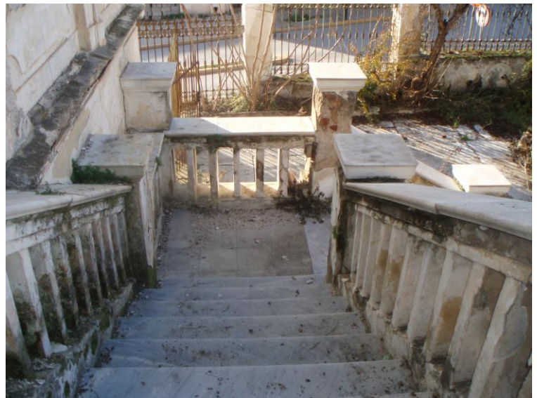
Εικόνα 101:Εμφάνιση μικροοργανισμών στα κιγκλιδώματα του κλιμακοστασίου
