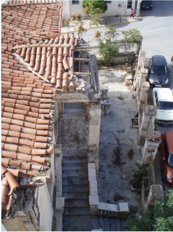
Εικόνα 71: Το κεντρικό κλιμακοστάσιο της πρόσοψης
