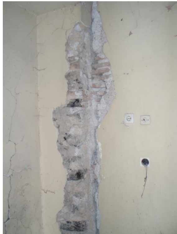
Εικόνα 47:Λεπτομέρεια διαχωριστικού τοίχου του α' ορόφου
