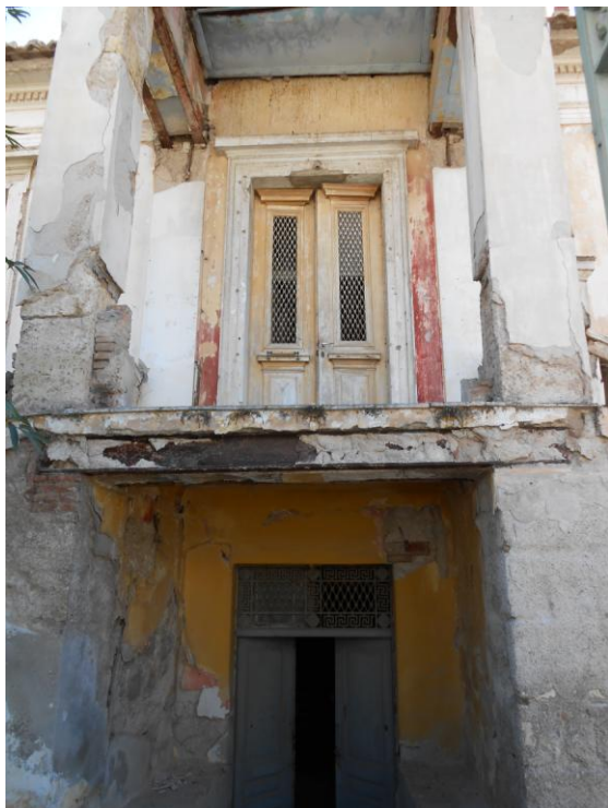
Εικόνα 62: Οι κύριες εισοδοί του κτιρίου (Βόρεια όψη)
