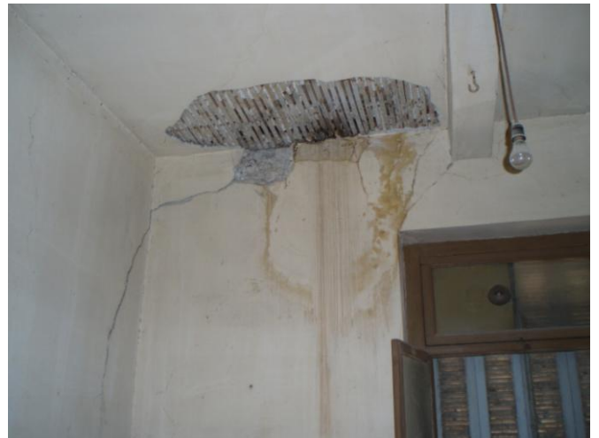
Εικόνα 96: Λεπτομέρεια οροφής και εξωτερικού τοίχου στο χώρο Ι5 του ισογείου
