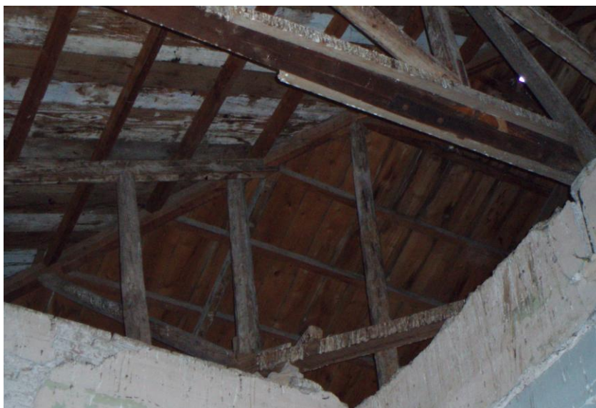
Εικόνα 50:Λεπτομέρεια στέγης εσωτερικά του κτιρίου
