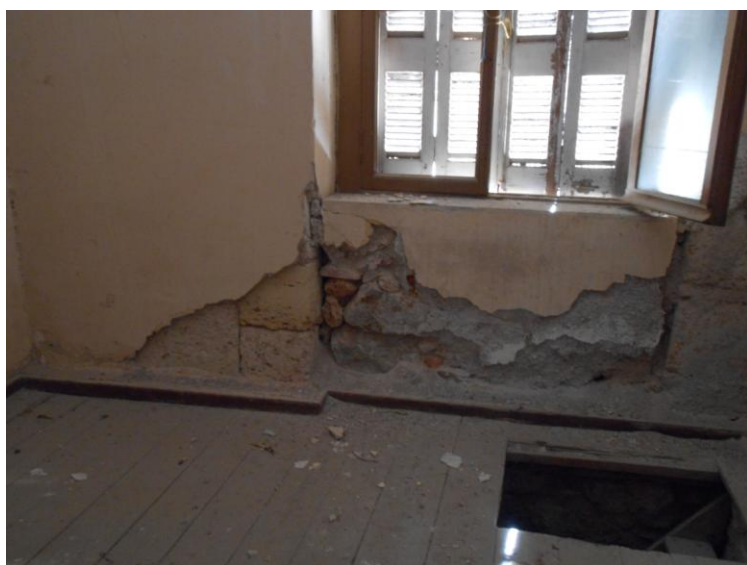
Εικόνα 22: Ο χώρος 16, όπου φαίνεται κι η κρύπτη προς το υπόγειο
