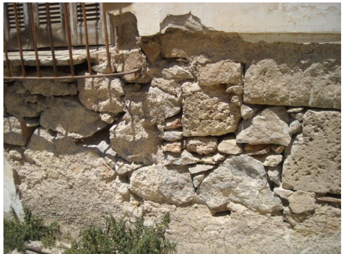
Εικόνα 45: Λεπτομέρεια νότιας όψης
