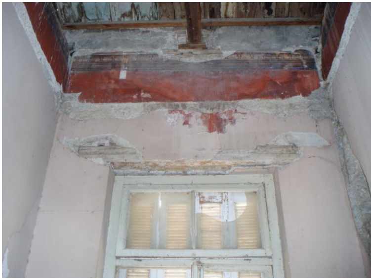
Εικόνα 158: Ο χώρος II5 του α' ορόφου
