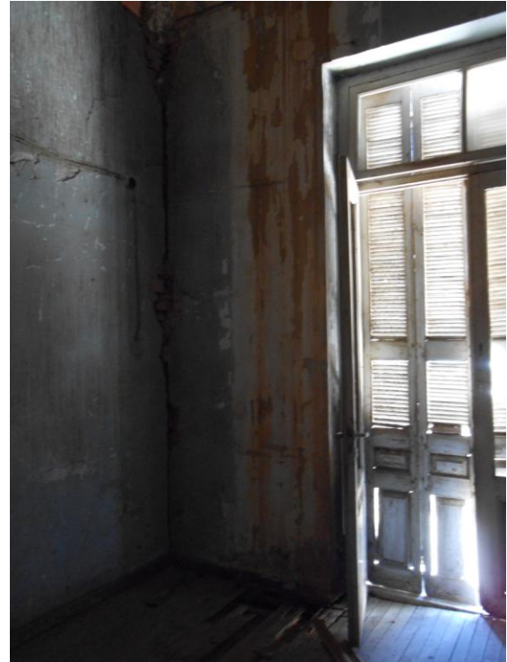
Εικόνα 30:Ο χώρος ΙΙ3 του ορόφου
