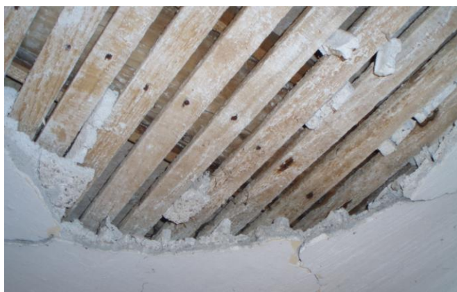
Εικόνα 59:Λεπτομέρεια της οροφής του ισόγειου, όπου διακρίνονται όλα τα δομικά υλικά κατασκευής
