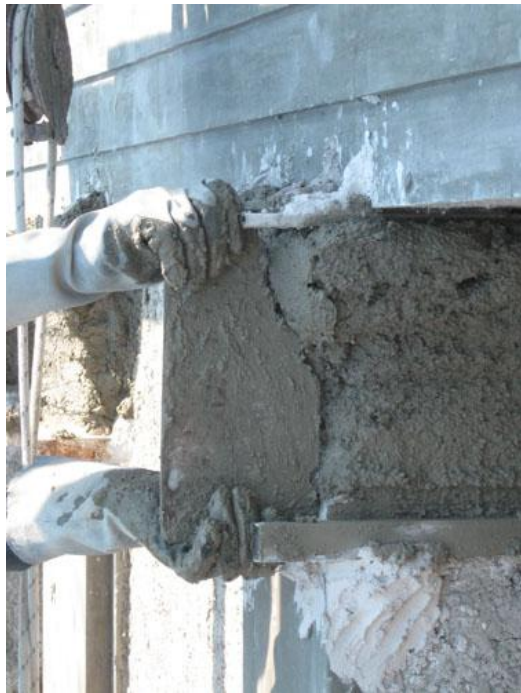
Εικόνα 131:Κατασκευή τραβηχτού κονιάματος
