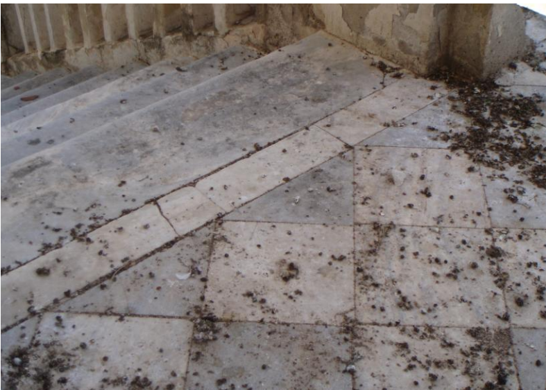
Εικόνα 163:Μαρμάρινες πλάκες επιστρωμένες στην κεντρική κλίμακα του κτιρίου
