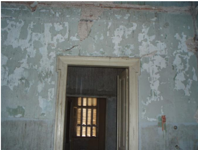
Εικόνα 95: Ρηγματώσεις και κηλίδες στον α' όροφο
