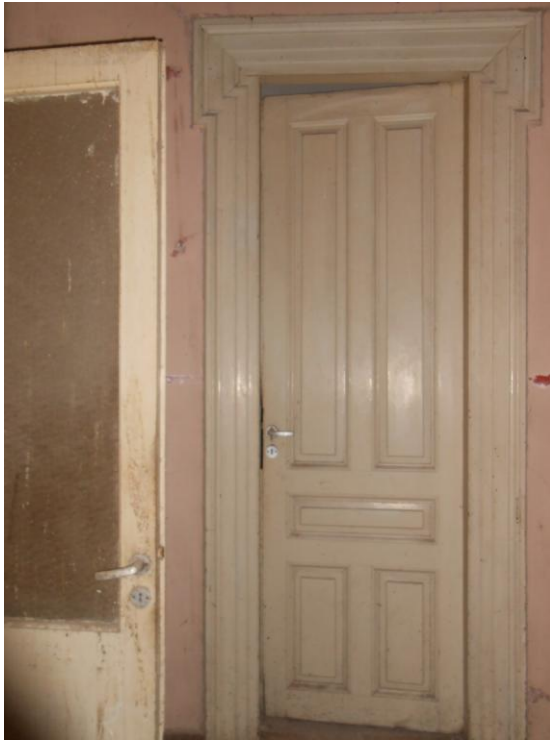
Εικόνα 154:Εσωτερικό κούφωμα του α' ορόφου
