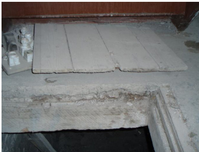
Εικόνα 53:Λεπτομέρεια πατώματος ισογείου, όπου διακρίνεται η αρχική επίστρωση με ξύλινες σανίδες
