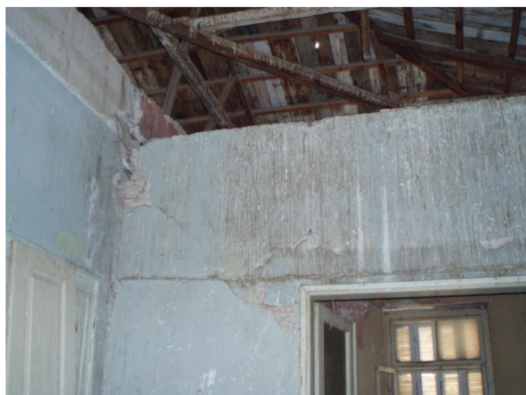
Εικόνα 160: Ο χώρος II3 του α' ορόφου όπου παρατηρείται η υψομετρική διαφορά των τοίχων, συμπεραίνοντας τη διαφορετική φάση κατασκευής τους
