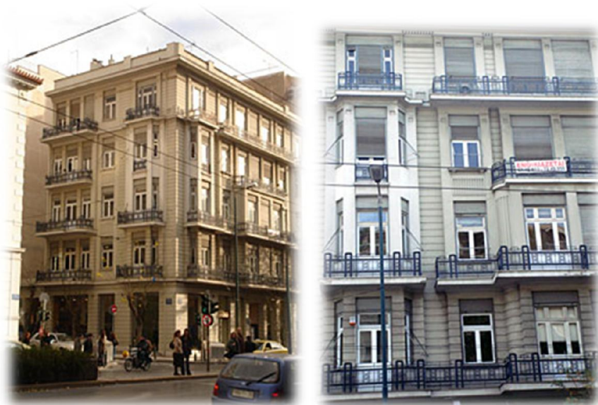
Εικόνα 149, 150 : πολυκατοικία της οδού Πατησίων 64 και Χέυδεν
