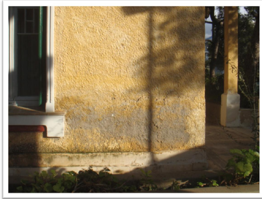
Εικόνα 195: Χαρακτηριστική ζώνη υγρασίας περιμετρικά του κτιρίου
