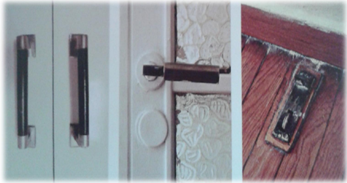
Εικόνα 145 : λεπτομέρειες από τα πόμολα και το στοπ της πόρτας εσωτερικά του διαμερίσματος
