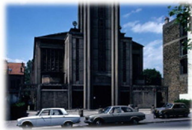
Εικόνα 40: Εξωτερική άποψη του κάτω τμήματος της πρόσοψης του κτιρίου
