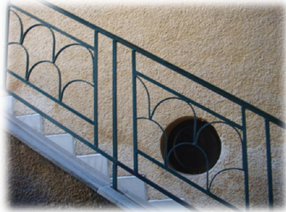
Φεγγίτης στο πίσω μέρος του κτιρίου
