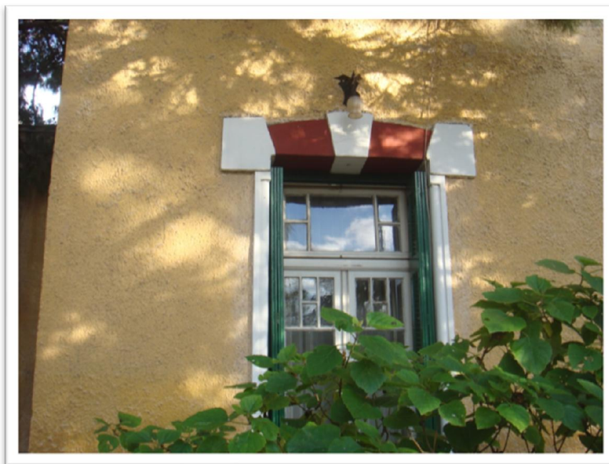
Εικόνα 193: Αποψη των χρωμάτων του κτιρίου και του ανοίγματος στη δυτική όψη του
