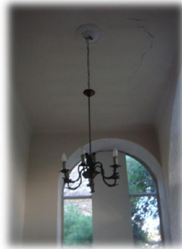
Αποκόλληση σοβά ταβάνι του σπιτιού
