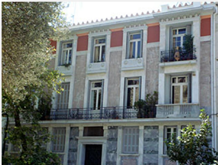
Εικόνα 154: πολυκατοικία της οδού Διονυσίου Αρεοπαγίτου 37
