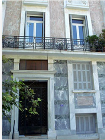
Εικόνα 153: πολυκατοικία της οδού Διονυσίου Αρεοπαγίτου 37
