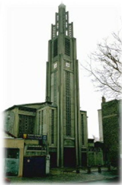
Εικόνα 39: Εξωτερική άποψη του κτηρίου στην πρόσοψη του
