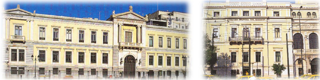
Εικόνα 106: Αθήνα. Το κεντρικό κτίριο της Εθνικής Τράπεζας, με το ανάγλυφά του.
