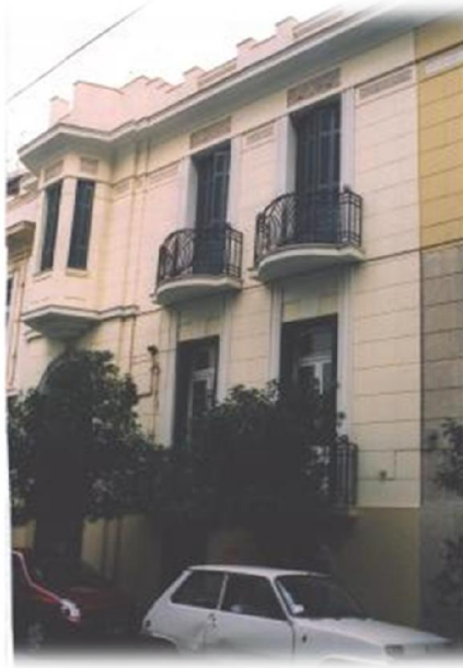
Εικόνα 197: Όψη κτιρίου στα Πατήσια
