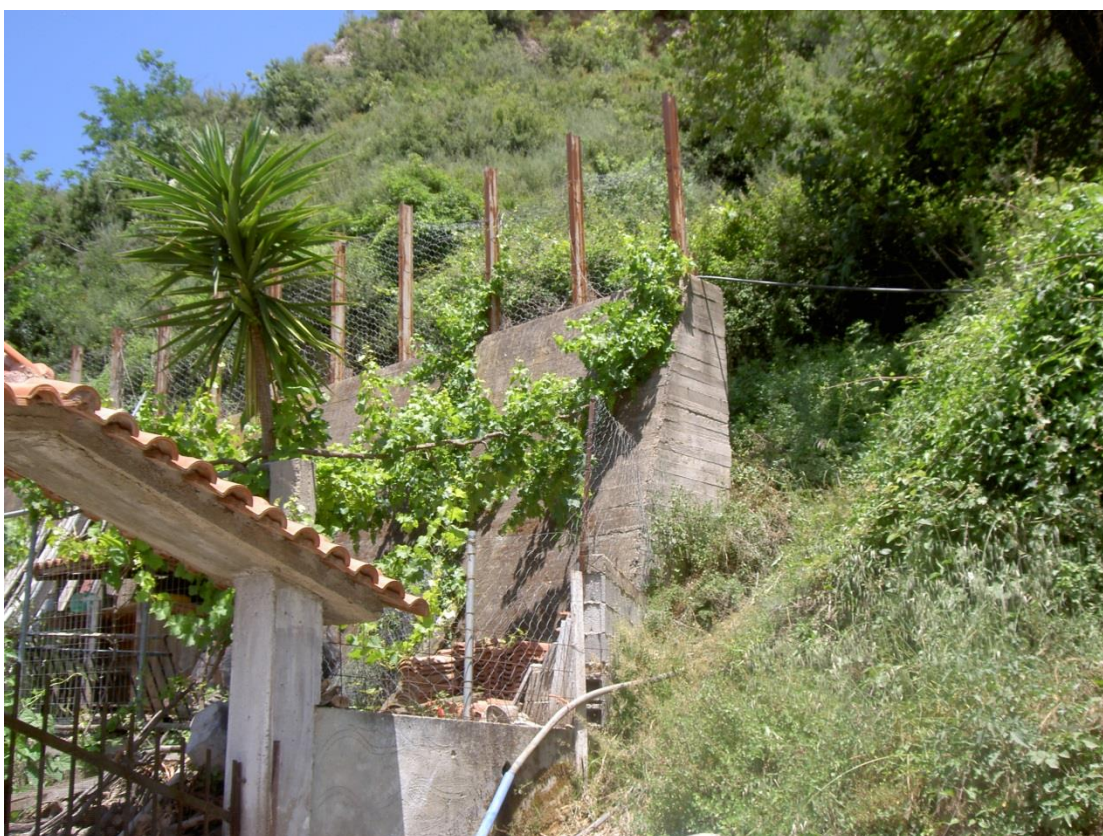
Εικόνα 8: Άποψη του μεταλλικού φράχτη που κατασκευάστηκε πάνω στον υφιστάμενο τοίχο.
