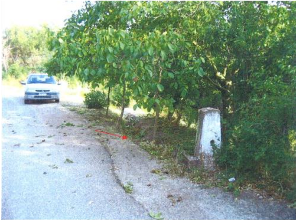
Φωτ. 5: Υπάρχουσα τσιμεντένια αύλακα για την απορροή των ομβρίων κατά μήκος του δρόμου που καταλήγει στις παρυφές της μισγάγγειας.[13]
