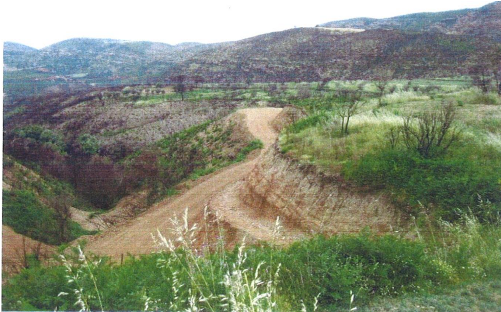
Φωτ. 8. Υψηλό πρηνές του περιμετρικού δρόμου που περιλαμβάνει τη διαμόρφωση αναβαθμών.[13]
