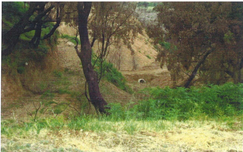
Φωτ. 9. Επίχωμα του περιμετρικού δρόμου με την κατασκευή οχετού στη βάση του.[13]
