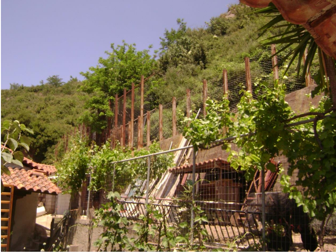
Εικόνα 5: Αποψη του μεταλλικού φράχτη που έχει κατασκευαστεί για την προστασία της οικίας από τις καταπτώσεις.
