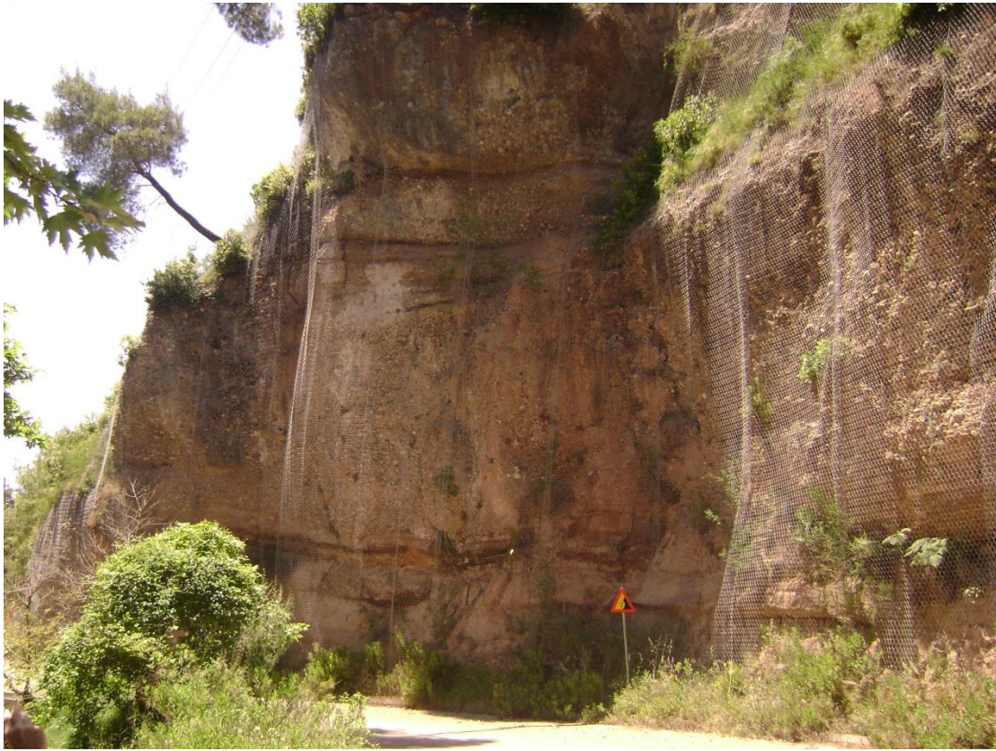
Εικόνα 3: Επένδυση απότομου πρανούς με πλέγμα συγκράτησης καταπτώσεων.
