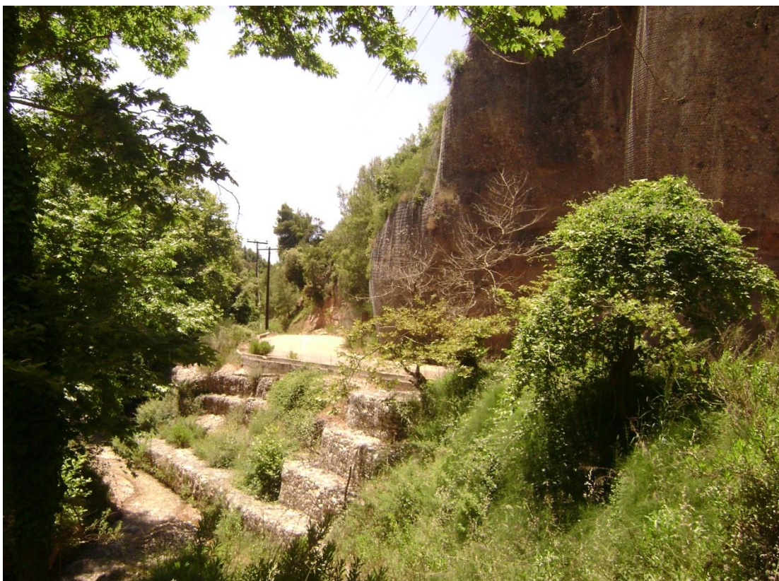
Εικόνα 1: Προστασία της οδού από την διάβρωση του ρέματος με συρματοκιβώτια και από τις καταπτώσεις με τοποθέτηση γαλβανισμένο πλέγματος συγκράτησης αυτών.
