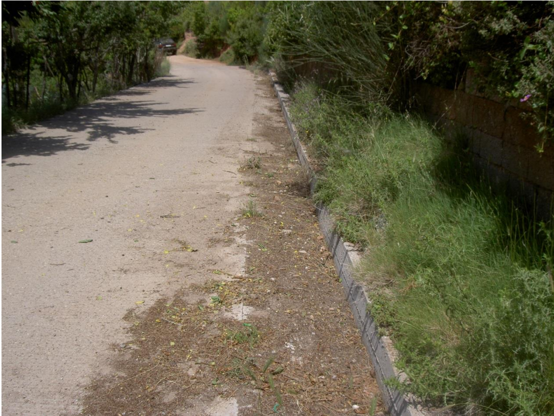
Εικόνα 9: Αποψη από την κατασκευασθείσα τριγωνική επιφανειακή επενδεδυμένη τάφρο στο ανάντη όριο της οδού.
