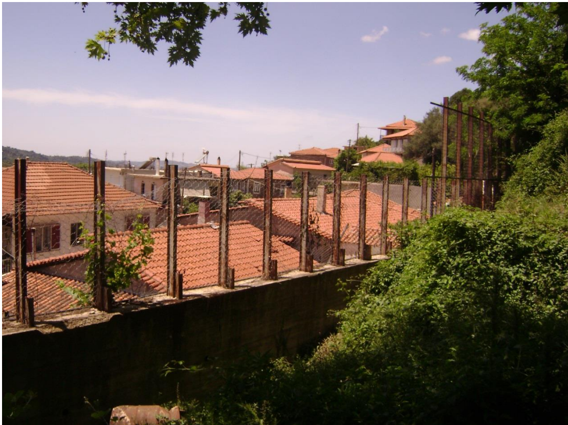
Εικόνα 6: Αποψη του μεταλλικού φράχτη από το πίσω μέρος.
