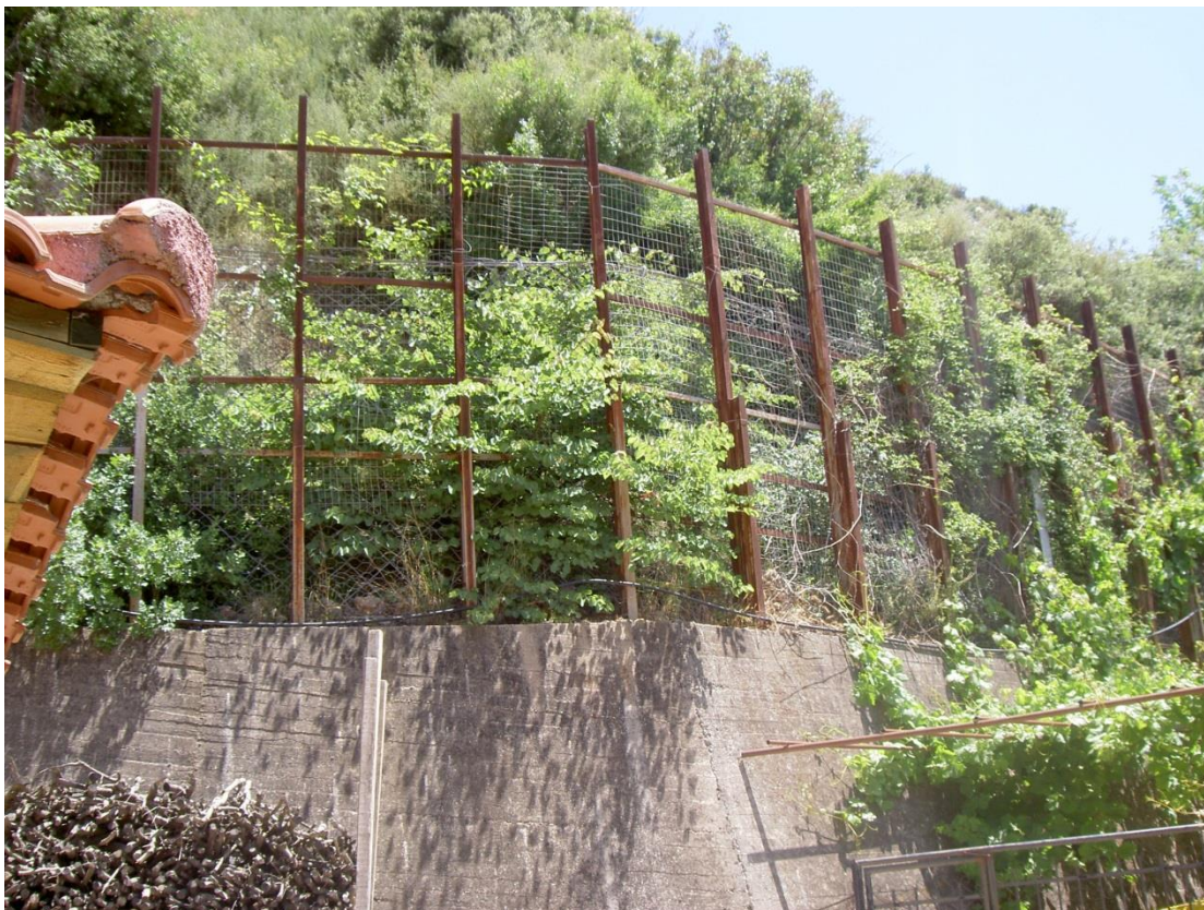
Εικόνα 7: Άποψη του μεταλλικού φράχτη που κατασκευάστηκε πάνω στον υφιστάμενο τοίχο.
