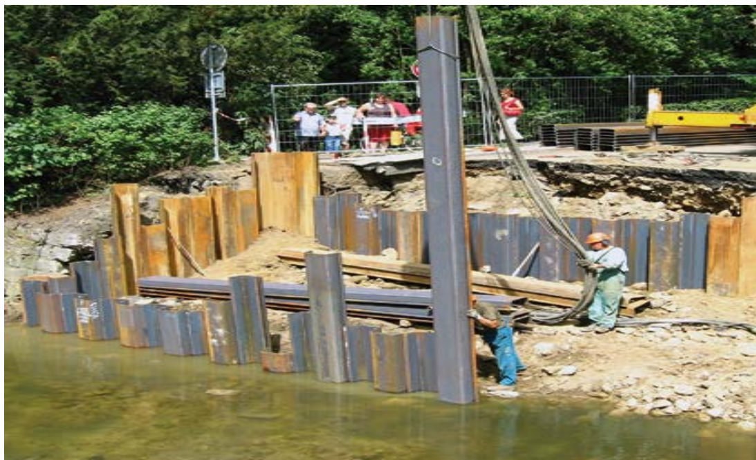
Εικόνα 4.13: Εργασίες τοποθέτησης πασσάλων υπό το νερό.
