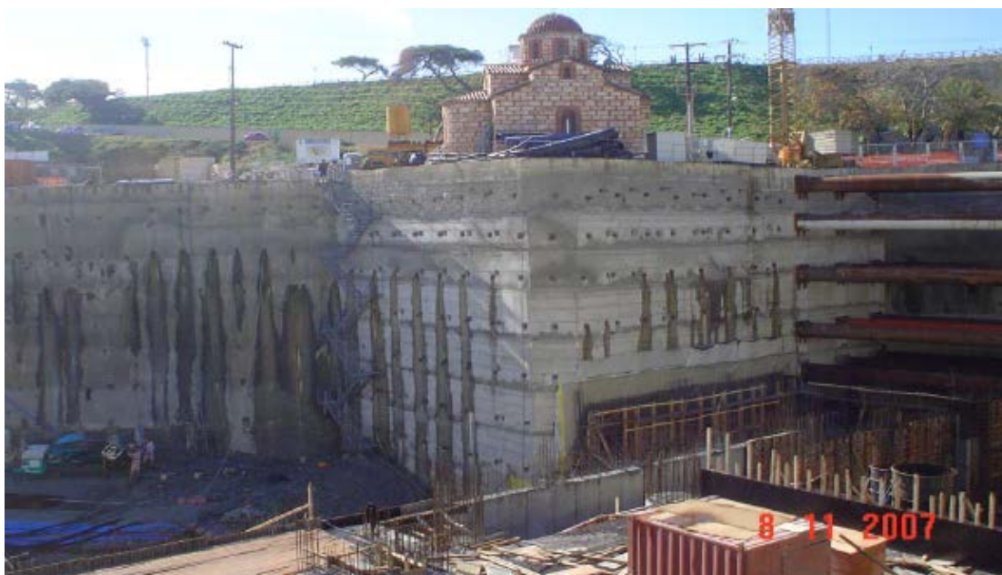
Εικόνα 3.1: Κατασκευή τοίχου αντιστήριξης.
