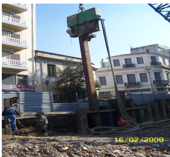
Εικόνα 4.14: Έμπηξη πασσαλοσανίδας.
