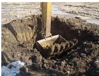
Εικόνα 1.1: Εκσκαφή σε τεχνικό έργο.
