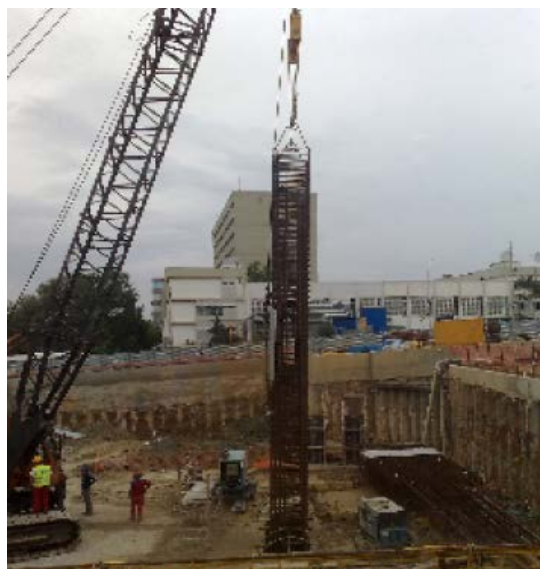
Εικόνα 4.6: Τοποθέτηση κλωβών οπλισμού
