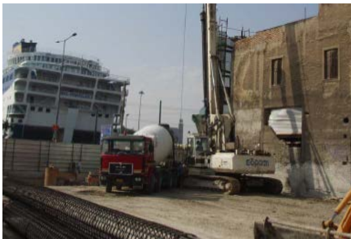
Εικόνα 4.7: Σκυροδέτηση διαφραγματικού τοίχου
