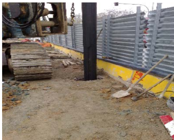
Εικόνα 4.2: Διάτρηση πασσάλων
