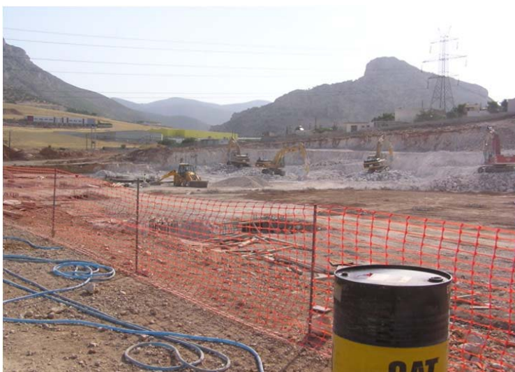
Εικόνα 6.11: Χωματουργικές εργασίες διαμόρφωσης πρανούς στην ανατολική πλευρά του κτιρίου
