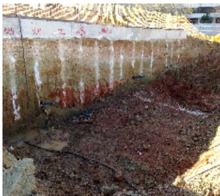
Εικόνα 4.1.: Προσωρινή κατασκευή πασσάλων για αντιστήριξη
