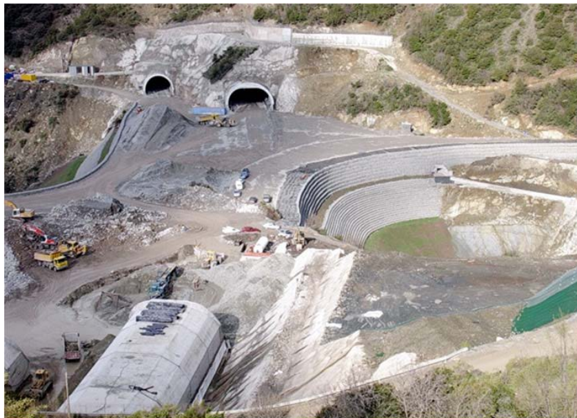
Εικόνα 6.16: Δυτική άποψη επιχώματος
