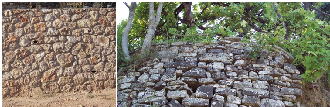
Εικόνα 3.2: Τοίχοι από λιθοδομή
