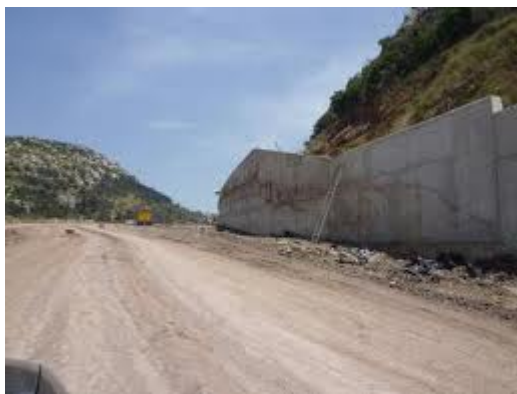
Εικόνα 1.4: Κατασκευή έργου αντιστήριξης.
