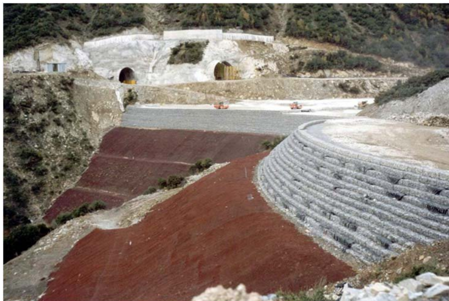
Εικόνα 6.18: Οπλισμένη γη στην ανώτερη υψομετρικά βαθμίδα
