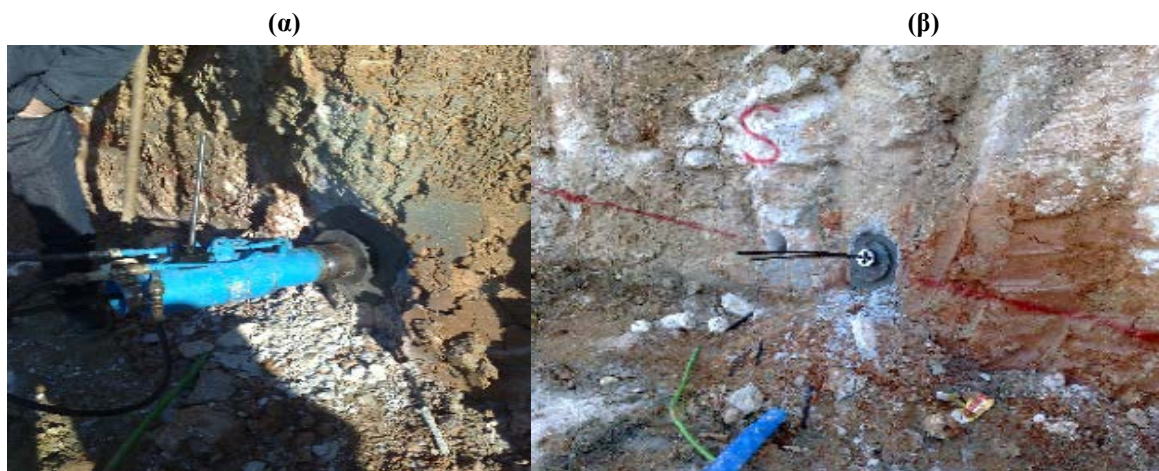
Εικόνα 3.9: (α) Τοποθέτηση αγκυρίου τοίχου αντιστήριξης (β) Αγκύριο
