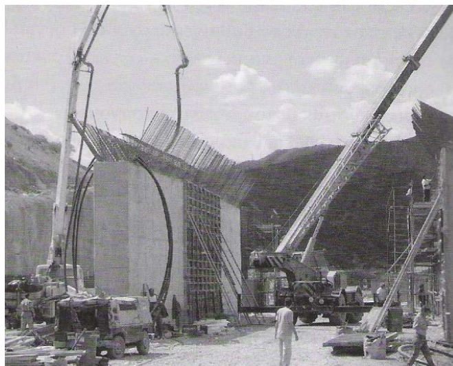
Εικόνα 5.12: Κατασκευή φορέα σήραγγας «cut and cover».
