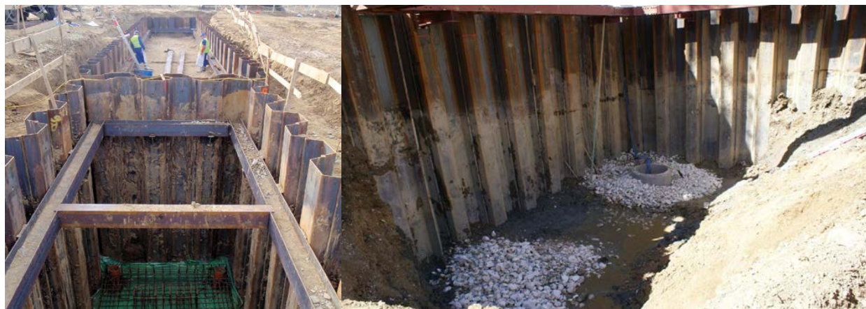
Εικόνα 4.15: (α) Αντιστηριζόμενη εκσκαφή με πασσαλότοιχο (β) Τμήμα πασσαλότοιχου
