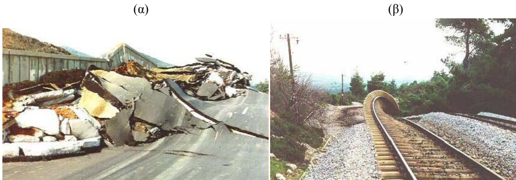
Εικόνα 2.14: Εικόνες κατολίσθησης. (α) σε εθνική οδό και (β) σε σιδηροδρομική γραμμή.
