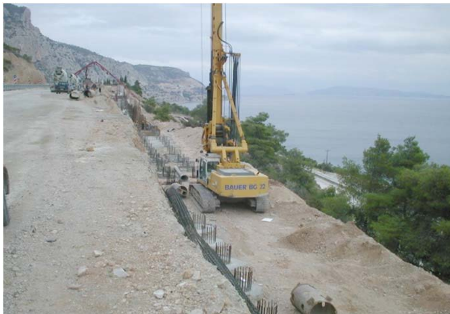
Εικόνα 6.1: Κατασκευή τοίχου αντιστήριξης αυτοκινητοδρόμου.
