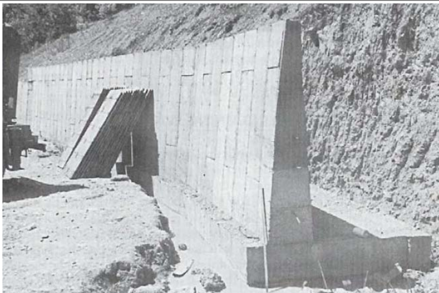
Εικόνα 3.4: Τοίχος από οπλισμένο σκυρόδεμα.
