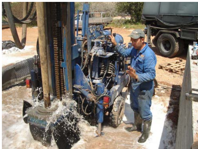
Εικόνα 1.6: Πραγματοποίηση γεώτρησης για τη διερεύνηση του υπεδάφους.
