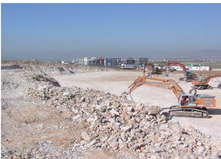
Εικόνα 6.12: Γενική άποψη του χώρου κατασκευής του κτιρίου
