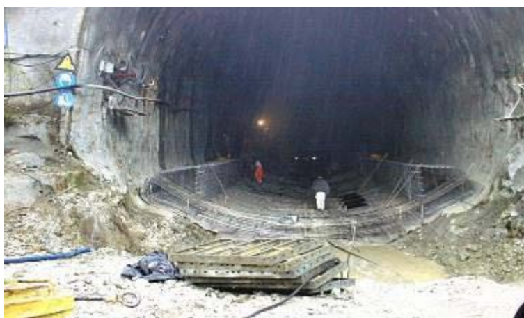
Εικόνα 5.16: Τοποθέτηση σπλισμού ανεστραμμένου τόξου.
