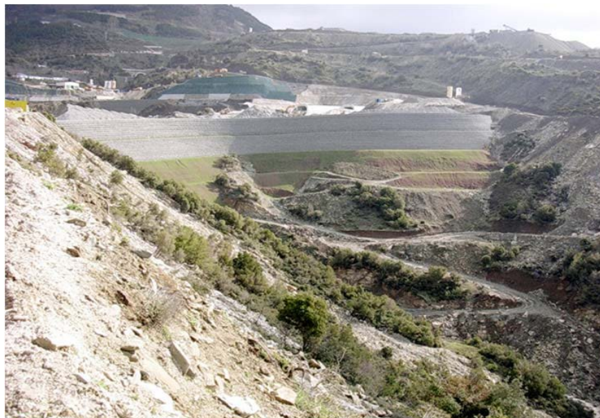
Εικόνα 6.17: Νότια άποψη του επιχώματος
