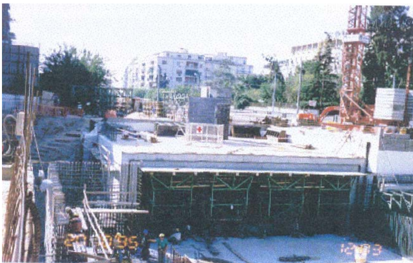
Εικόνα 5.9: Αττικό μετρό, μέθοδος cut and cover.
