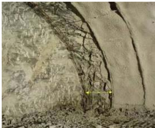
Εικόνα 5.15: Πτωχή ποιότητα βραχώμαζας – μικρό βήμα εκσκαφής.
