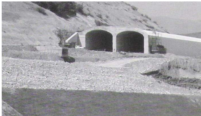
Εικόνα 5.10: Σήραγγα «cut and cover» σε φάση κατασκευής.
