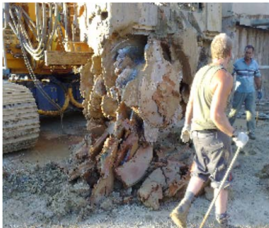
Εικόνα 4.4: Όδοντες κοπτικού υδρόφρεζας
