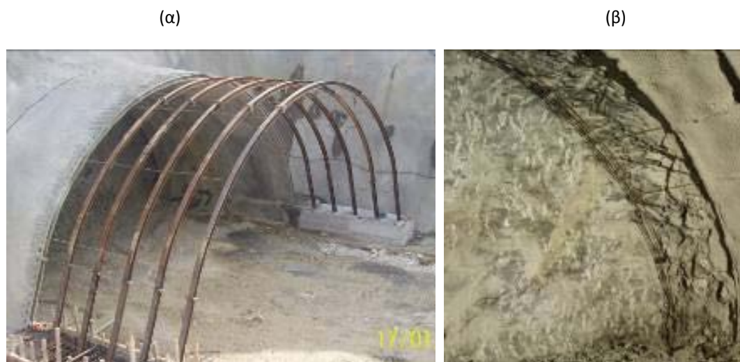
Εικόνα 5.19: (α) Χαλύβδινες νευρώσεις, (β) Δικτυωτό πλαίσιο.
