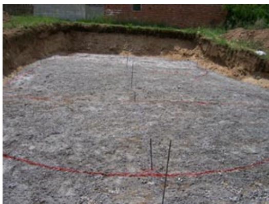
Εικόνα 1.2: Διαδικασία πραγματοποίησης επιφανειακής εκσκαφής σε τεχνικό έργο.
