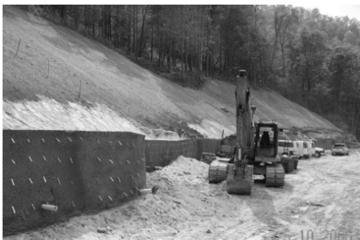
Εικόνα 2.1: Φυσικό πρανές σε έργο οδοποιίας.
