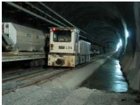
Εικόνα 5.2: Σήραγγα που θα χρησιμοποιηθεί ως αγωγός υδάτων.
