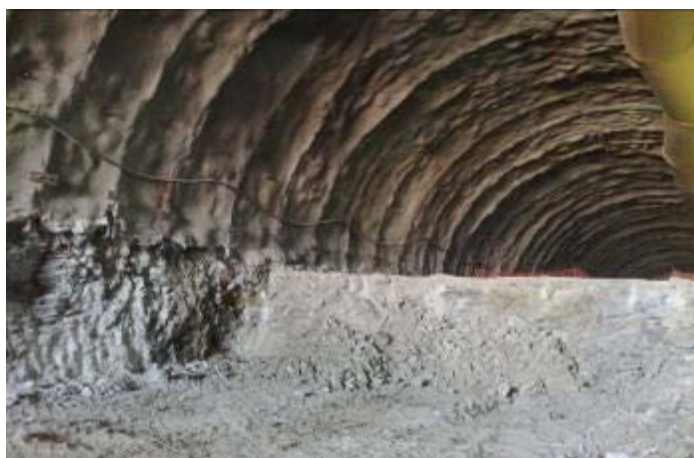
Εικόνα 5.14: Εκσκαφή σήραγγας σε δύο φάσεις.
