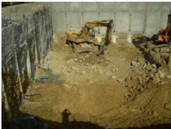
Εικόνα 1.3: Διαδικασία πραγματοποίησης βαθιάς εκσκαφής σε τεχνικό έργο.
