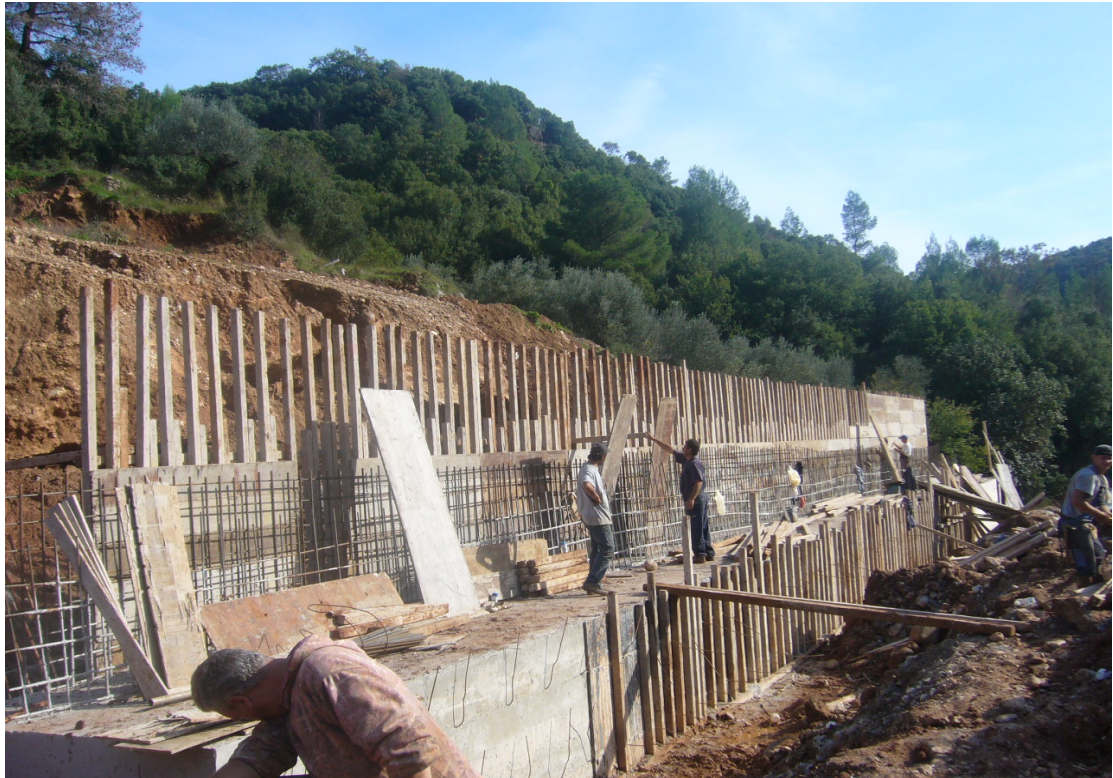
ΦΩΤ 15. Κατασκευή ξυλοτύπου τοίχου αντιστήριξης.
