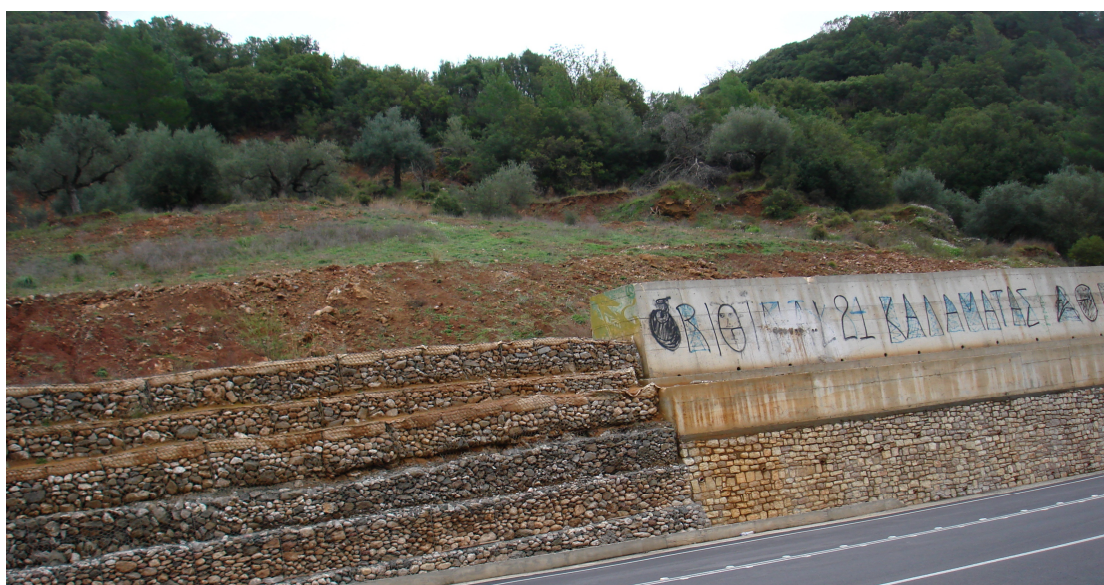
ΦΩΤ 14. Το έργο ολοκληρωμένο - συρματοκιβώτια (σαρζανέτια) που λειτουργούν ως τοίχοι αντιστήριξης.
