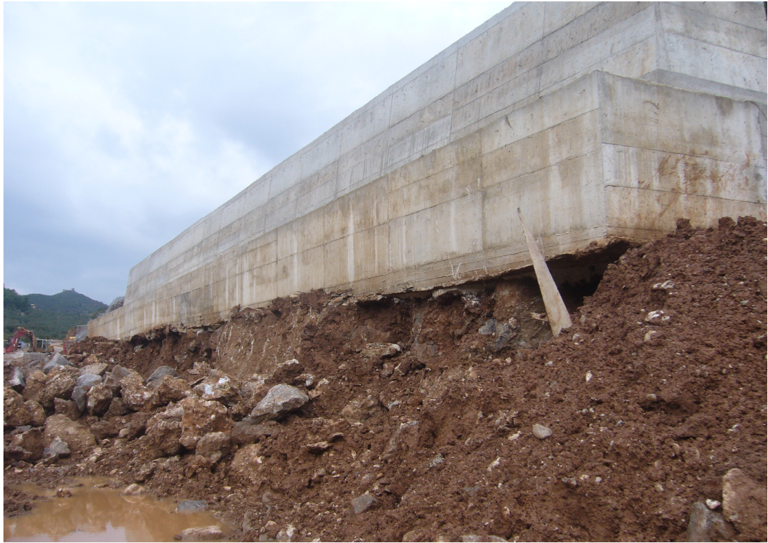
ΦΩΤ 17. Αφαίρεση μέρους προσωρινού επιχώματος.
