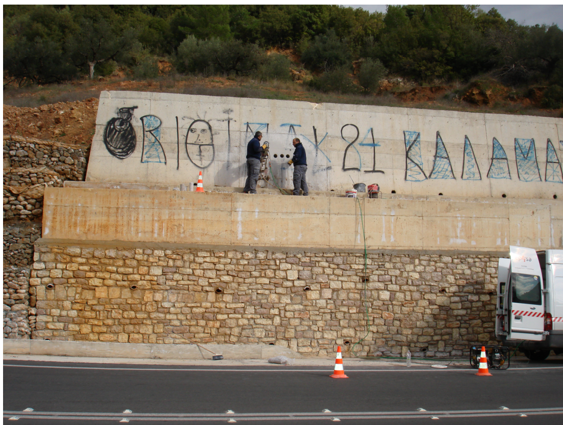
ΦΩΤ 13. Λήψη δοκιμών σκληρυμένου σκυροδέματος (καρότα) για τον έλεγχο της αντοχής του τοίχου αντιστήριξης που είναι πακτωμένος στον κεφαλόδεσμο.
