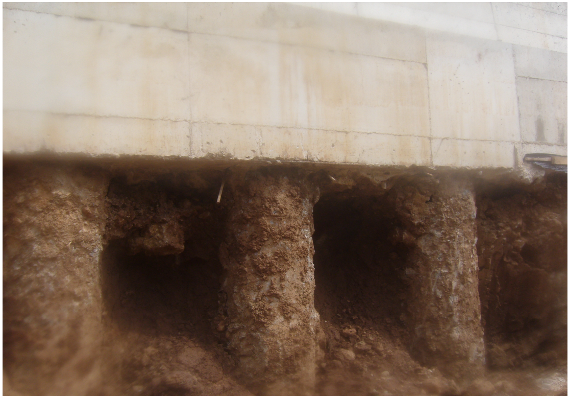
ΦΩΤ 18. Οι πύσσαλοι θεμελίωσης πριν την κατασκευή της πρόσοψης.
