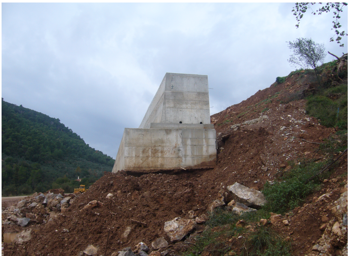
ΦΩΤ 16. Ο τοίχος πριν την αφαίρεση του προσωρινού επιχώματος.
