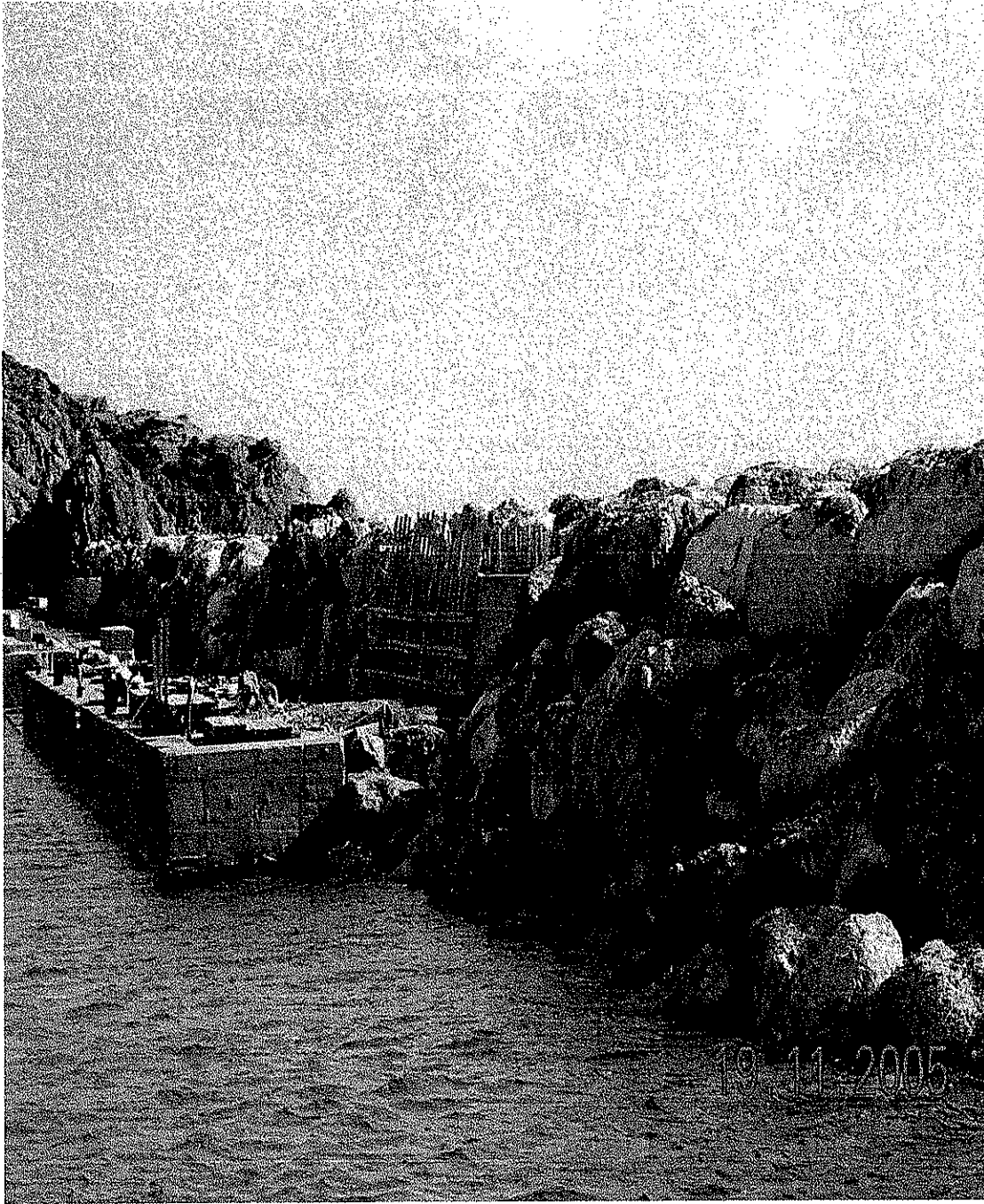
ΑΠΟΨΗ ΑΠΟ ΤΗΝ ΚΑΤΑΣΚΕΥΗ ΤΟΥ ΠΡΟΣΗΝΕΜΟΥ ΜΩΛΟΥ ΜΕ ΤΗΝ ΤΟΠΟΘΕΤΗΣΗ Τ.Ο.(ΤΕΧΝΗΤΩΝ ΟΓΚΟΛΙΘΩΝ)
