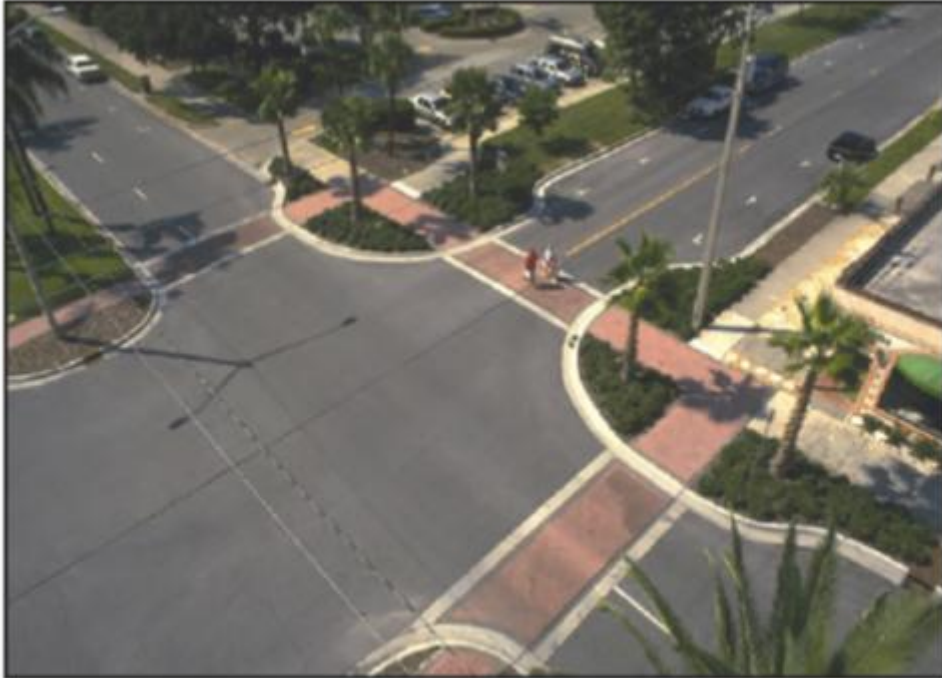
Σχήμα 2.14: Ισόπεδος Κόμβος (μη σηματοδοτημένη διασταύρωση)
