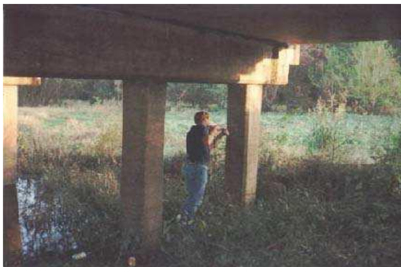
Εικόνα 2.14. Διάνοιξη οπών στο σκυρόδεμα για την εγκατάσταση επιταχυνσιογράφων (Trinity River Relief Bridge). [1]
