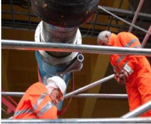
Εικόνα 5.14 Εργασίες επανευθυγράμμισης του καταστρώματος και αντικατάστασης των ασφαλειών έναντι πλευρικών μετατοπίσεων στους πυλώνες. [27]
