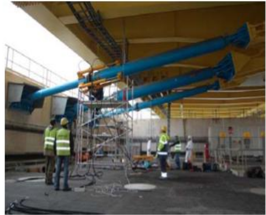
Εικόνα 5.14 Εργασίες επανευθυγράμμισης του καταστρώματος και αντικατάστασης των ασφαλειών έναντι πλευρικών μετατοπίσεων στους πυλώνες. [27]
