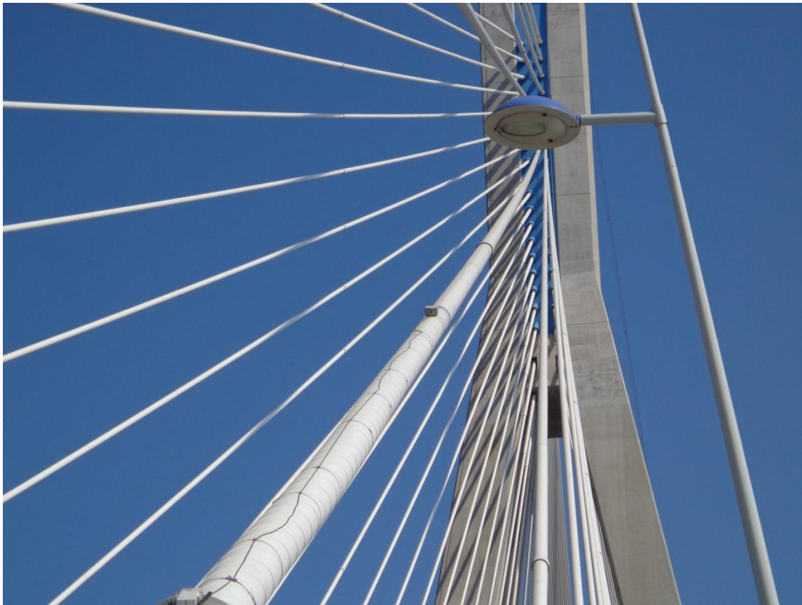
Εικόνα 3.1. Επιταχυνσιογράφος για την παρακολούθηση των ταλαντώσεων καλωδίου στη Γέφυρα Ρίου – Αντιρρίου.
