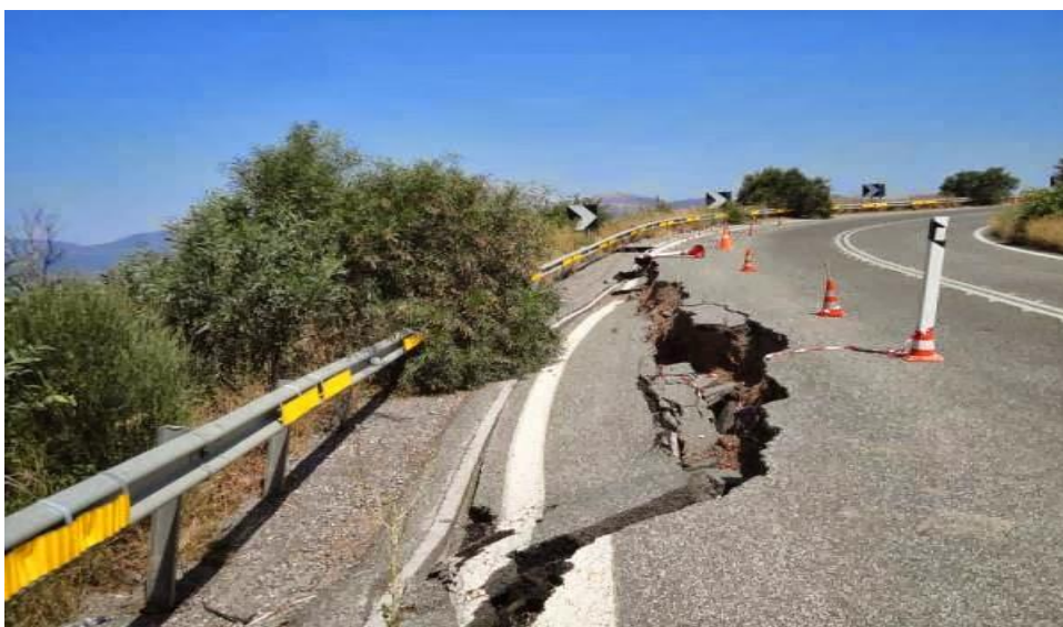
Εικόνα 1.4: Κατολισθητικό φαινόμενο σε οδοποιητικό έργο.
