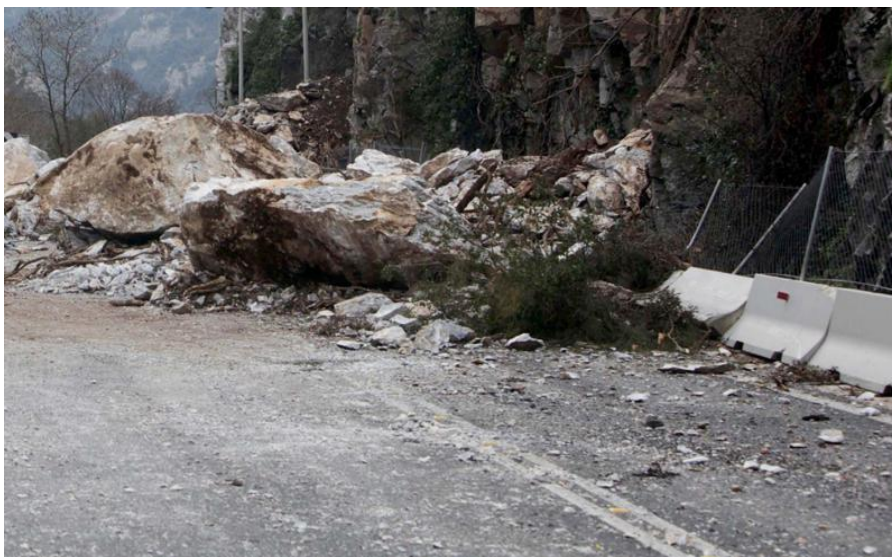
Εικόνα 2.11: Αστοχία βραχώδους πρανούς ορύγματος.
