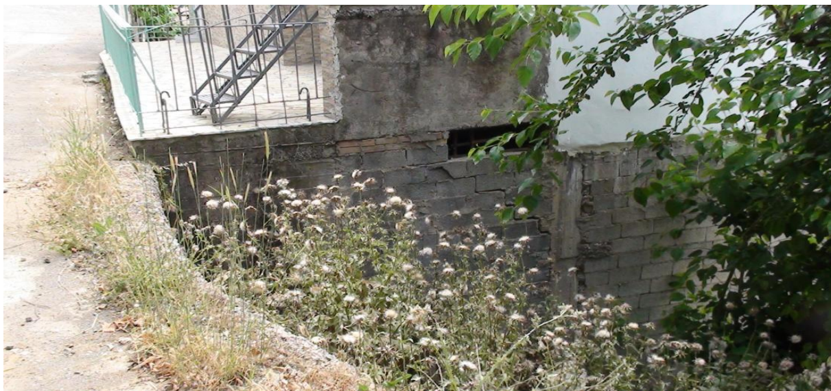
Εικόνα 5.11: Η πρόχειρη φτιαγμένη τοιχοποιία έχει αστοχήσει.
