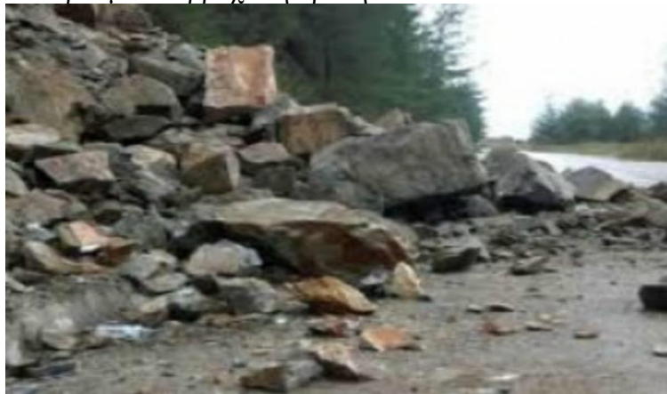
Εικόνα 3.13: Κατολίσθηση βραχωδών πρανών. [8]
