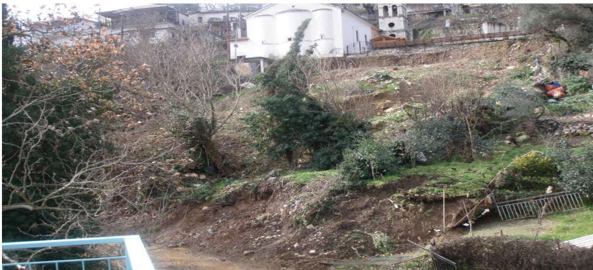
Εικόνα 5.7: Η περιοχή της κατολίσθησης αποτελείται από υλικά του μανδύα αποσάθρωσης των μεταβατικών στρωμάτων και του φλύσχη καθώς και από υλικά πρόσφατων επιχωματώσεων.
