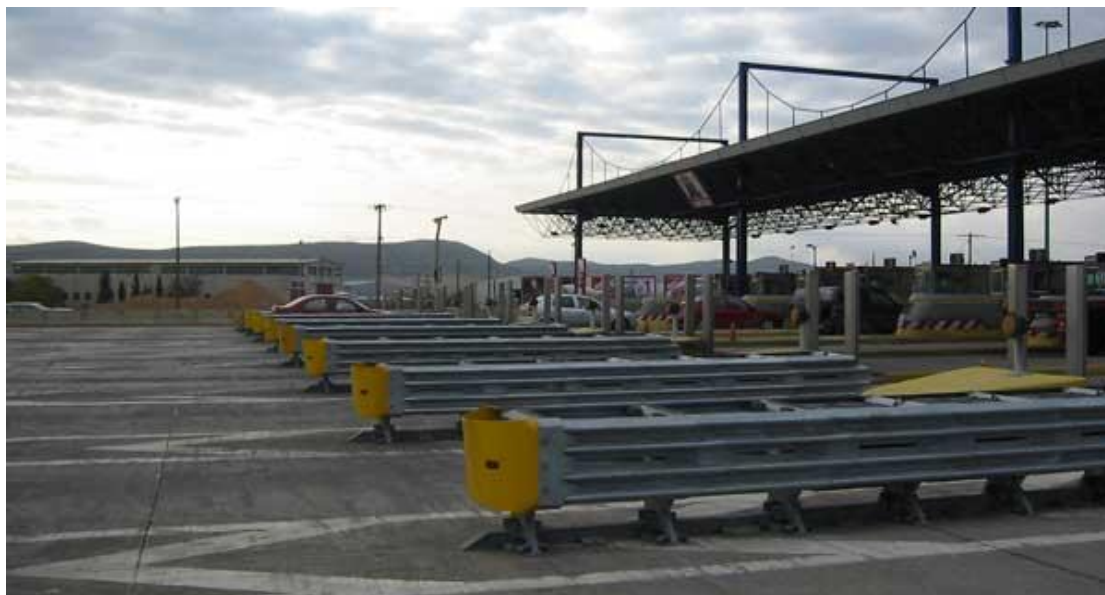
Εικόνα 6.5:Συστήματα παραμόρφωσης ενέργειας πρόσκρουσης σε σταθμό διοδίων.
