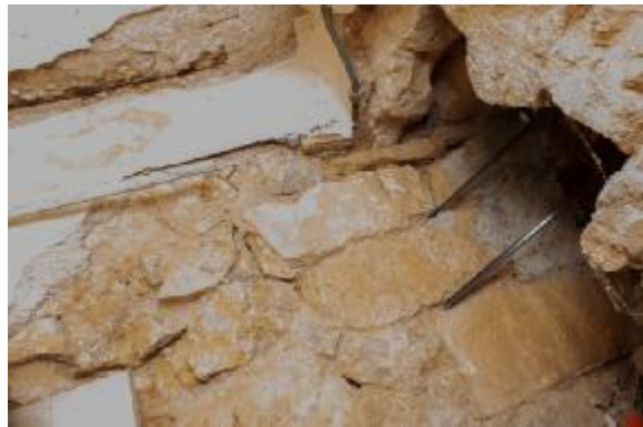
Εικόνα 74: Αποδιοργάνωση της λιθοδομής
