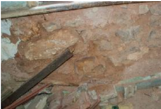
Εικόνα 73: Αποδιοργάνωση της λιθοδομής
