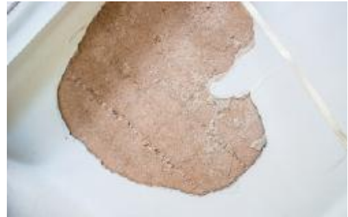
Εικόνα 29: Οπλισμένο σκυρόδεμα πατώματος
