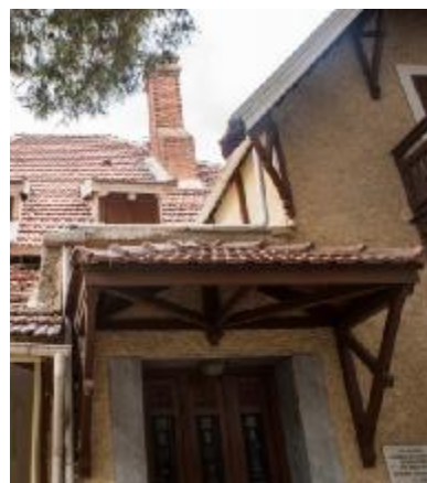
Εικόνα 45: Άποψη Δώματος από πρόσοψη
