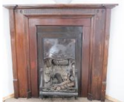
Εικόνες 57,58,59,60,61: Ξύλινες λεπτομέρειες
