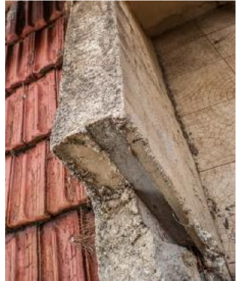
Εικόνα 78: Παλιό στηθαίο δώματος
