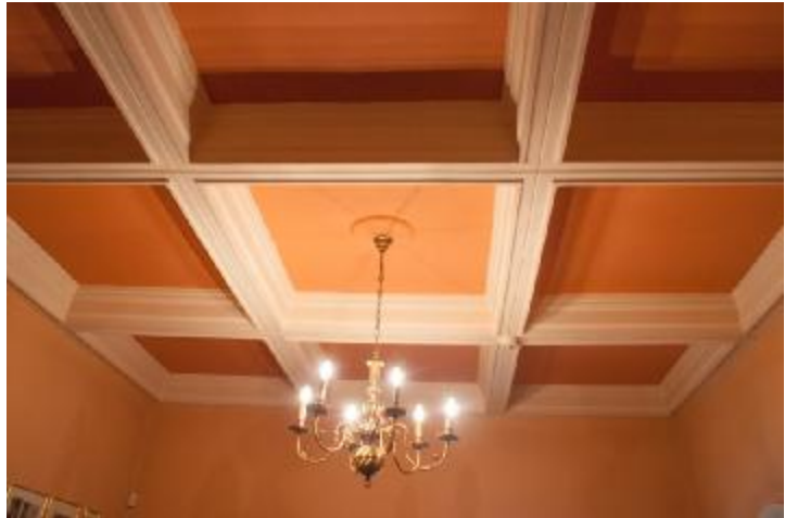
Εικόνα 35: Φατνώματα οροφής
