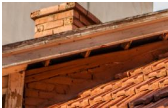
Εικόνα 72: Απώλεια επιχρισματος στις πλαϊνές μετώπες
