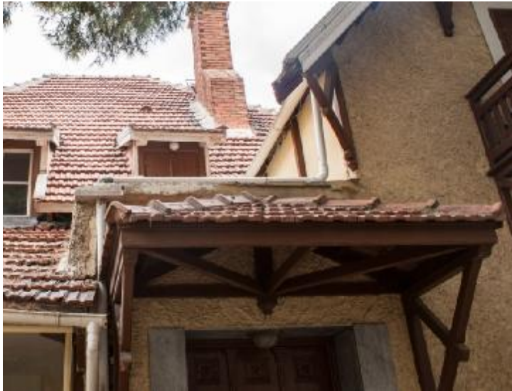
Εικόνα 77: Άποψη δώματος από την πρόσοψη
