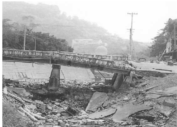
Εικόνα 1.3 Παρατηρούμενη καθίζηση ακρόβαθρου (αριστερά) και αστοχία ακρόβαθρου λόγω ρευστοποίησης εδάφους θεμελίωσης (δεξιά) [7].
