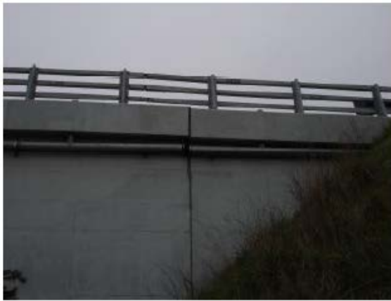
Εικόνα 1.3 Παρατηρούμενη καθίζηση ακρόβαθρου (αριστερά) και αστοχία ακρόβαθρου λόγω ρευστοποίησης εδάφους θεμελίωσης (δεξιά) [7].
