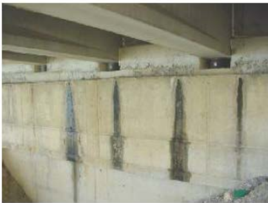
Εικόνα 1.7 Διάβρωση σκυροδέματος στην περιοχή στραγγιστηρίων (αριστερά) και διάβρωση πρανούς στήριξης ακροβάθρου (δεξιά) [3].
