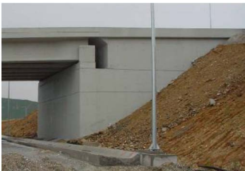
Εικόνα 1.1 Κιβωτιόσχημο ακρόβαθρο (αριστερά) και μεσόβθρα γέφυρας μέσω των οποίων γίνεται προβολοδόμηση (δεξιά) [3].
