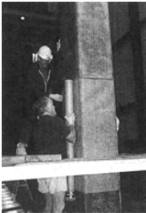
Εικόνα 2.1 Ενίσχυση βάρων με μανδύες σύνθετων υλικών - διάστρωση με το χέρι (αριστερά) και μηχανική περιέλιξη (δεξιά) [7].
