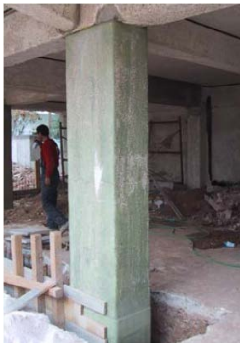
Εικόνα 2.2 Ενίσχυση σε διάτμηση κρίσιμης περιοχής (α) δοκού (β) υποστυλώματος [8].
