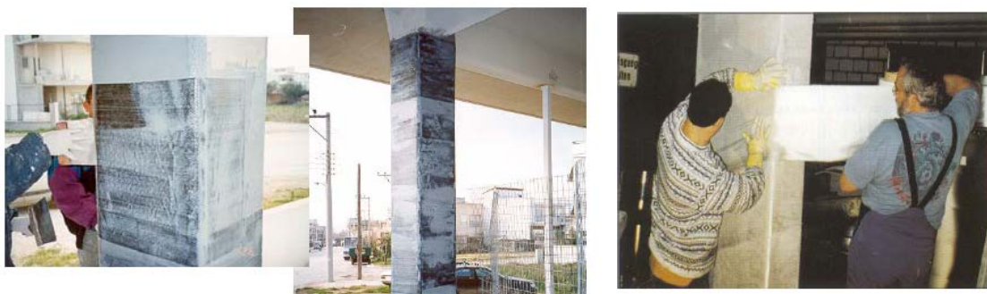
Εικόνα 2.4 Περίσφιγξη υποστυλωμάτων με μανδύες σύνθετων υλικών [8].
