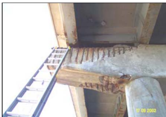
Εικόνα 1.16 Βλάβες λόγω διάβρωσης του οπλισμού στην κεφαλή του μεσοβάθρου (αριστερά) και κατεστραμμένοι τένοντες προέντασης (δεξιά) της γέφυρας του αυτοκινητοδρόμου 115 στο Οντάριο του Καναδά [4].
