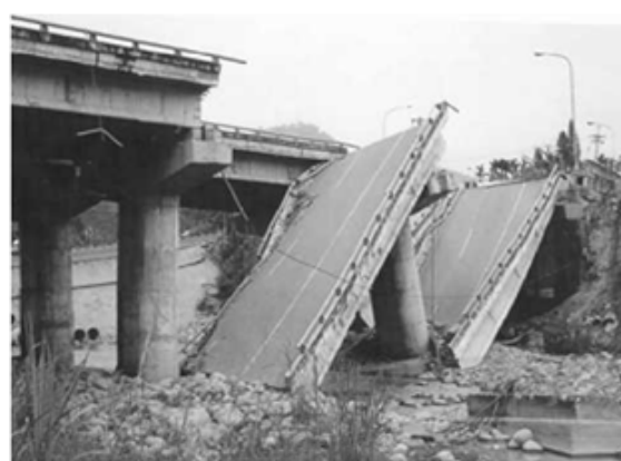
Εικόνα 1.9 Αστοχία γέφυρας λόγω κατακόρυφης μετακίνησης μεσοβάθρου (αριστερά) και αστοχία λόγω απώλειας στήριξης στο μεσόβαθρο (δεξιά) [7].
