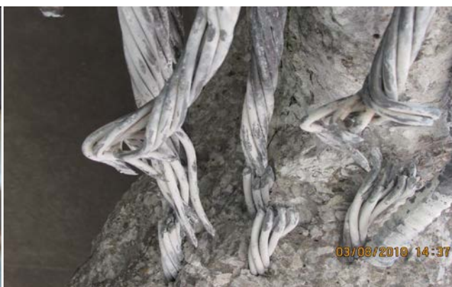
Εικόνα 1.16 Βλάβες λόγω διάβρωσης του οπλισμού στην κεφαλή του μεσοβάθρου (αριστερά) και κατεστραμμένοι τένοντες προέντασης (δεξιά) της γέφυρας του αυτοκινητοδρόμου 115 στο Οντάριο του Καναδά [4].
