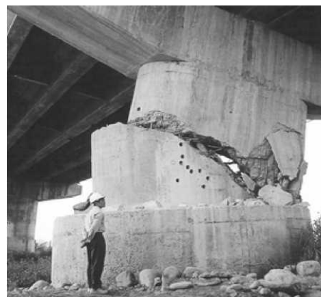
Εικόνα 1.8 Αστοχία καμπτικού τύπου (αριστερά) και αστοχία διατμητικού τύπου (δεξιά) [7].
