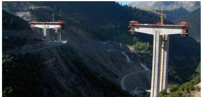
Εικόνα 1.1 Κιβωτιόσχημο ακρόβαθρο (αριστερά) και μεσόβθρα γέφυρας μέσω των οποίων γίνεται προβολοδόμηση (δεξιά) [3].
