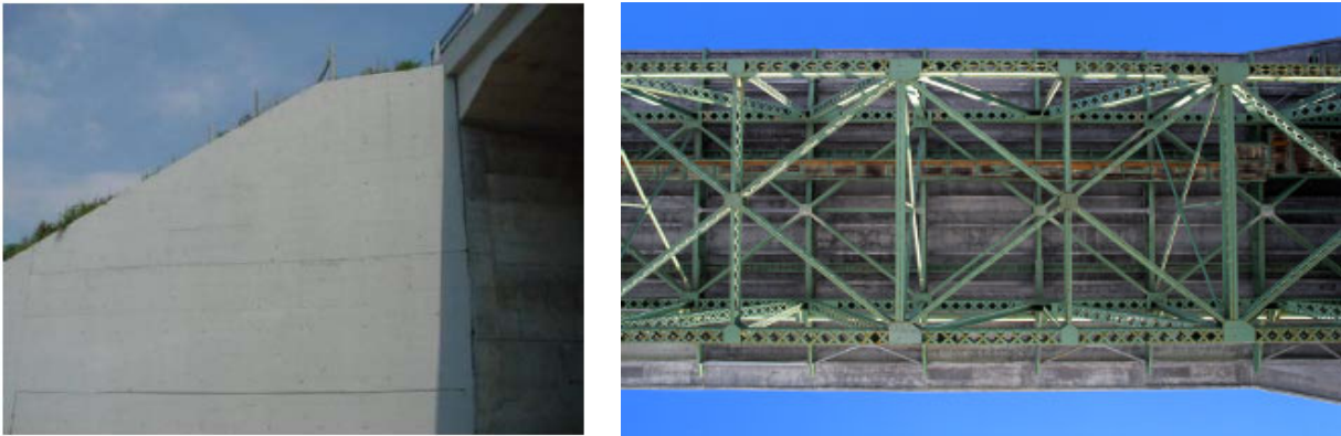
Εικόνα 1.2 Συνήθης πτερυγότοιχος στήριξης ακρόβαθρου (αριστερά) και κατάστρωμα γέφυρας απεικονιζόμενο από την κάτω πλευρά του (δεξιά) [3].
