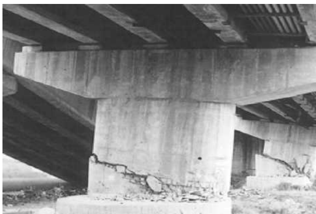
Εικόνα 1.8 Αστοχία καμπτικού τύπου (αριστερά) και αστοχία διατμητικού τύπου (δεξιά) [7].
