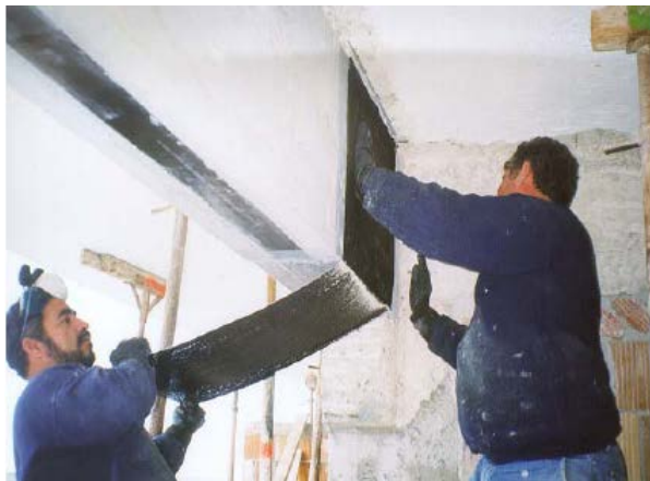
Εικόνα 2.2 Ενίσχυση σε διάτμηση κρίσιμης περιοχής (α) δοκού (β) υποστυλώματος [8].
