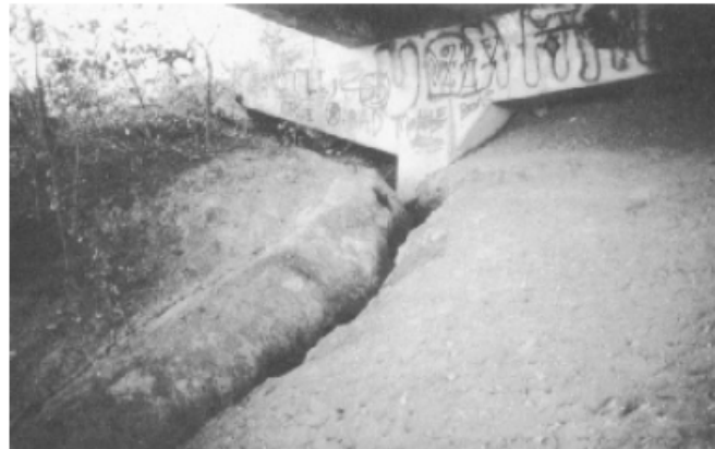
Εικόνα 1.7 Διάβρωση σκυροδέματος στην περιοχή στραγγιστηρίων (αριστερά) και διάβρωση πρανούς στήριξης ακροβάθρου (δεξιά) [3].
