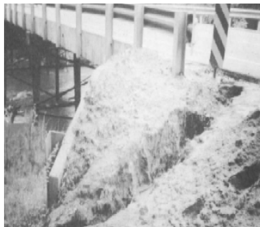
Εικόνα 1.15 Ρωγμές σε περυγότοιχο γέφυρας (αριστερά) και διάβρωση επιχώματος στα ανάντη περυγότοιχου (δεξιά) [3].
