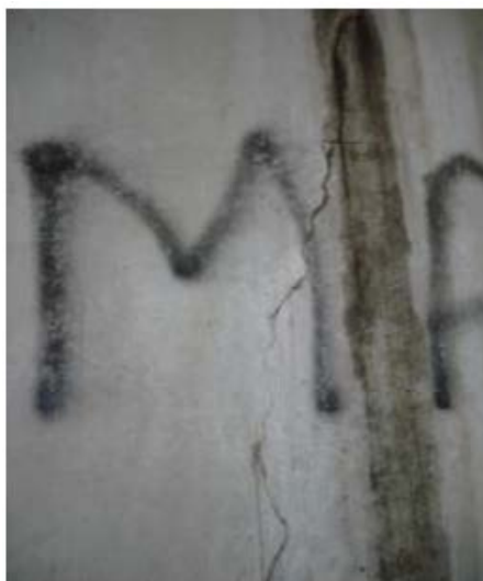
Εικόνα 1.6 Ρωγμές στον κορμό του ακρόβαθρου (αριστερά) και κίνδυνος για διάβρωση λόγω μη στεγανότητας του αρμού του ακροβάθρου (δεξιά) [3].
