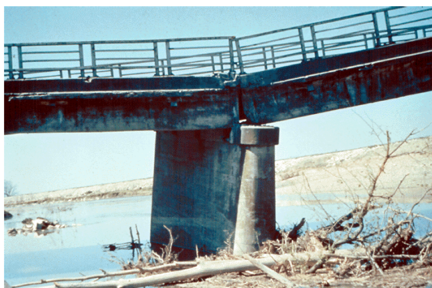
Εικόνα 1.9 Αστοχία γέφυρας λόγω κατακόρυφης μετακίνησης μεσοβάθρου (αριστερά) και αστοχία λόγω απώλειας στήριξης στο μεσόβαθρο (δεξιά) [7].
