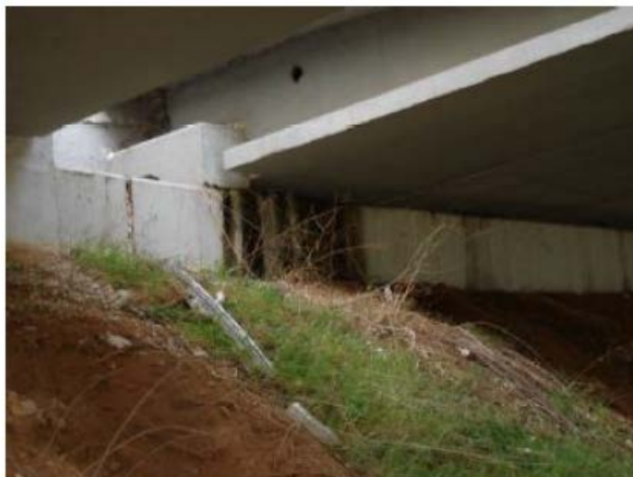
Εικόνα 1.6 Ρωγμές στον κορμό του ακρόβαθρου (αριστερά) και κίνδυνος για διάβρωση λόγω μη στεγανότητας του αρμού του ακροβάθρου (δεξιά) [3].
