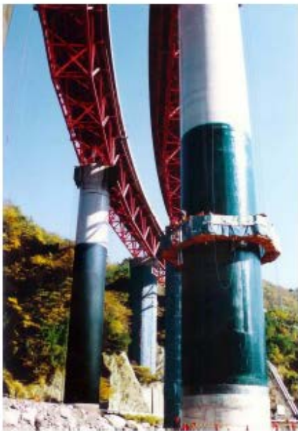
Εικόνα 2.5 Ενίσχυση βάθρων γέφυρας οπλισμένου σκυροδέματος με σύνθετα υλικά φύλλων άνθρακα [9].
