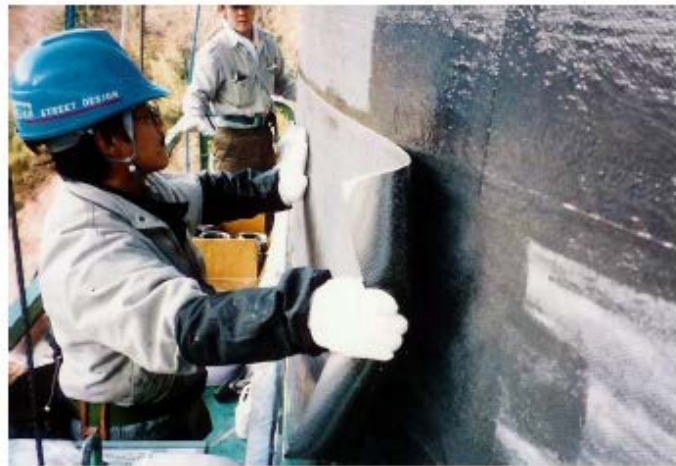
Εικόνα 2.5 Ενίσχυση βάθρων γέφυρας οπλισμένου σκυροδέματος με σύνθετα υλικά φύλλων άνθρακα [9].
