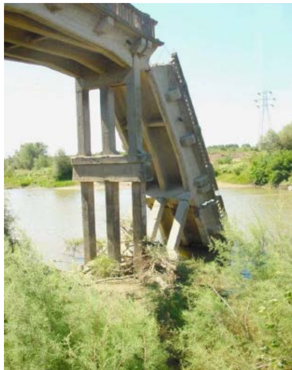
Εικόνα 1.11 Απώλεια φέρουσας ικανότητας μεσοβάθρου λόγω υποσκαφής και τελική κατάρρευση γέφυρας [3].
