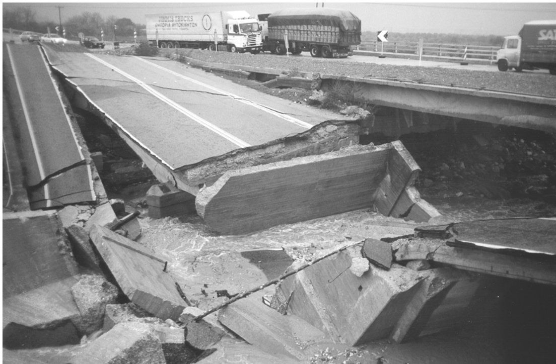
Εικόνα 1.19 Η Γέφυρα Ζηλιάνα μετά την καταστροφή - η κυκλοφορία έχει εκτραπεί στην υπό κατασκευή γέφυρα του δεξιού κλάδου του αυτοκινητοδρόμου Αθηνών – Θεσσαλονίκης [6].
