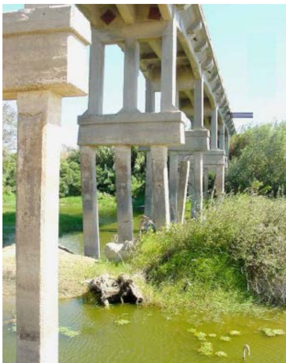
Εικόνα 1.11 Απώλεια φέρουσας ικανότητας μεσοβάθρου λόγω υποσκαφής και τελική κατάρρευση γέφυρας [3].
