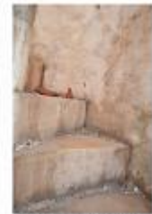
ΚΛ.057 ΘΦΘΡΑ ΚΛΙΜΑΚΟΣΤΑΣΙΟΥ
