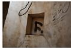
ΚΛ.051 ΕΙΣΟΔΗ ΣΤΟ ΤΟΞΟ ΤΟΥ ΚΛΙΜΑΚΟΣΤΑΣΙΟΥ
