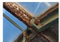
ΛΠ.891 ΣΥΝΔΕΣΗ ΥΑΛΙΝΩΣ ΠΕΤΑΣΜΑΤΟΣ ΣΤΗ ΚΑΤΑΚΕΦΗ
