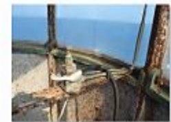
ΛΠ.879 ΤΟΠΟΘΕΤΗΣΗ ΚΑΛΩΔΙΟΥ
