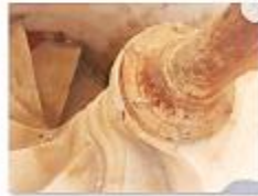
ΛΠ.873 ΣΤΕΡΕΩΣΗ ΦΑΝΟΥ ΣΤΟ ΚΛΗΜΑΚΟΣΤΑΣΙΟ
