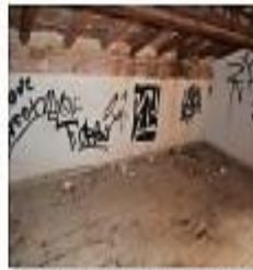
ΦΣ.Χ.046 ΣΤΕΡΕΩΣΗ ΣΤΕΓΗΣ ΣΤΟ ΝΟΤΙΟ ΤΣΙΒΙ
