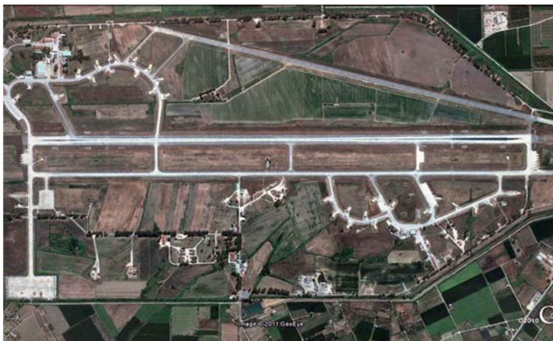
Αεροδρόμιο Ανδραβίδας: Μήκος διαδρόμου 3.100 μέτρα
