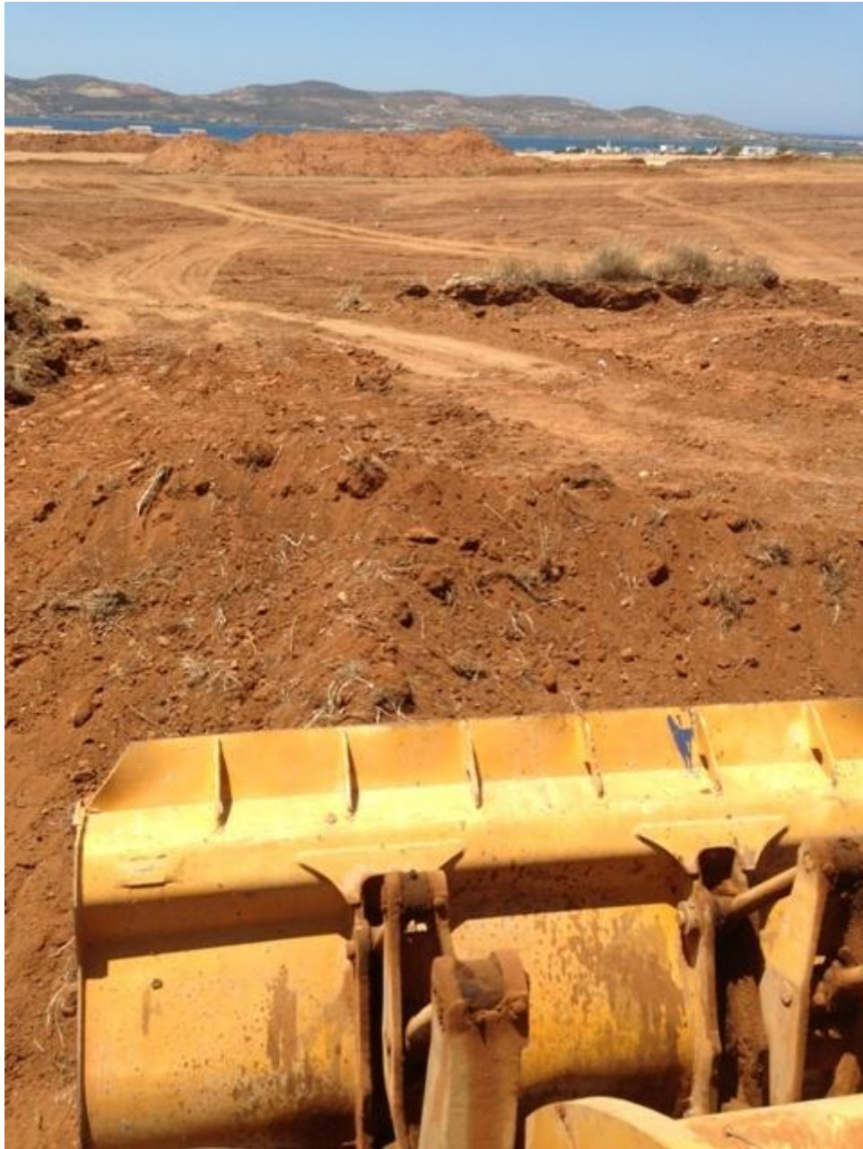
Καθαρισμός θέσης κατασκευής αεροδιαδρόμου
