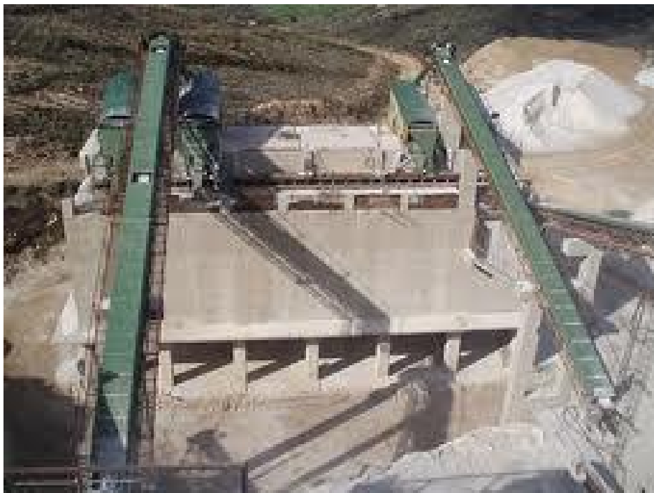
Εικόνα 8. Μεταφορικές ταινίες σε εργοτάξιο.
