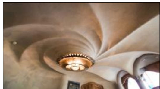
Εικόνα 124 Οροφή σε σχήμα σπείρας στον πρώτο όροφο
