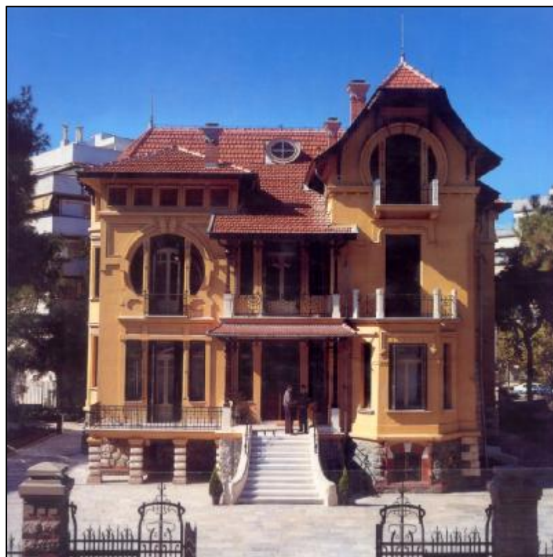
Εικόνα 234 Το κτίριο μετά την αναστήλωσή του, Πρόσοψη
