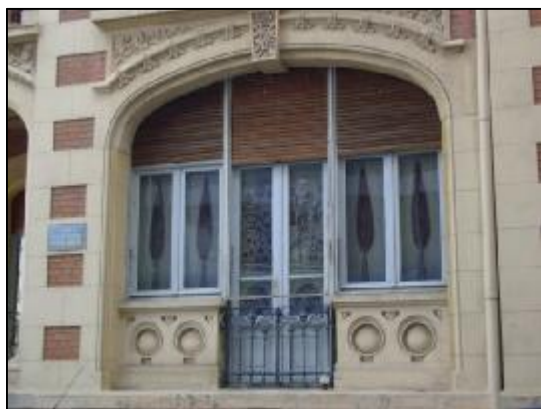
Εικόνα 202 Λεπτομέρεια ανοίγματος παραθύρου
