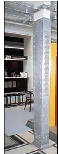
Εικόνα 97 Μεταλλικό υποστήλωμα της αίθουσας συναλλαγών
