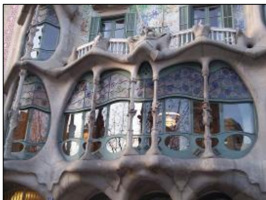
Εικόνα 125 Πρόσοψη, κουφώματα πρώτου ορόφου
