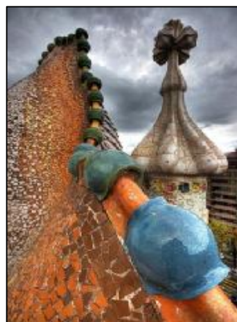
Εικόνα 127 Λεπτομέρεια στέγης όπως φαίνεται από την πίσω πλευρά (δώμα)
