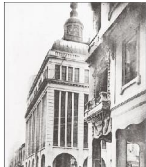
Εικόνα 150 Το Μέγαρο Stein χτίστηκε το 1908 από το μηχανικό Ernst Loewy ως υποκατάστημα του ομώνυμου αυστριακού οίκου. Εξέχον μορφολογικό στοιχείο η γυάλινη σφαίρα στην απόληξη του κτιρίου (αρχείο Κ.Ι.Θ.)
