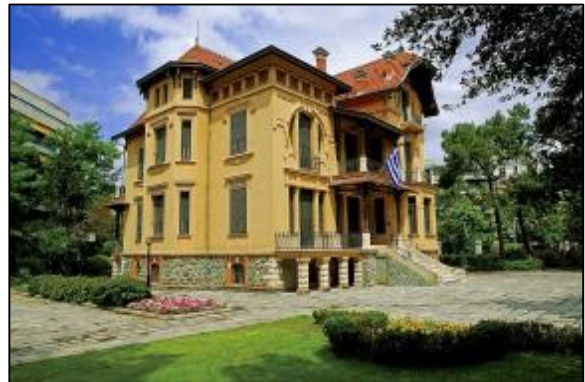
Εικόνα 211 Βορειοανατολική άποψη κτιρίου σήμερα
