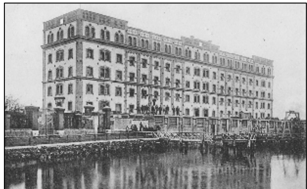
Εικόνα 189 Το κτίριο του Μύλου Αλλατίνι στις αρχές του 20ού αιώνα, νοτιοδυτική άποψη. Είναι χαρακτηριστικό δείγμα βιομηχανικής αρχιτεκτονικής των αρχών του 20ού αιώνα.
