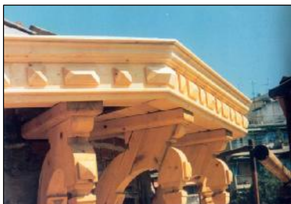
Εικόνα 223 Λεπτομέρεια ανακατασκευασμένου ξύλινου γεισώματος
