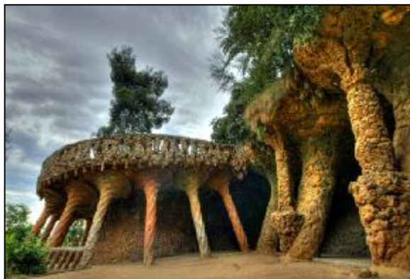
Εικόνα 115 Κεκλιμένες κολώνες από πέτρα, πάρκο Γκουέλ, Βαρκελώνη
