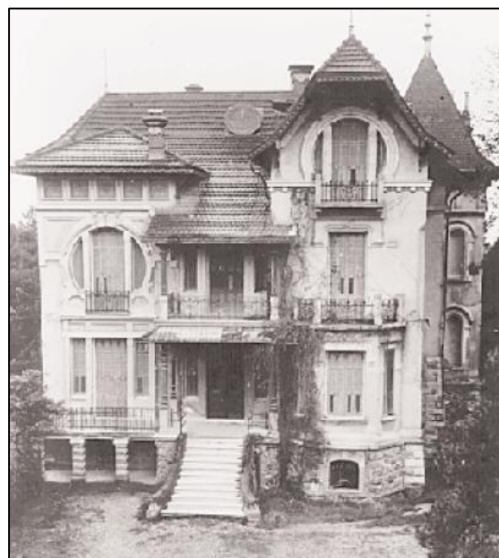
Εικόνα 210 Η Casa Bianca ακατοίκητη, δεκαετία 1960, Πρόσοψη βόρεια
