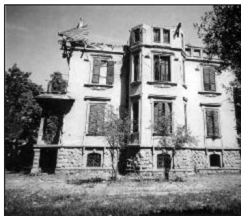
Εικόνα 219 Δυτική όψη κτιρίου 1991
