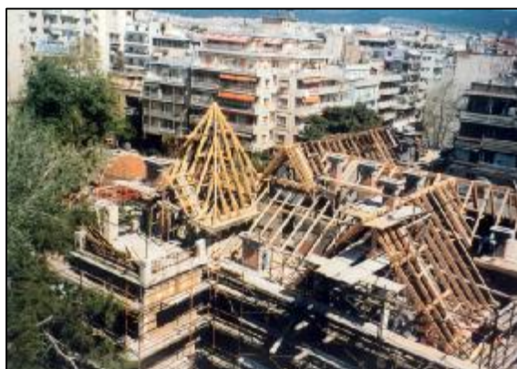
Εικόνα 222 Η ανακασκευή της στέγης
