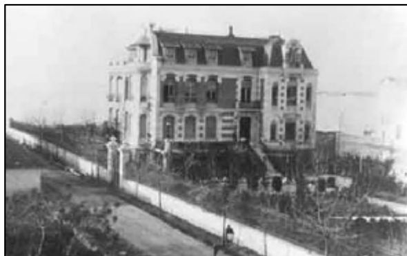
Εικόνα 197 Η έπαυλη Μοδιάνο μόνη της ακόμα στις αρχές του 20 ου αιώνα, περιοχή Εξοχών (Πύργων), δυτική όψη
