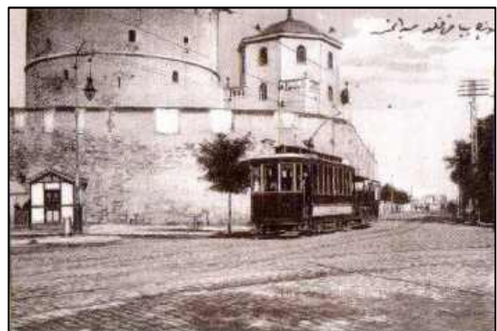
Εικόνα 142 Τραμ στην περιοχή του Λευκού Πύργου πριν την κατεδάφιση του παραθαλάσσιου τείχους
