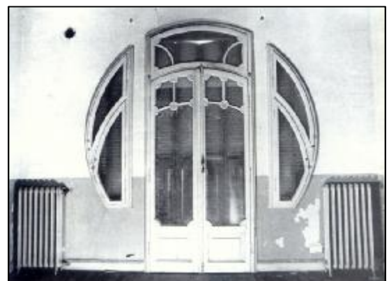
Εικόνα 231 Άνοιγμα κουφώματος στον όροφο
