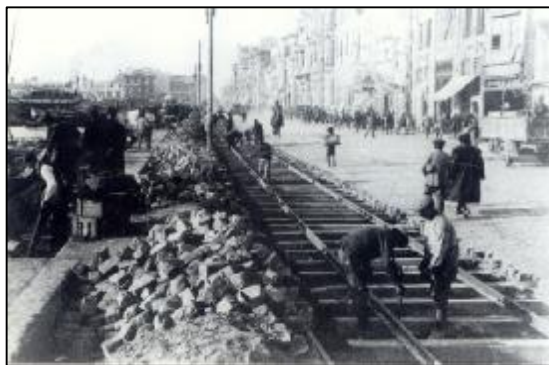
Εικόνα 141 Η κατασκευή σιδηροδρομικής γραμμής στην προκουμαία, Φεβρουάριος 1917
