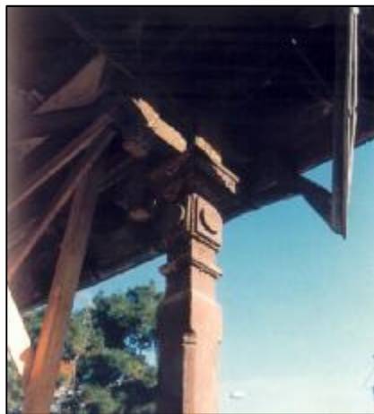
Εικόνα 217 Λεπτομέρεια ξύλινων στηριγμάτων του εξώστη πρόσοψης
