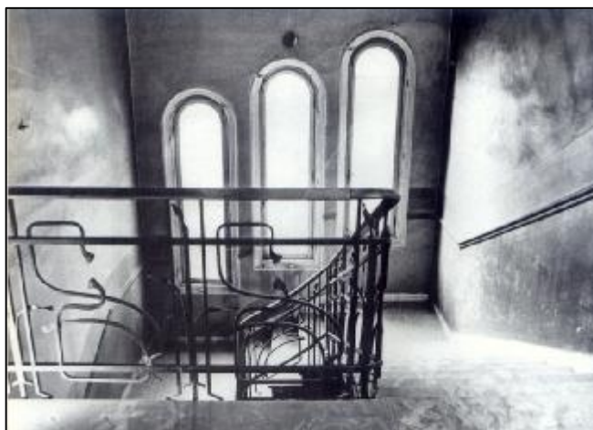
Εικόνα 213 Λεπτομέρεια του σιδερένιου κιγκλιδώματος του κεντρικού κλιμακοστασίου
