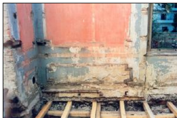
Εικόνα 224 Εσωτερική άποψη μετά την τοποθέτηση ψευτοπατώματος
