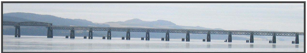
Φωτ. 1.11 Σιδηροδρομική γέφυρα Tay (Αγγλία, 1878).
