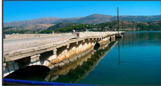
Φωτ. 1.4 Λίθινη γέφυρα στην Κεφαλλονιά.
