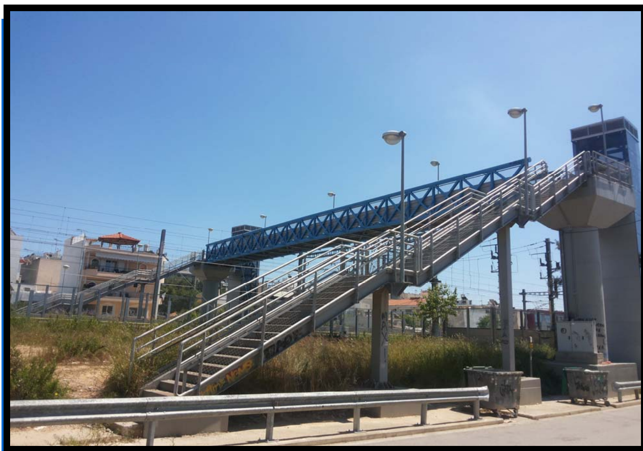
Φωτ. 4.1 Δυτική όψη γέφυρας.
