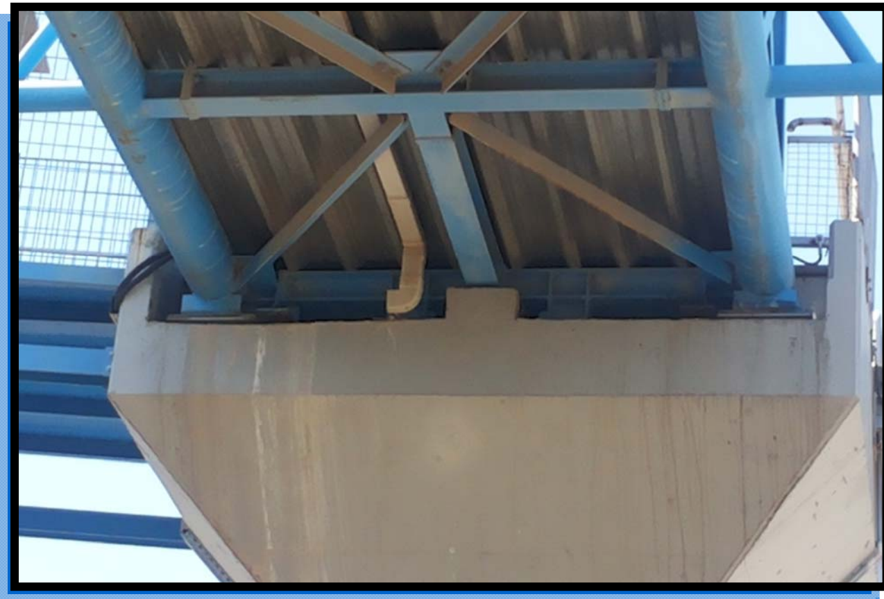
Φωτ. 4.10 Χώρος εφεδράνων.
