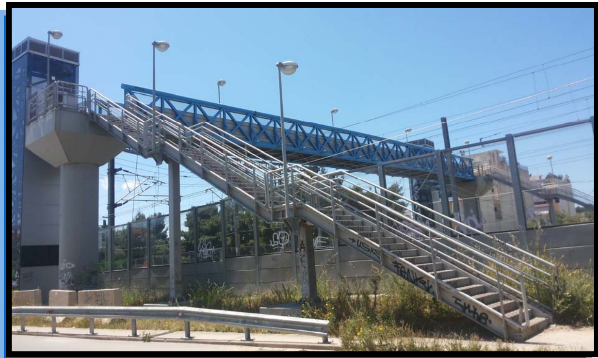
Φωτ. 4.8 Ανατολικό κλιμακοστάσιο.
