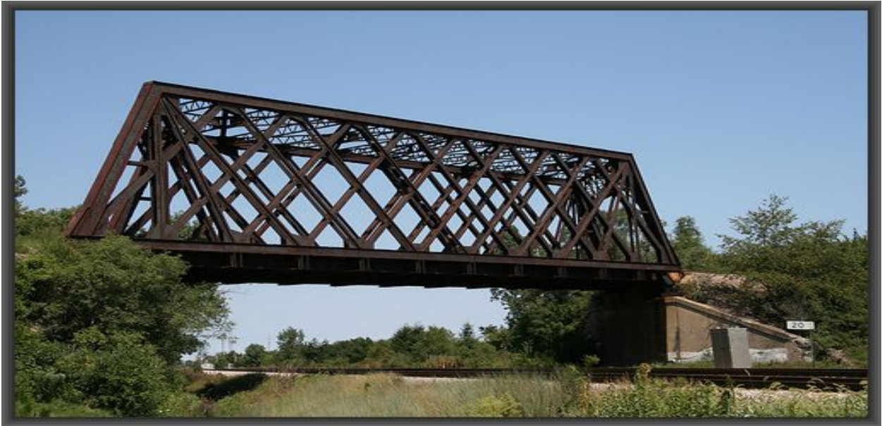
Φωτ. 1.7 Δικτυωτή γέφυρα στο Ιλλινόις.
