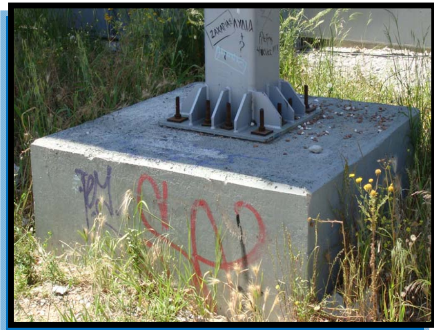
Φωτ. 4.13 Βάθρο κλιμακοστασίου.
