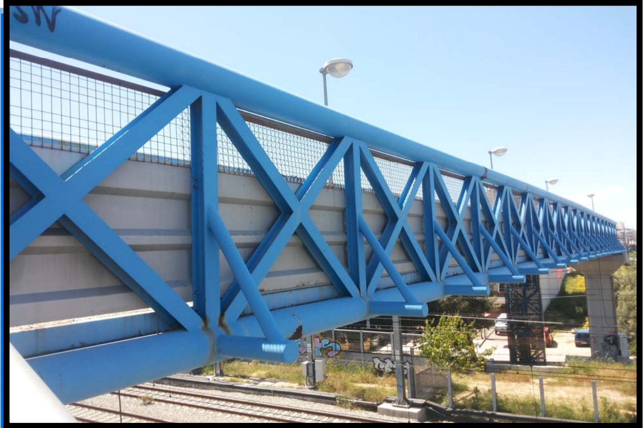
Φωτ. 4.4 Βόρεια όψη γέφυρας.
