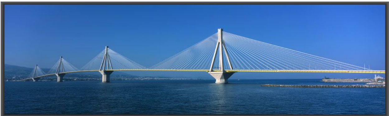
Φωτ. 1.6 Καλωδιωτή γέφυρα Ρίου- Αντιρίου.
