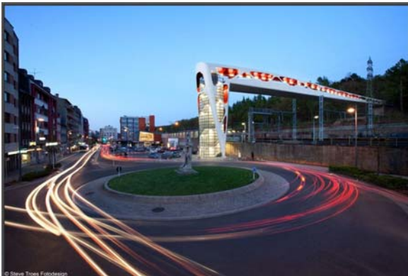
Φωτ. 1.1 Πεζογέφυρα στο Λουξεμβούργο.
