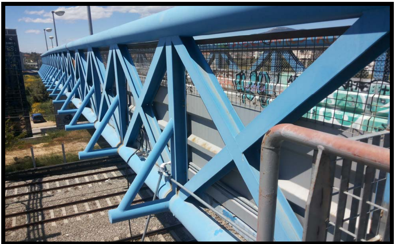
Φωτ. 4.5 Νότια όψη γέφυρας.
