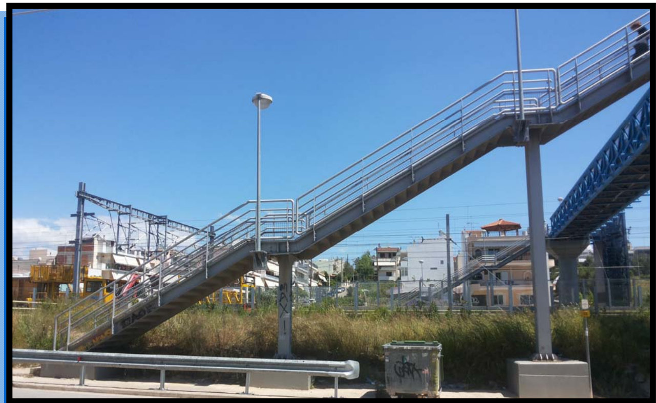
Φωτ. 4.9 Δυτικό κλιμακοστάσιο.
