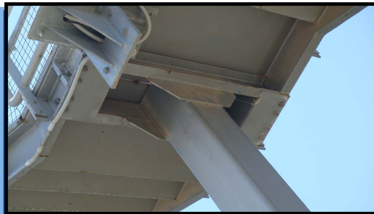
Φωτ. 4.11 Τυπική σύνδεση στύλου κλιμακοστασίου.
