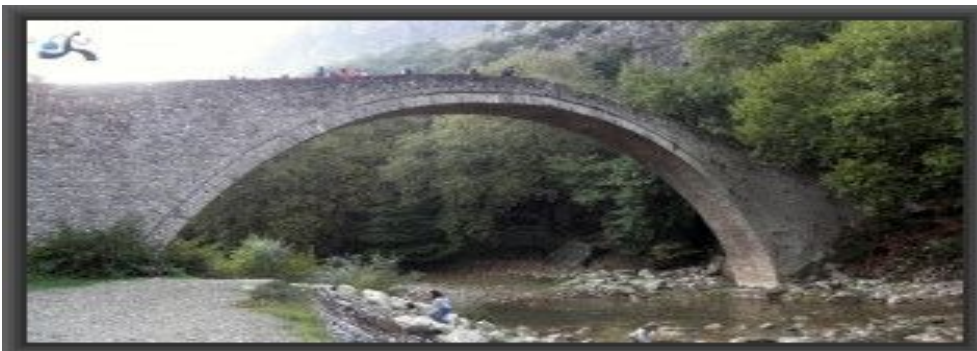
Φωτ. 1.8 Μονοτοξωτή γέφυρα Δυτικά της Πύλης, Νομός Τρικάλων. Κατασκευασθήσα το 1514.
