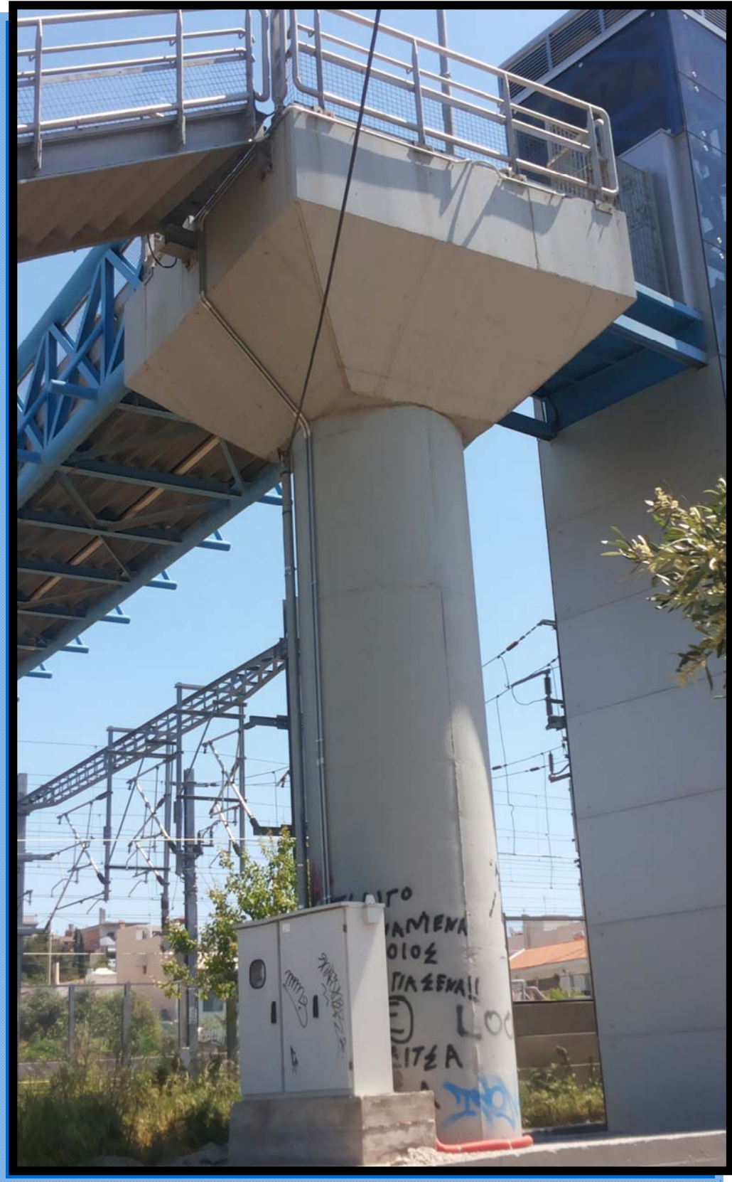
Φωτ. 4.3 Δυτικό βάθρο.
