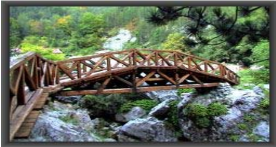
Φωτ. 1.3 Ξύλινη γέφυρα στο Λιτόχωρο.
