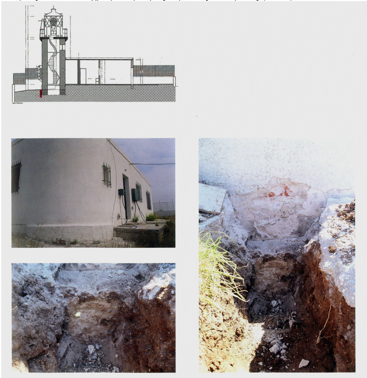
Εικόνα 59:Θεμελίωση του πύργου του φάρου
