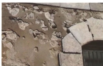
Εικόνα 96: 3, Διάβρωση λίθων ρηγματώσεις/ποκολλήσεις τμημάτων, προϊόντα βιολογικής διάβρωσης, 4, Διάβρωση επιχρισμάτων, Αποκολλήσεις σε εσωτερικές και εξωτερικές θέσεις. Πηγή : 'Πέτρινοι φάροι από το χθές στο σήμερα', Εργαστήριο Δομικών υλικών Τμήμα Πολιτικών Μηχανικών ΑΠΘ, Εκδόσεις: Κλειδάριθμος
