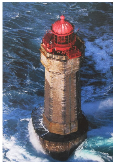
Εικόνα 34:Ο φάρος Λα Ζουμέν, Βρετάνη, Γαλλία (1911),Ο φάρος κατασκευάστηκε σε μια πο τις πιο επικίνδυνες περιοχές της ακτής του Ατλαντικού. Κατά την κατασκευή του οι μηχανικοί δεν αντιλήφθηκαν την κούλτητα που υπήρχε κάτω από τον ύφαλο, με αποτέλεσμα το κτίσμα να είναι ασταθές . Ο φάρος εκκενώθηκε και μέχρι το 1940διήρκησαν οι εργασίες ενίσχυσης της θεμελίωσης. Το 1989 στη διάρκεια μιας ισχυρής καταγίδας τα κύματα κατέκλυσαν πλήρως τον φάρο, που κατάφερε να αντισταθεί. Αποτελεί τον πιο εκτεθειμένο φάρο της Γαλλίας.Πηγή: : A. L. Marrioti, 'Οι μεγαλύτεροι Φάροι του Κόσμου', Εκδόσεις Καρακώστογλου, 2005
