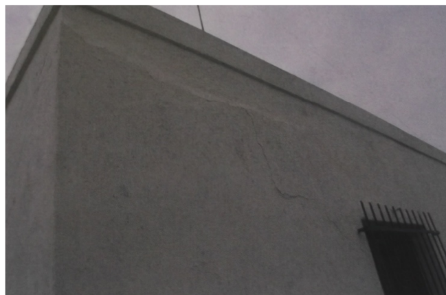
Εικόνα 67:1. Ρηγματώσεις στην πλάκα έδρασης του φανού , 2. Εμφανής ρηγμάτωση στην νότια όψη
