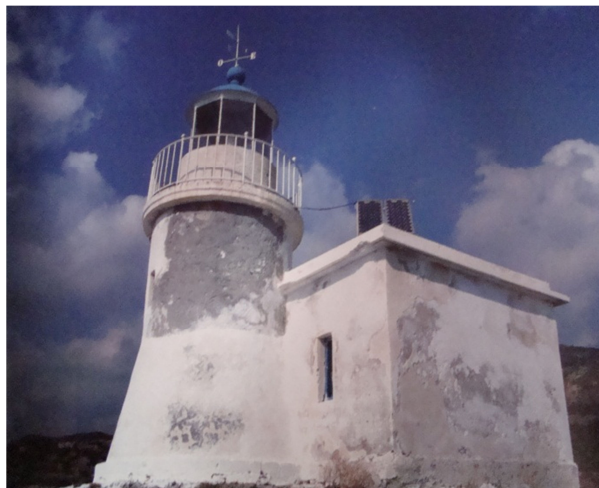
Εικόνα 27:1.Ο φάρος Κραναί, Γύθειο, οκταγωνική κάτοψη με ισόδομη κατασκευή 2. Ο φάρος Καψάλι Κύθηρα, κυκλική κάτοψη με επίχρισμα,Πηγή: Γ. Σκούλας
