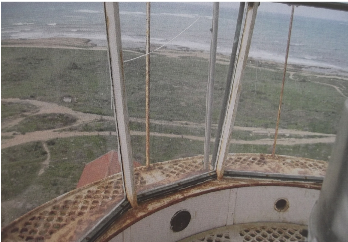
Εικόνα 83:1,2. Προϊόντα οξείδωσης στον μεταλλικό εξώστη του φανού.
