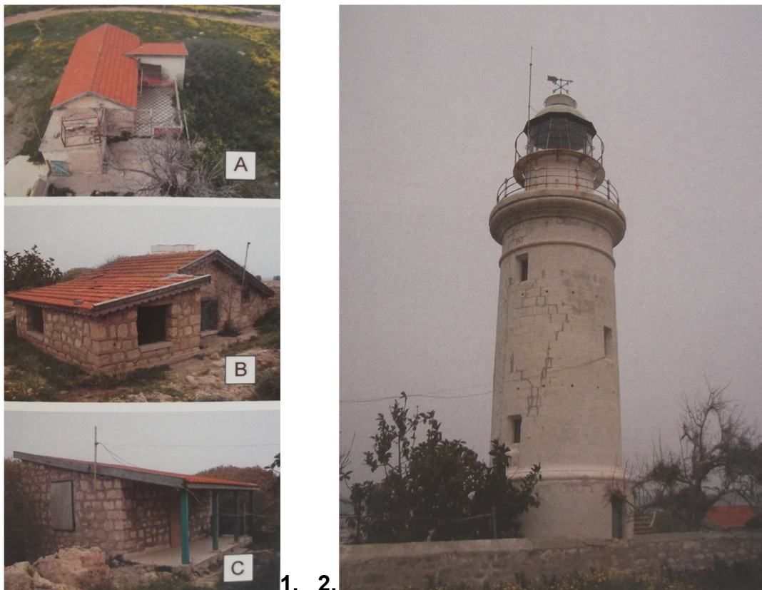
Εικόνα 78:1. Τα σπίτια του φανοφύλακα, 2. Ρωγμές στην νοτιοδυτική πλευρά του φάρου
