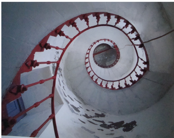
Εικόνα 89: 1,2 Η σκάλα με τα 115 μαρμάρινα φιντευτά στον τοίχο σκαλοπάτια που οδηγεί στο φανάρι, Πηγή :Γ Σκούλας
