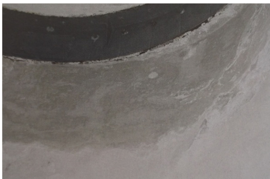
Εικόνα 82:1,2,3.Αποδιοργάνωση των επιχρισμάτων και συγκέντρωση υγρασίας
