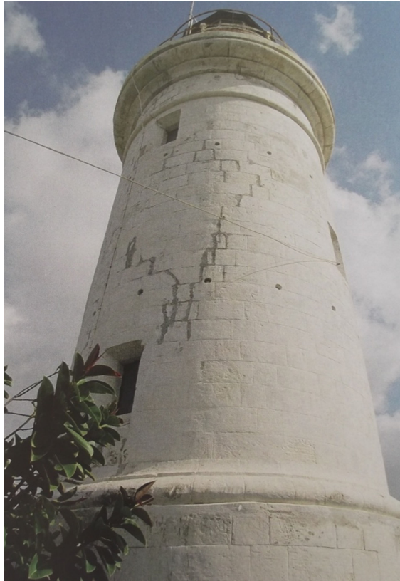
Εικόνα 81:1,2.Ρηγματώσεις στην νοτιοδυτική όψη του φάρου
