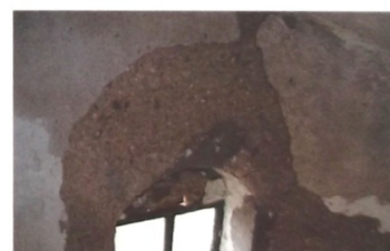
Εικόνα 96: 3, Διάβρωση λίθων ρηγματώσεις/ποκολλήσεις τμημάτων, προϊόντα βιολογικής διάβρωσης, 4, Διάβρωση επιχρισμάτων, Αποκολλήσεις σε εσωτερικές και εξωτερικές θέσεις. Πηγή : 'Πέτρινοι φάροι από το χθές στο σήμερα', Εργαστήριο Δομικών υλικών Τμήμα Πολιτικών Μηχανικών ΑΠΘ, Εκδόσεις: Κλειδάριθμος
