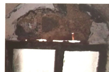
Εικόνα 97: 5 Αποσάθρωση κονιαμάτων δόμησης, Πηγή : 'Πέτρινοι φάροι από το χθές στο σήμερα', Εργαστήριο Δομικών υλικών Τμήμα Πολιτικών Μηχανικών ΑΠΘ, Εκδόσεις: Κλειδάριθμος
