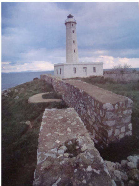
Εικόνα 27:1.Ο φάρος Κραναί, Γύθειο, οκταγωνική κάτοψη με ισόδομη κατασκευή 2. Ο φάρος Καψάλι Κύθηρα, κυκλική κάτοψη με επίχρισμα,Πηγή: Γ. Σκούλας
