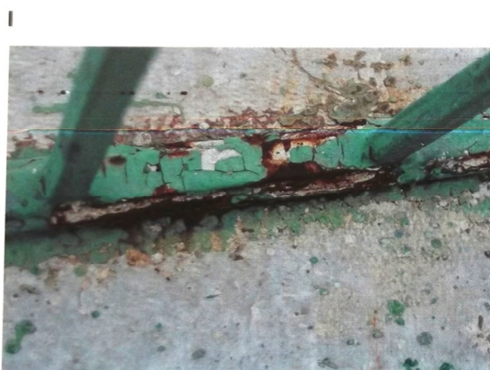
Εικόνα 97: 1 Διάβρωση μεταλλικών στοιχείων, Οπλισμός πλάκας έδρασης φανού, μεταλλικό κινκίδωμα, κουφώματα. Πηγή : 'Πέτρινοι φάροι από το χθές στο σήμερα', Εργαστήριο Δομικών υλικών Τμήμα Πολιτικών Μηχανικών ΑΠΘ, Εκδόσεις: Κλειδάριθμος
