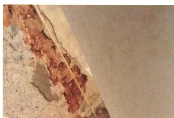
Εικόνα 97: 5 Αποσάθρωση κονιαμάτων δόμησης, Πηγή : 'Πέτρινοι φάροι από το χθές στο σήμερα', Εργαστήριο Δομικών υλικών Τμήμα Πολιτικών Μηχανικών ΑΠΘ, Εκδόσεις: Κλειδάριθμος
