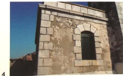
Εικόνα 96: 3, Διάβρωση λίθων ρηγματώσεις/ποκολλήσεις τμημάτων, προϊόντα βιολογικής διάβρωσης, 4, Διάβρωση επιχρισμάτων, Αποκολλήσεις σε εσωτερικές και εξωτερικές θέσεις. Πηγή : 'Πέτρινοι φάροι από το χθές στο σήμερα', Εργαστήριο Δομικών υλικών Τμήμα Πολιτικών Μηχανικών ΑΠΘ, Εκδόσεις: Κλειδάριθμος
