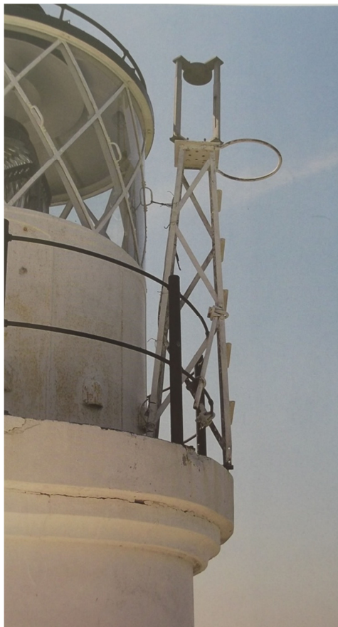
Εικόνα 67:1. Ρηγματώσεις στην πλάκα έδρασης του φανού , 2. Εμφανής ρηγμάτωση στην νότια όψη
