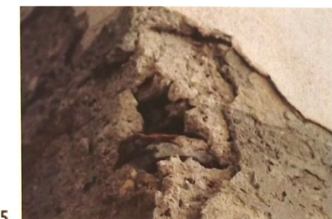
Εικόνα 96: 3, Διάβρωση λίθων ρηγματώσεις/ποκολλήσεις τμημάτων, προϊόντα βιολογικής διάβρωσης, 4, Διάβρωση επιχρισμάτων, Αποκολλήσεις σε εσωτερικές και εξωτερικές θέσεις. Πηγή : 'Πέτρινοι φάροι από το χθές στο σήμερα', Εργαστήριο Δομικών υλικών Τμήμα Πολιτικών Μηχανικών ΑΠΘ, Εκδόσεις: Κλειδάριθμος
