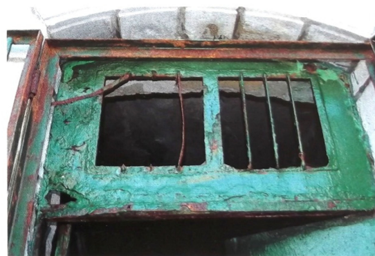
Εικόνα 97: 1 Διάβρωση μεταλλικών στοιχείων, Οπλισμός πλάκας έδρασης φανού, μεταλλικό κινκίδωμα, κουφώματα. Πηγή : 'Πέτρινοι φάροι από το χθές στο σήμερα', Εργαστήριο Δομικών υλικών Τμήμα Πολιτικών Μηχανικών ΑΠΘ, Εκδόσεις: Κλειδάριθμος
