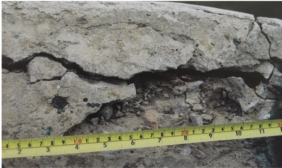
Εικόνα 71:Ρηγματώσεις στην πλάκα έδρασης του φανού
