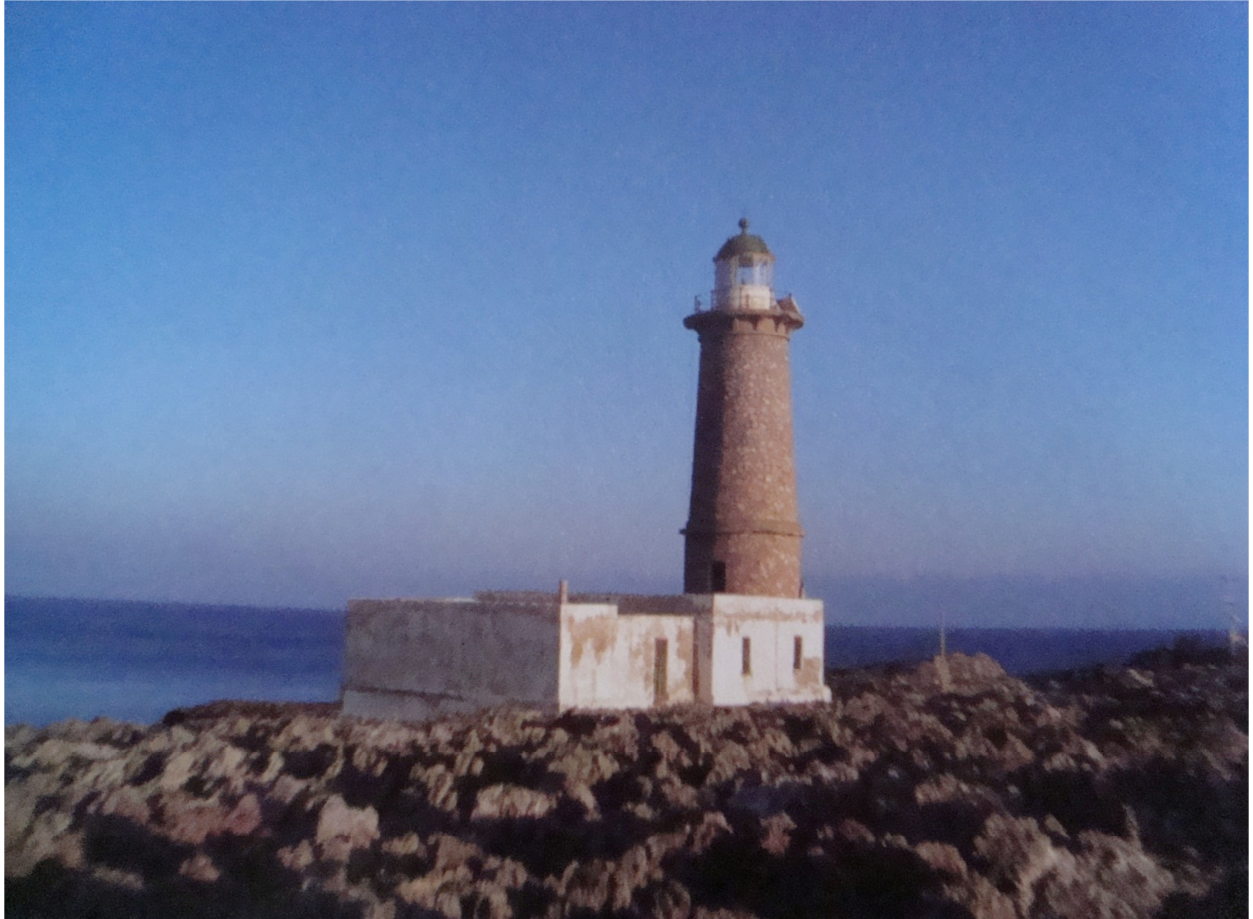
Εικόνα 28:Ο φάρος Απολυτάρης, Αντικύθηρα, κυκλική κάτοψη με ισόδομη κατασκευή, Πηγή: Γ. Σκούλας
