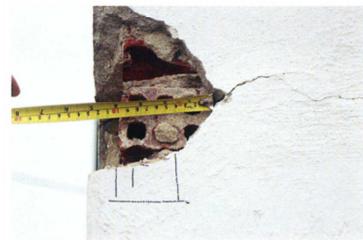
Εικόνα 60:1,2:Συμπαγείς πλίνθοι πύργου φάρου. 3,4:Διάτρητοι πλίνθοι τοιχοποιίας κτίσματος.
