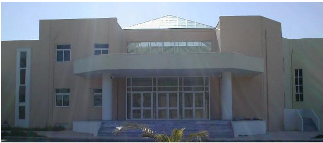
Εικόνα 10,11: Συνεδριακό κέντρο . Αμφιθέατρο, εξωτερική όψη
