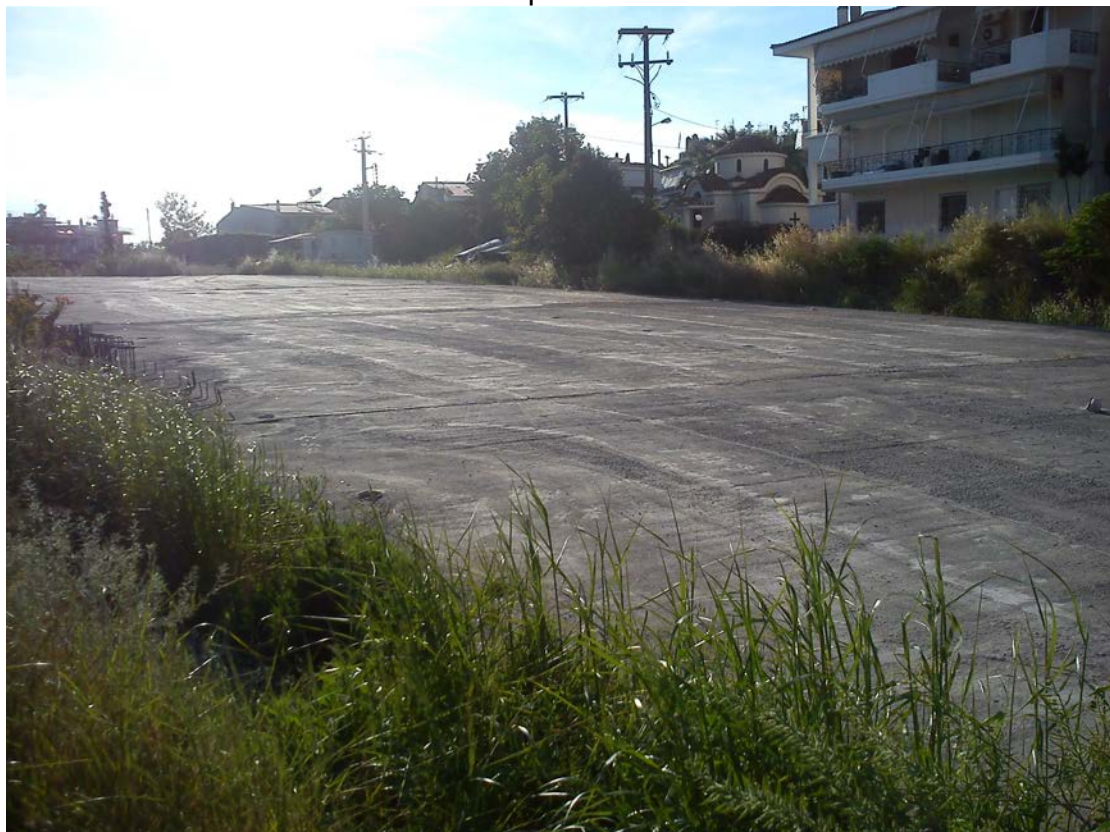
Σημείο ένωσης της ήδη κατασκευασμένης οδού με την οδό Παπαδιαμαντοπούλου
