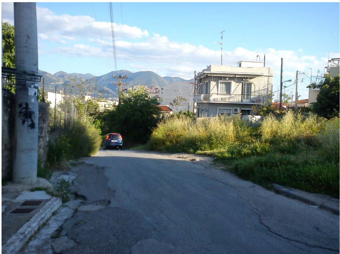
Η απότομη κλίση του υπάρχοντος δρόμου η οποία θα εξομαλυνθεί με την κατασκευή της Μικρής Περιμετρικής
