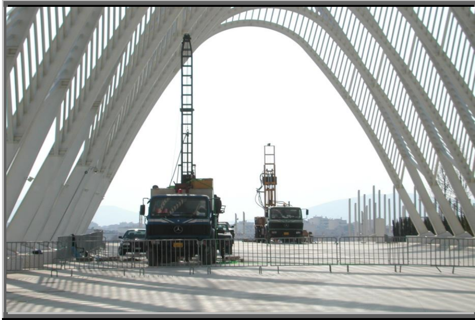
(Εικόνα 1.1, αυτοκινούμενο γεωτρήπανο τύπου BOYLES BBS-17, ΟΑΚΑ)
