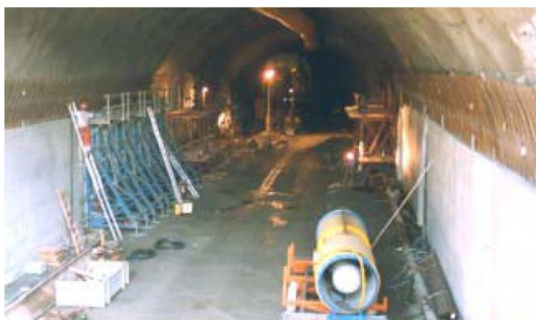
Εικόνα 5.31 Επένδυση σήραγγας με προκατασκευασμένα στοιχεία από ΑΣΣ στην περιοχή Grind στη Σουηδία [11].
