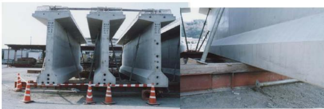
Εικόνες 5.27, 5.28 Τελική μορφή των δοκών σχήματος T του καταστρώματος της γέφυρα Higashi-Oozu [5].
