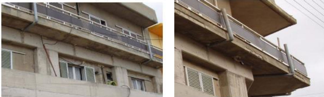
Εικόνες 5.12, 5.13 Τέταρτο στάδιο επισκευής διώροφης κατασκευής με χρήση ΑΣΣ [4].
