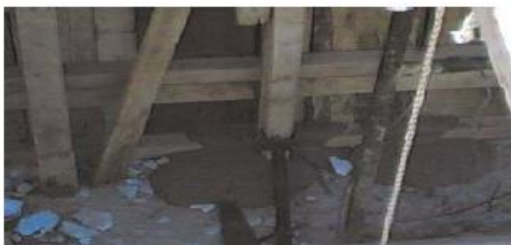
Εικόνες 5.1, 5.2 Παραδείγματα μη στεγανότητας ξυλότυπων .
