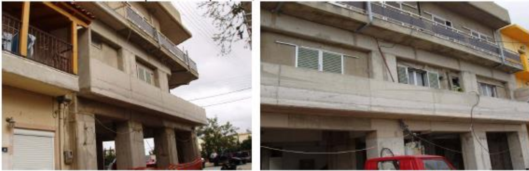
Εικόνες 5.10, 5.11 Τρίτο στάδιο επισκευής διώροφης κατασκευής με χρήση ΑΣΣ [4].
