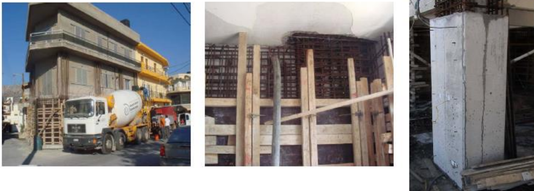
Εικόνες 5.3, 5.4, 5.5 Πρώτο στάδιο επισκευής διώροφης κατασκευής με χρήση ΑΣΣ [4].
