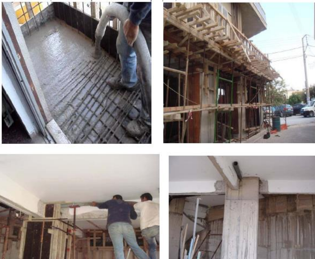
Εικόνες 5.6, 5.7, 5.8, 5.9 Δεύτερο στάδιο επισκευής διώροφης κατασκευής με χρήση ΑΣΣ [4].
