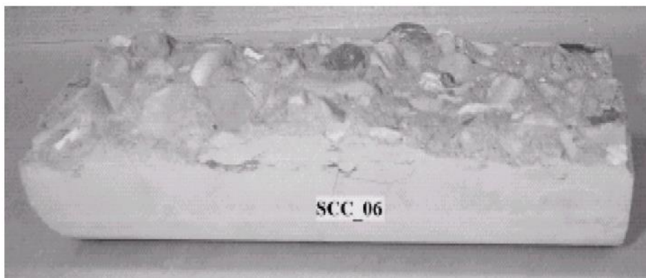
Εικόνες 4.5, 4.6 Μορφή θραυσμένης επιφάνειας δοκιμίου συμβατικού (πάνω) και αυτοσυμπυκνούμενου (κάτω) σκυροδέματος με λόγο νερού/τσιμέντο 0.60 [1].
