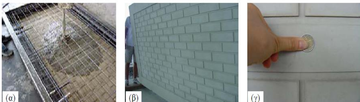
Εικόνα 2.3 (α) Σκυροδέτηση του επίπεδου στοιχείου φράχτη (β) το στοιχείο μετά την απομάκρυνση των πλαστικοτύπων (γ) η άψογη εν επαφή με τον πλαστικοτύπο επιφάνεια [38].
