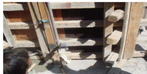
Εικόνες 5.1, 5.2 Παραδείγματα μη στεγανότητας ξυλότυπων .
