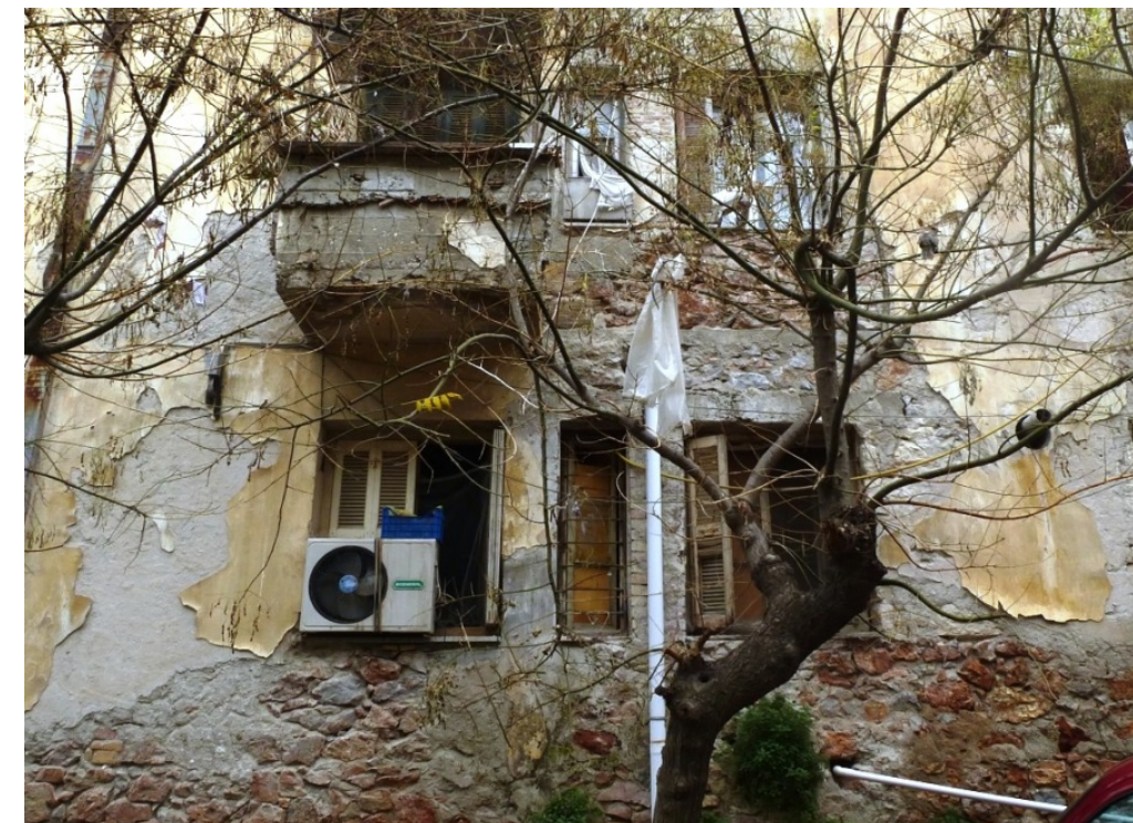
Εικόνα 28: Αποκόλληση λίθων
