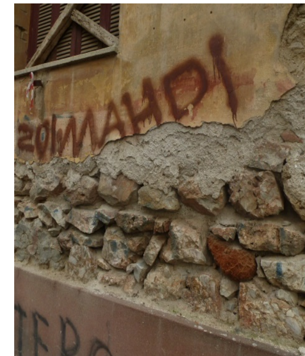
Εικόνα 16: Επιχρισμένη τοιχοποιία
