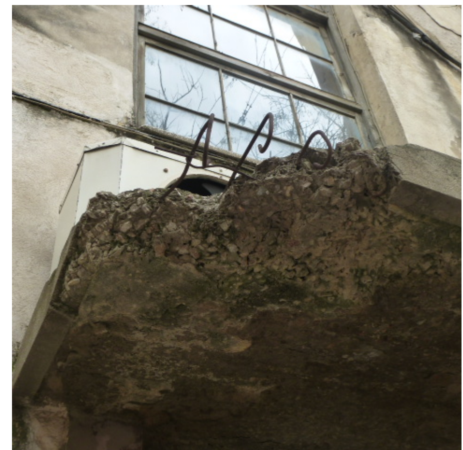
Εικόνα 26: Οξείδωση οπλισμού
