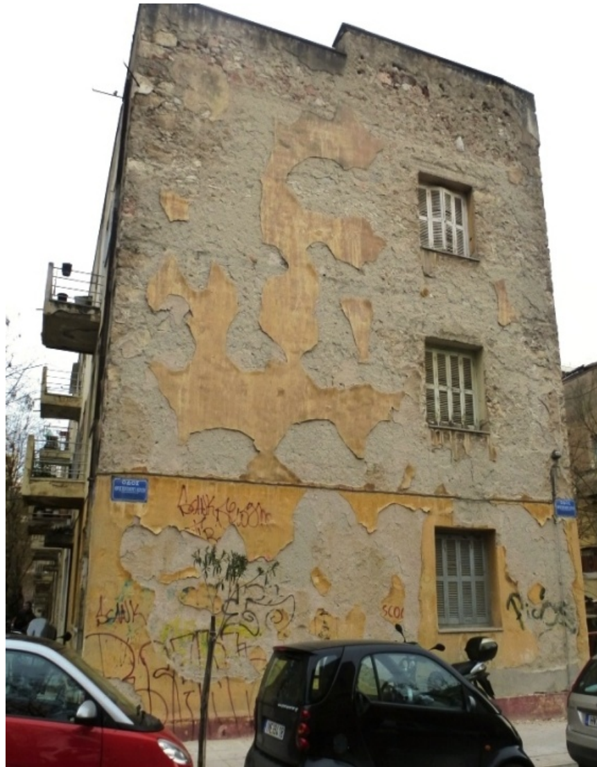
Εικόνα 33: Αποκόλληση σοβά
