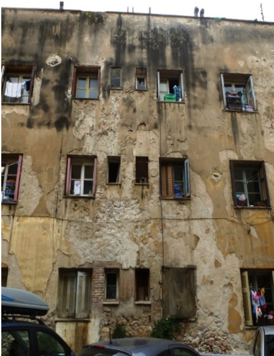
Εικόνα 29: Αποσάθρωση κονιάματος
