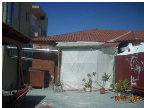
Εικόνα 7. Αποψη Ανατολικής πλευράς
