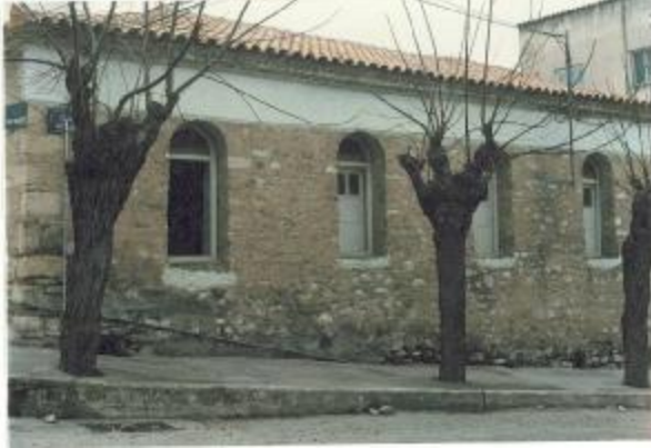
▲ Άποψη του τρόπου δόμησης του κτιρίου αργολιθοδομή
