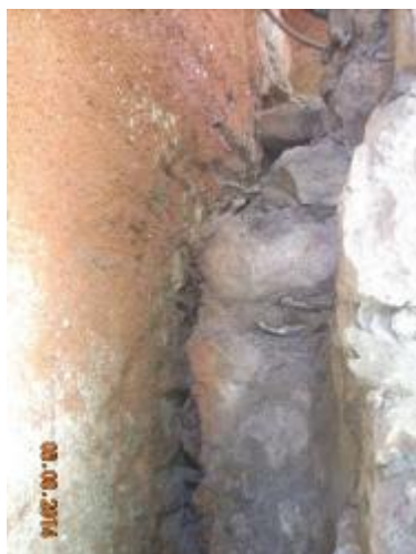
▲ ΤΜΗΜΑ ΤΗΣ ΠΑΛΙΑΣ ΛΙΘΟΔΟΜΗΣ -ΑΡΜΟΣ ΔΙΑΣΤΟΛΗΣ ΜΕ ΤΟ ΜΕΤΑΓΕΝΕΣΤΕΡΟ ΚΤΙΡΙΟ
