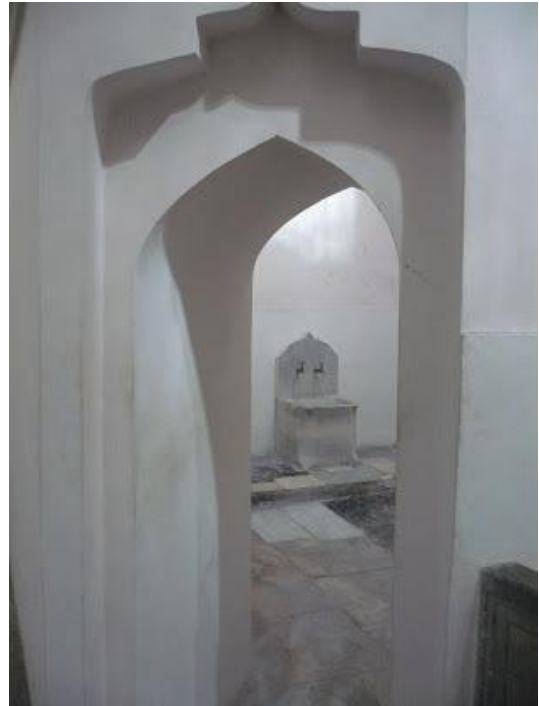
▲ Πτυχωτό ημιχώνιο του θερμού χώρου του ανδρικού τμήματος του λουτρού και εσωτερικό άνοιγμα με σύνθετη απόληξη. (εικ. Google)
