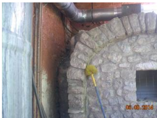
▲ ΤΜΗΜΑ ΤΗΣ ΠΑΛΙΑΣ ΛΙΘΟΔΟΜΗΣ -ΑΡΜΟΣ ΔΙΑΣΤΟΛΗΣ ΜΕ ΤΟ ΜΕΤΑΓΕΝΕΣΤΕΡΟ ΚΤΙΡΙΟ
