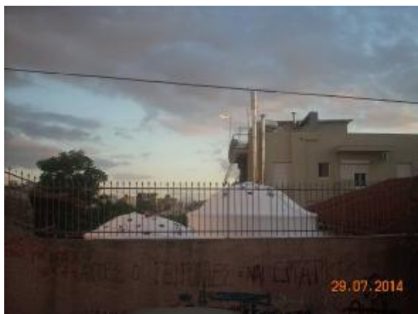
Εικόνα 6. Αποψη βορειοδυτικής πλευράς
