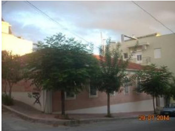
Εικόνα 1. Βορειοδυτική όψη του κτιρίου
