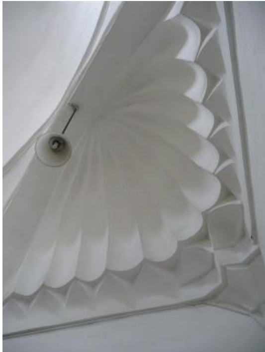
▲ Πτυχωτό ημιχώνιο του θερμού χώρου του ανδρικού τμήματος του λουτρού και εσωτερικό άνοιγμα με σύνθετη απόληξη. (εικ. Google)
