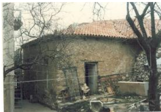
▲ ΝΟΤΙΑ ΑΝΑΤΟΛΙΚΗ ΠΛΕΥΡΑ ΤΟΥ ΚΤΙΡΙΟΥ
