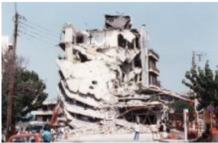
Εικ.38 Η πολυκατοικία κατεδαφίστηκε το 1995
