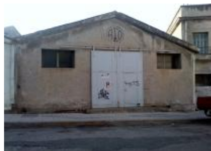
Εικ.48 Εμφάνιση οπτόπλινθων λόγω αποκόλλησης τμήματος του επιχρίσματος
