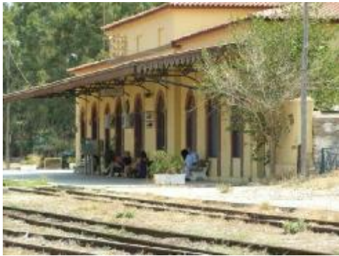
Εικ.36 Ο σταθμός σε λειτουργία
