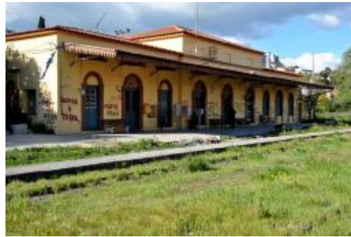
Εικ.37 Ο σταθμός όπως είναι σήμερα
