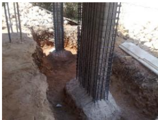
Εικ.99 Οπλισμός υποστυλώματος
