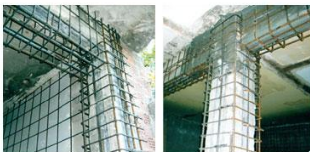
Εικ.101,102 Οπλισμός ένωσης δοκαριού με υποστήλωμα
