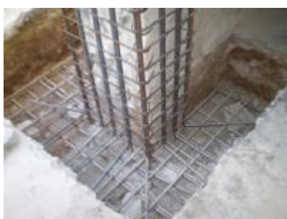
Εικ.100 Οπλισμός θεμελίωσης υποστυλώματος
