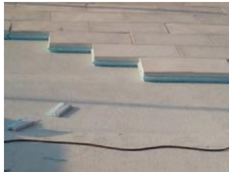
Εικ.106 Τοποθέτηση πλακιδίων
