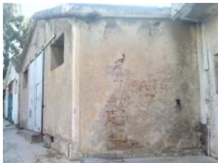
Εικ.48 Εμφάνιση οπτόπλινθων λόγω αποκόλλησης τμήματος του επιχρίσματος
