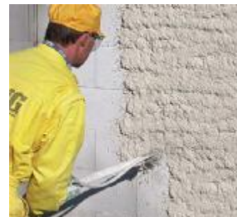
Εικ.89 Τοποθέτηση επιχρίσματος
