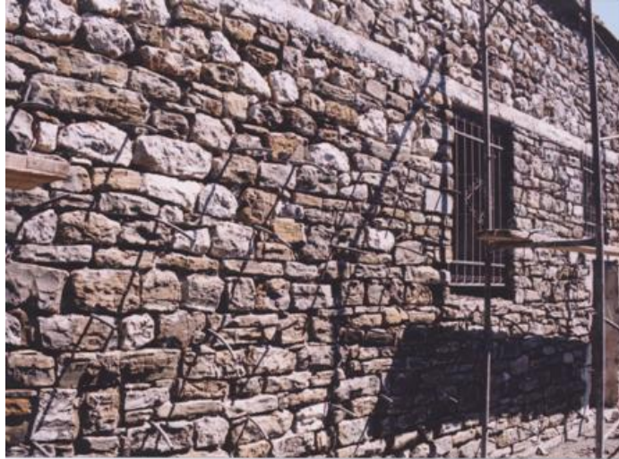
Εικ. 72: Τοποθέτηση σωλήνων ενεμάτων ανά 50 εκ.
