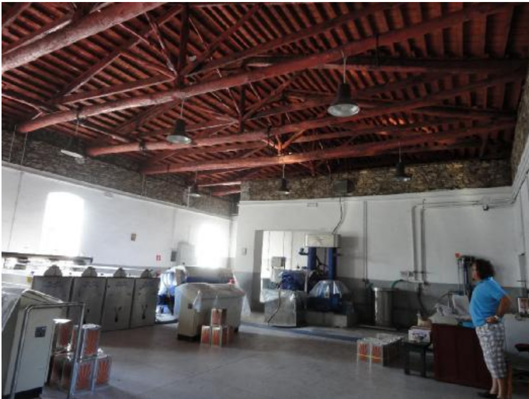
Εικ. 32: Βιομηχανικό δάπεδο
