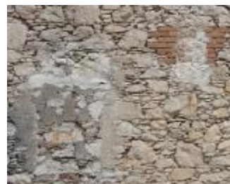
Εικ. 49: Επισκευές σε απώλειες αρμού με τσιμεντοκονίαμα
