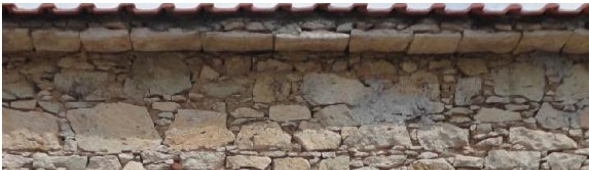
Εικ. 23: Λίθινο γείσο κάτω από τη στέγη του αρχικού κτίσματος
