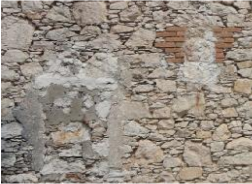
Εικ. 41: Μπόλωμα με τσιμεντοκονίαμα και συμπλήρωμα με οπτοπλινθοδομή
