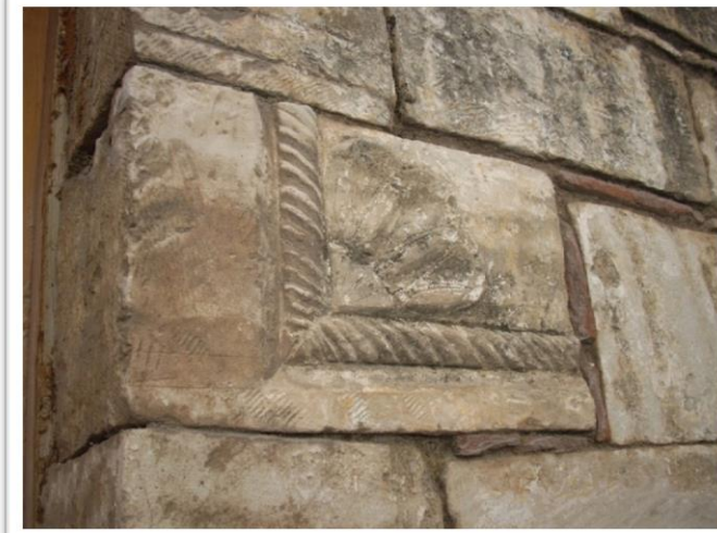
Εικόνα 13. Ανάγλυφο στον εξωτερικό μαντρότοιχο. Πηγή: Προσωπικό αρχείο.
