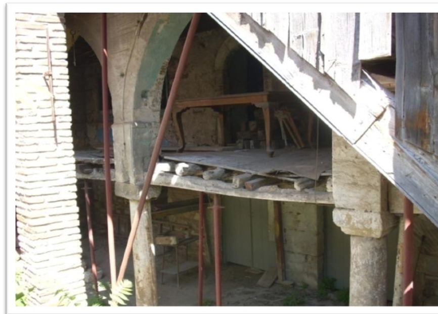
Εικόνα 21. Χαμώι και μετζοπάτωμα με τις οξύρυγχες καμάρες και τους κιονίσκους που τις φέρουν. Πηγή: Προσωπικό αρχείο.
