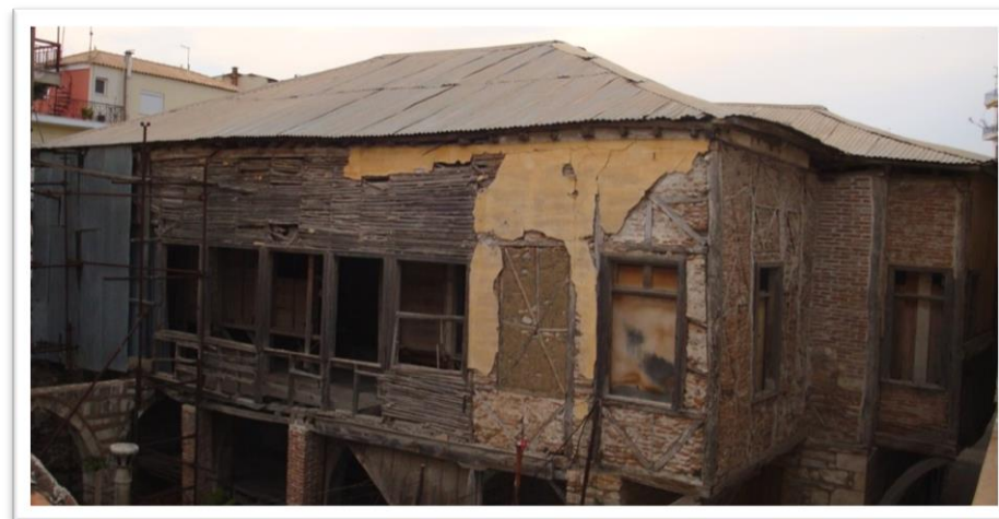
Εικόνα 1. Άποψη αρχοντικού από γειτονικό κτήριο. Πηγή: Προσωπικό αρχείο.
