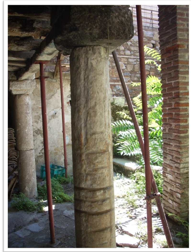
Εικόνα 33. Κιονίσκοι που φέρουν το πάτωμα του μετσοπατώματος. Πηγή: Προσωπικό αρχείο.
