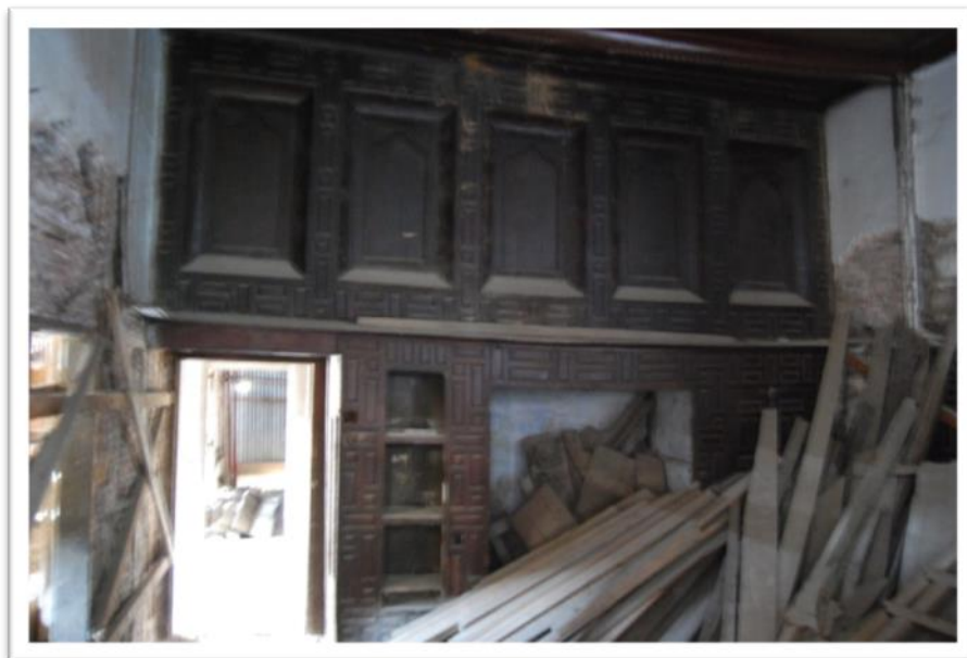
Εικόνα 27. Ξύλινες νταμπλαδωτές μεσάντρες. Πηγή: Προσωπικό αρχείο.
