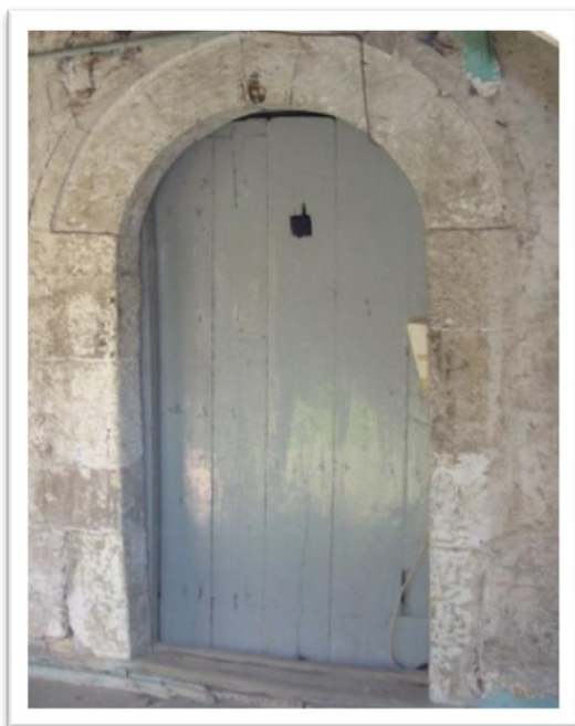
Εικόνα 37. Πόρτα εισόδου στο χαμώι. Πηγή: Προσωπικό αρχείο.
