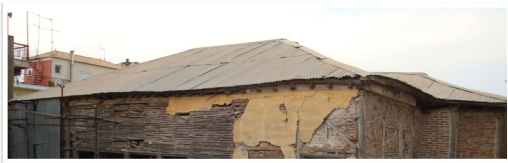
Εικόνα 34. Νοτιοανατολική όψη στέγης. Πηγή: Προσωπικό αρχείο.
