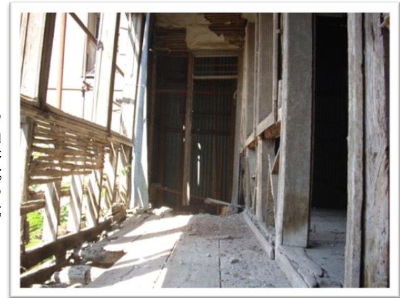
Εικόνα 23. Εσωτερική άποψη χαγιατιού. Πηγή: Προσωπικό αρχείο.
