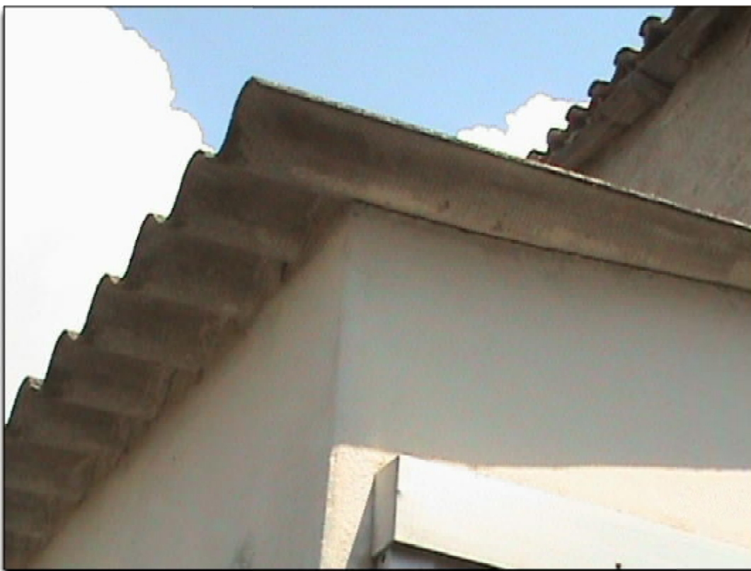
Εικόνες 98,99 : οροφή ισογείου από ελενίτ
