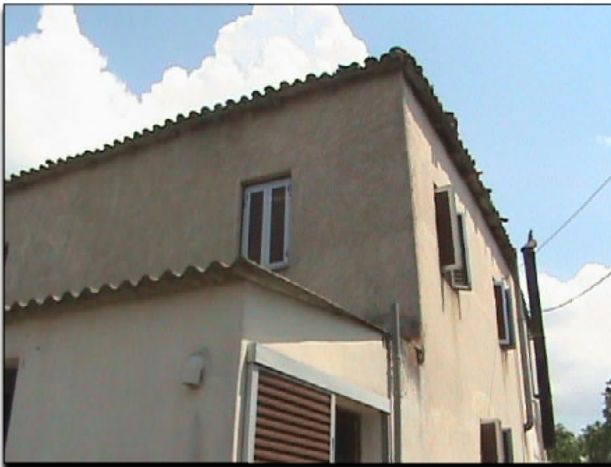
Εικόνες 98,99 : οροφή ισογείου από ελενίτ
