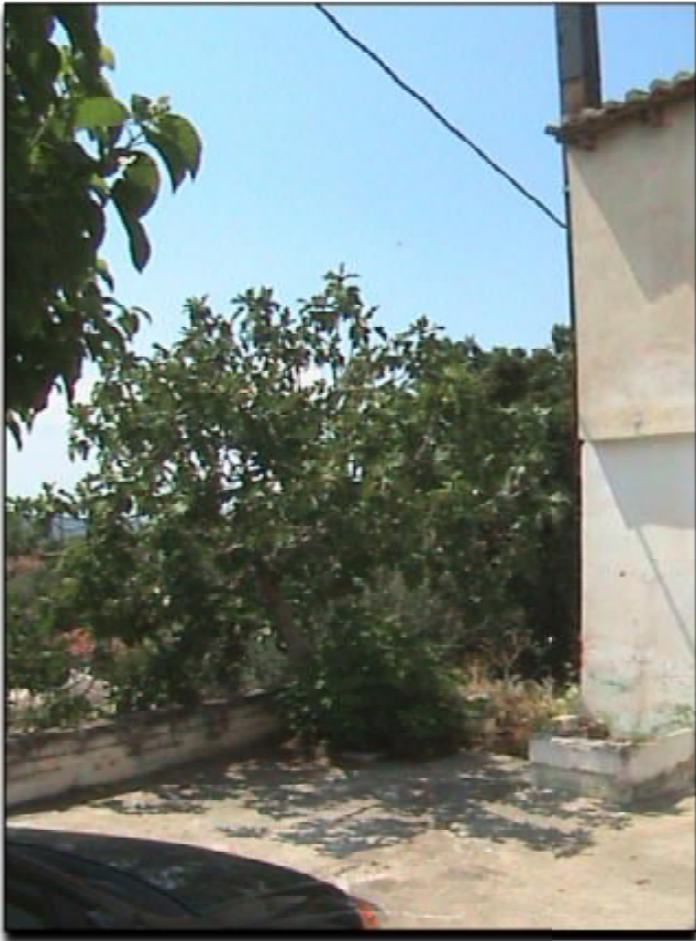
Εικόνα 135 : σκυρόδεμα περίφραξης (μέχρι σημείο Γ)
