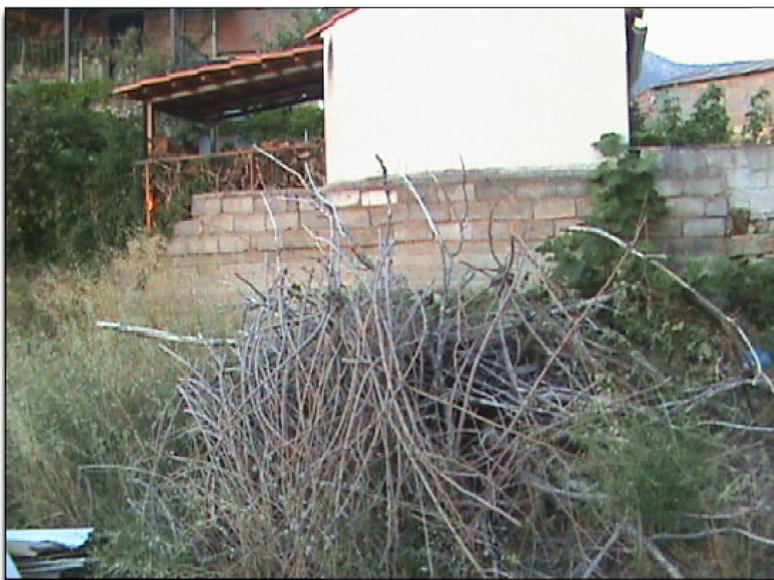
Εικόνα 144: μέρος πλευράς 2-1, περίφραξη από σκυρόδεμα-τσιμεντόλιθους
