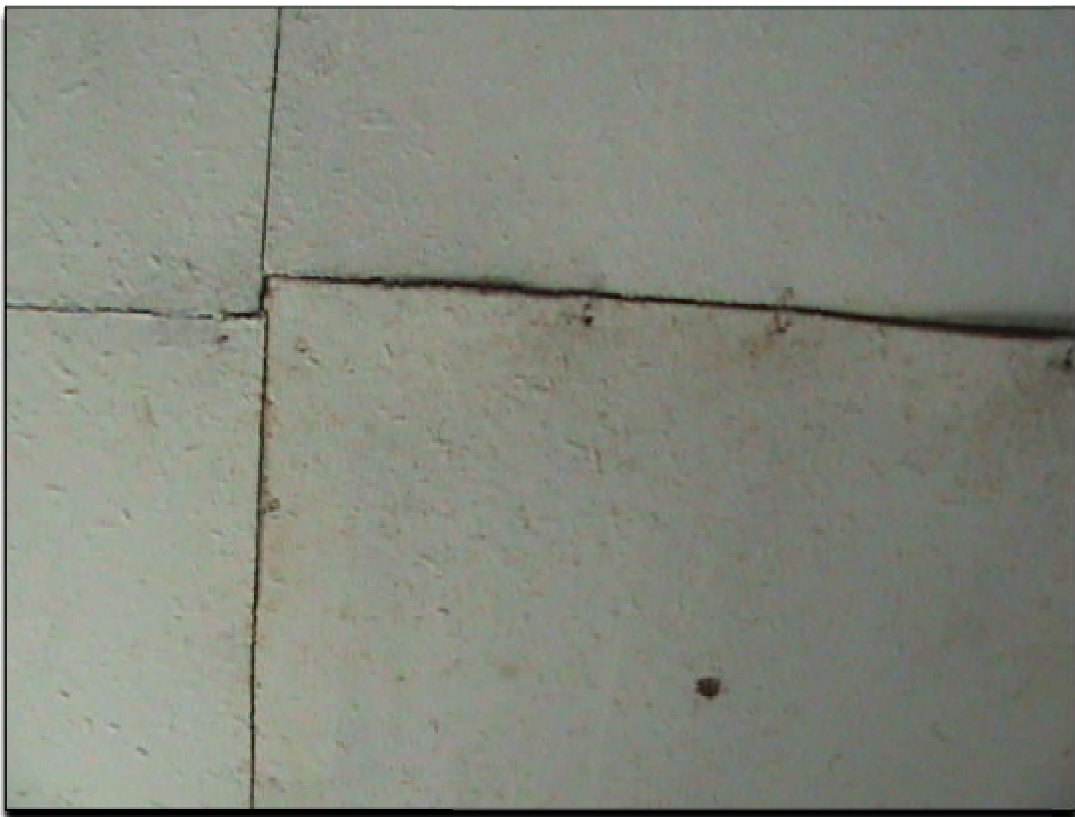
Εικόνες 81,82 : οροφή σαλονιού από νοβοπάν
