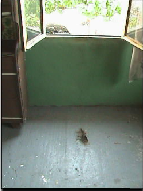
Εικόνα 79 :πάνω μέρος της πλάκας της οροφής, φαίνεται ο οπλισμός της πλάκας
