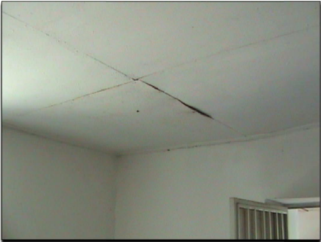
Εικόνες 81,82 : οροφή σαλονιού από νοβοπάν
