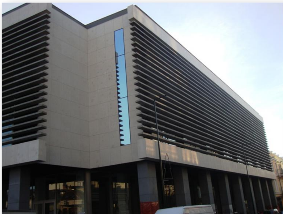
Εικόνα 3:ΥΠΟ ΓΩΝΙΑ ΑΠΟΨΗ ΤΩΝ ΟΨΕΩΝ ΤΟΥ ΚΤΗΡΙΟΥ
