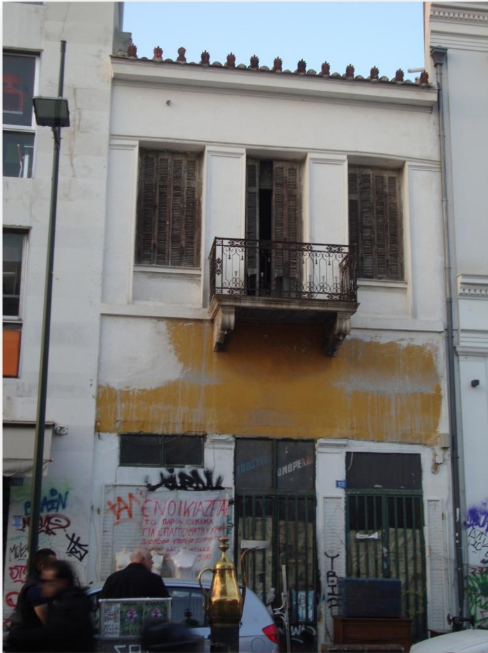
Εικόνα 4: ΟΨΗ ΤΟΥ ΚΤΗΡΙΟΥ
