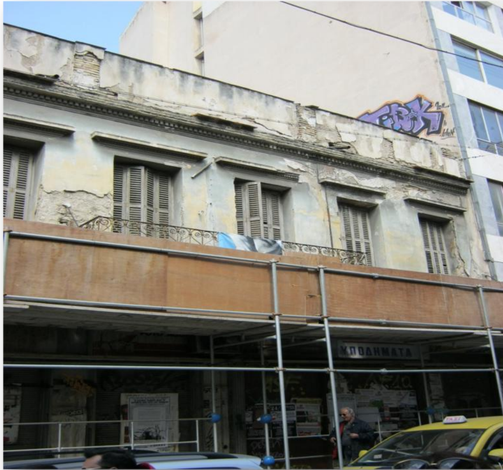
Εικόνα 4: Η ΟΨΗ ΤΟΥ ΚΤΗΡΙΟΥ
