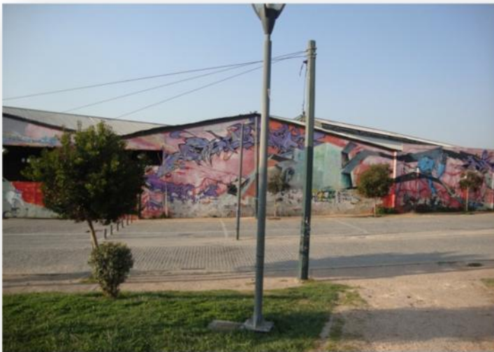
Εικόνα 5 : ΤΜΗΜΑ ΟΨΗΣ ΚΤΗΡΙΟΥ 'ΗΛΠΑΠ'
