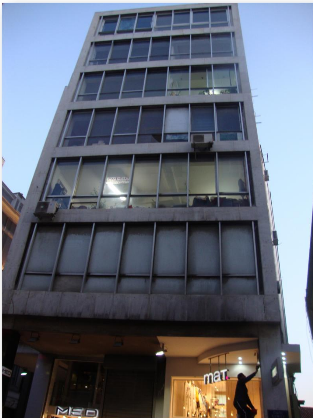
Εικόνα 3: ΟΨΗ ΤΟΥ ΚΤΗΡΙΟΥ
