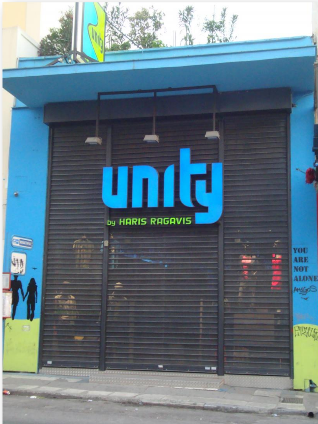
Εικόνα 3: Η ΟΨΗ ΤΟΥ ΚΤΗΡΙΟΥ
