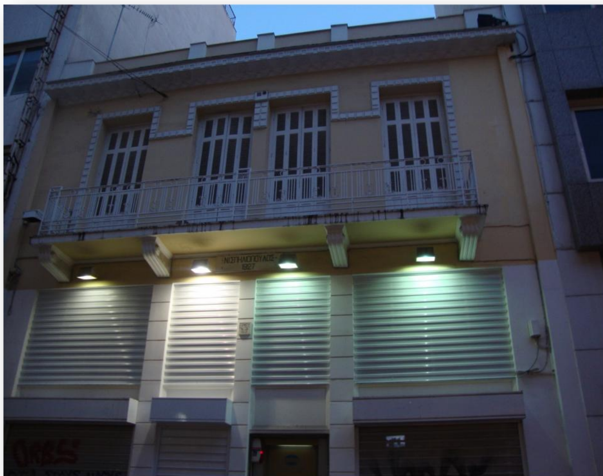
Εικόνα 4: ΟΨΗ ΤΟΥ ΚΤΗΡΙΟΥ
