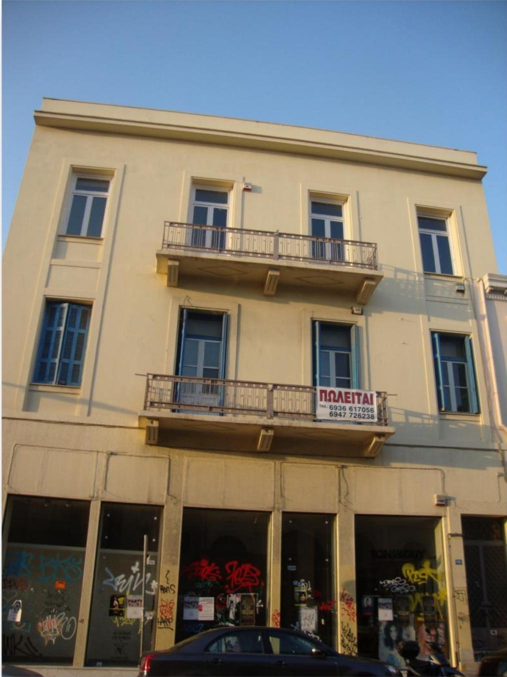
Εικόνα 3: ΟΨΗ ΤΟΥ ΚΤΗΡΙΟΥ
