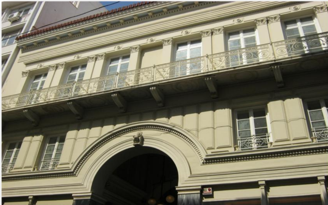
Εικόνα 7: ΟΙ ΟΡΟΦΟΙ ΣΤΟ ΚΤΗΡΙΟ
