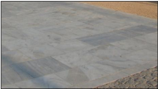
Εικόνα 35: ΤΜΗΜΑΤΙΚΗ ΑΛΛΑΓΗ ΤΗΣ ΠΛΑΚΟΣΤΡΩΣΗΣ ΜΕ ΚΥΒΟΛΙΘΟΥΣ ΑΠΟ ΠΛΑΚΑΚΙΑ
