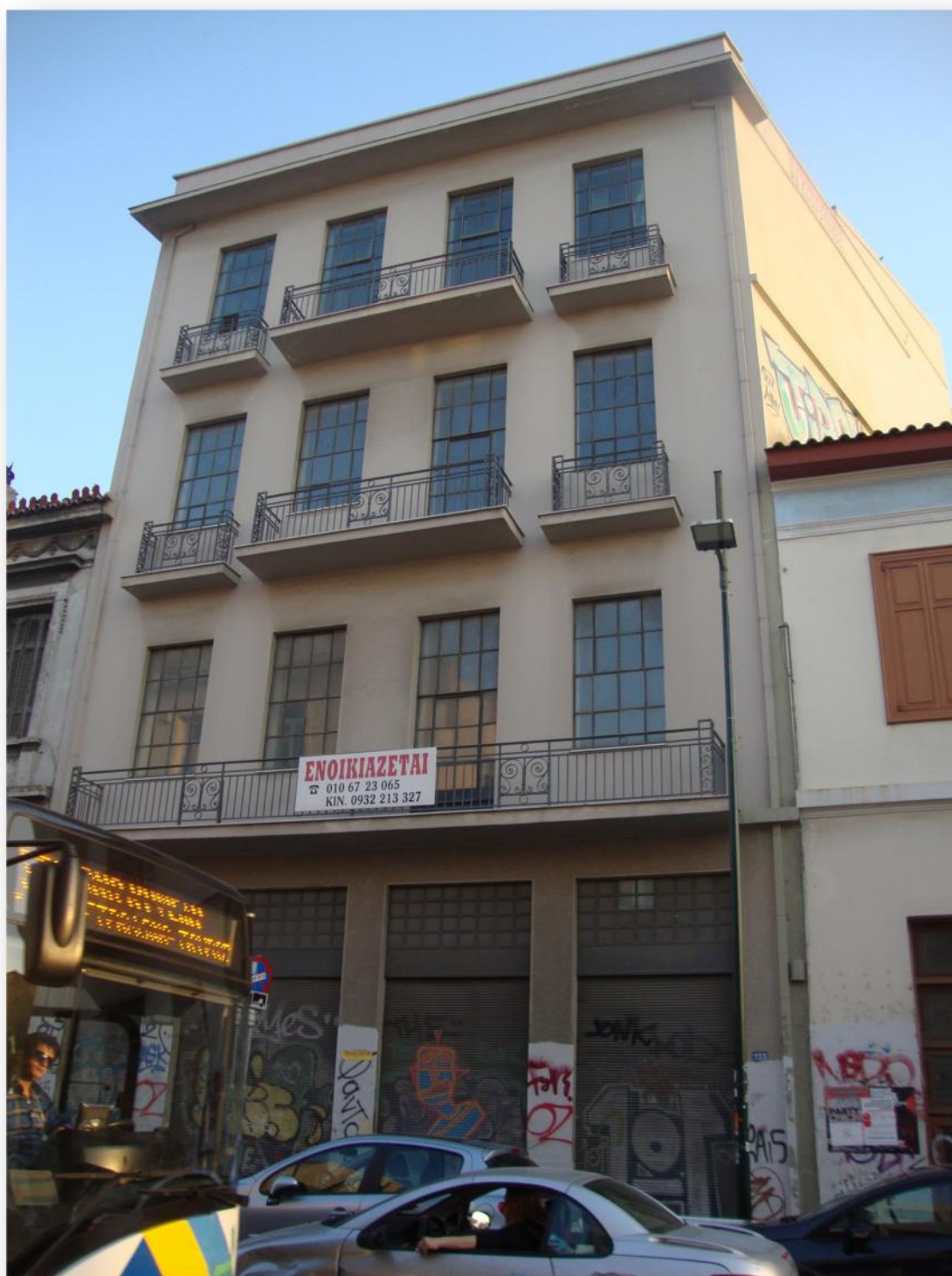
Εικόνα 4: ΟΨΗ ΤΟΥ ΚΤΗΡΙΟΥ
