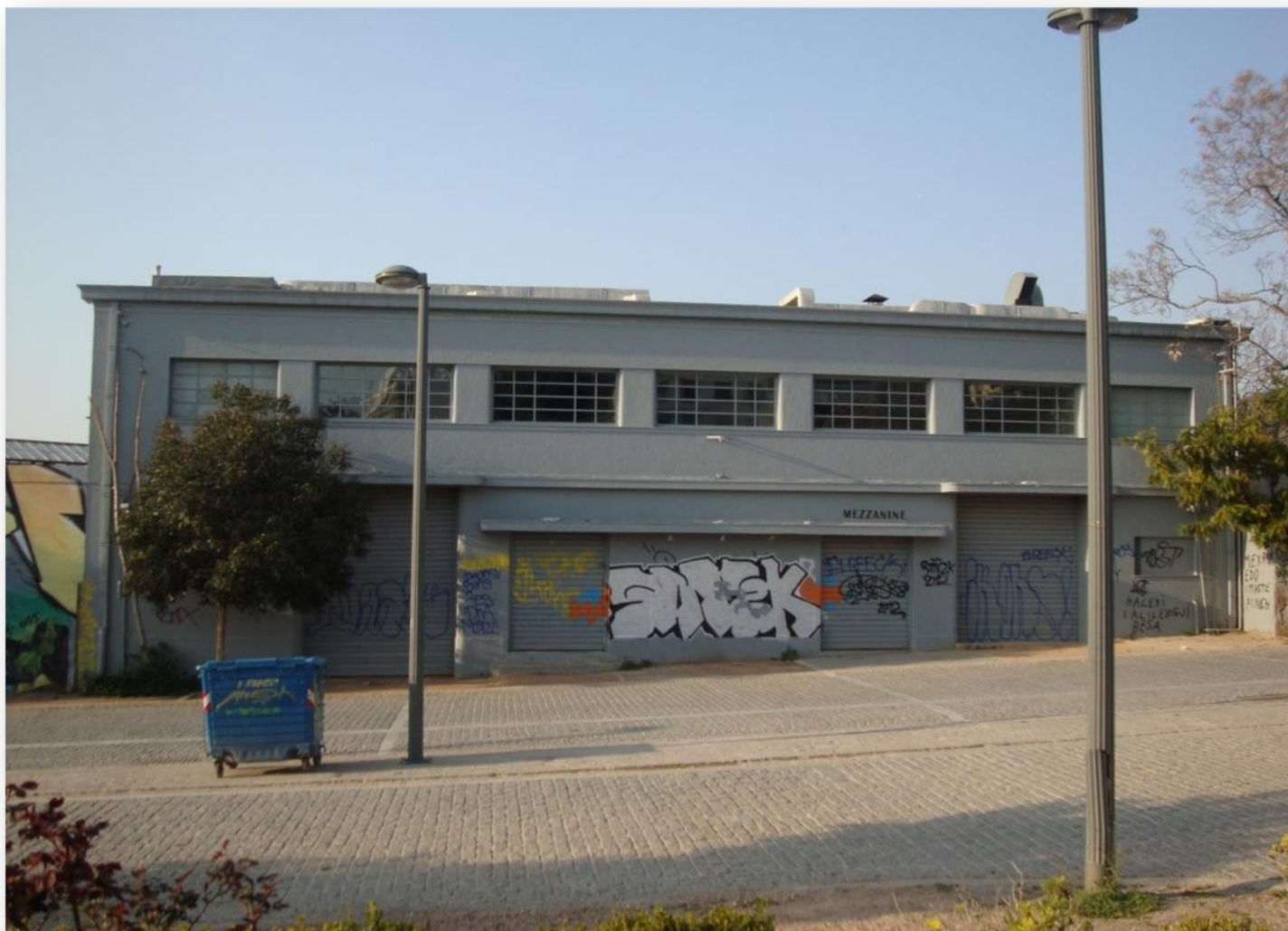
Εικόνα 3: Η ΣΗΜΕΡΙΝΗ ΟΨΗ ΤΟΥ ΚΤΗΡΙΟΥ
