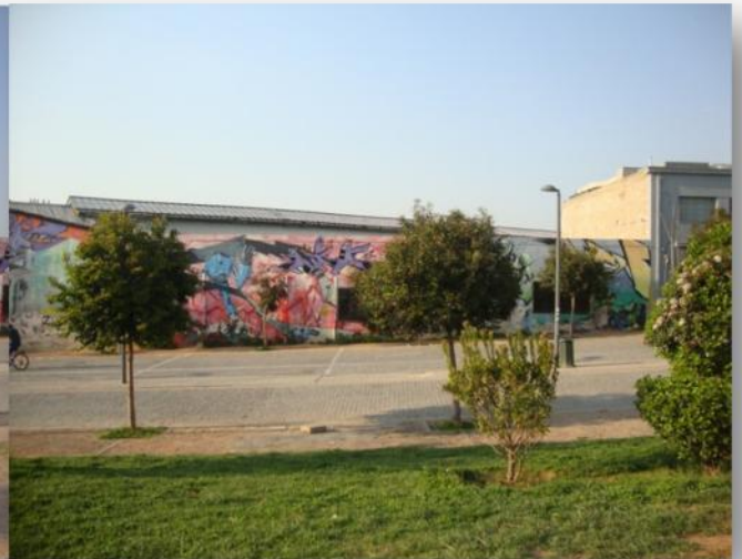
Εικόνα 6 : ΤΜΗΜΑ ΟΨΗΣ ΚΤΗΡΙΟΥ 'ΗΛΠΑΠ'
