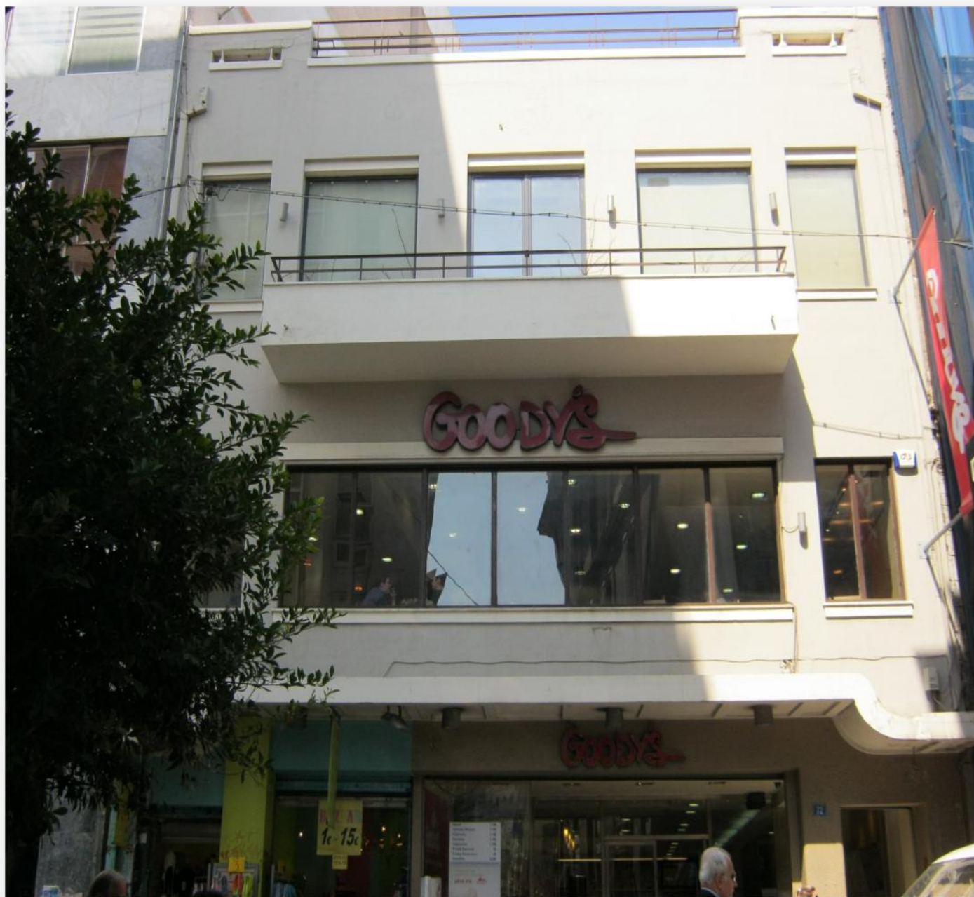
Εικόνα 3: Η ΟΨΗ ΤΟΥ ΚΤΗΡΙΟΥ
