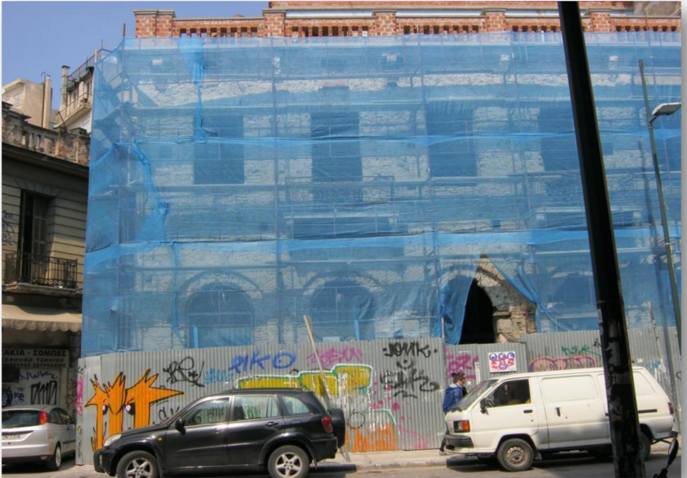
Εικόνα 4: ΟΨΗ ΤΟΥ ΚΤΗΡΙΟΥ
