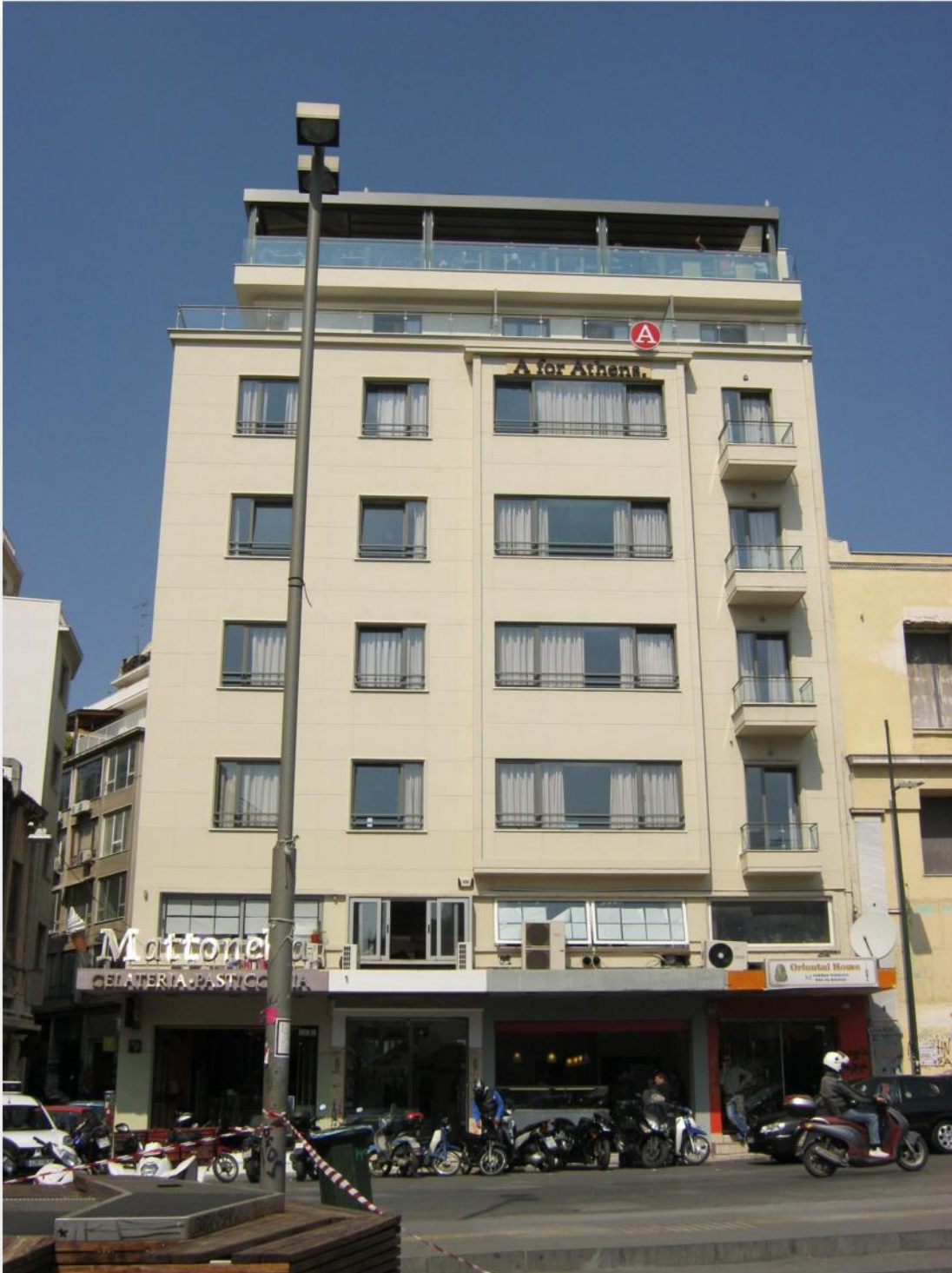
Εικόνα 3: Η ΟΨΗ ΤΟΥ ΚΤΗΡΙΟΥ
