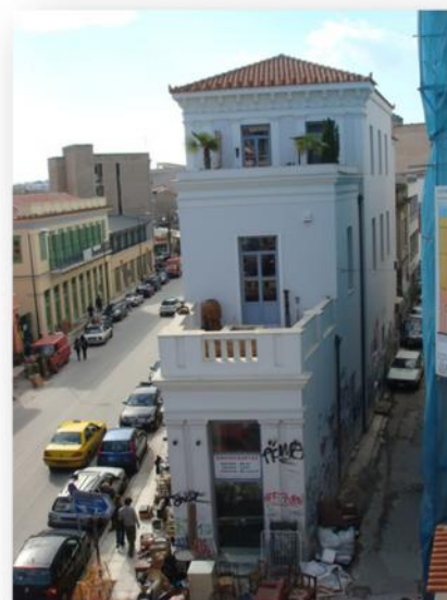
Εικόνα 7: ΠΛΑΓΙΑ ΟΨΗ ΤΟΥ ΚΤΗΡΙΟΥ
