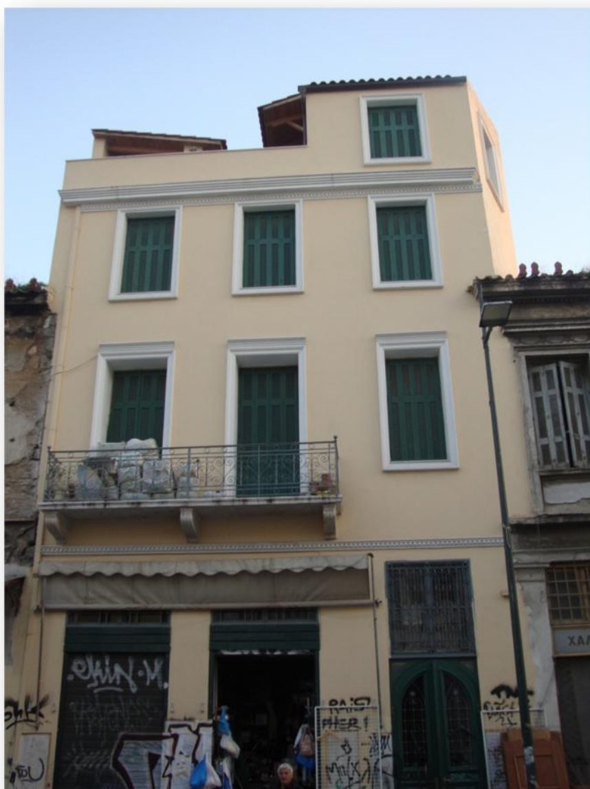
Εικόνα 2: ΟΨΗ ΤΟΥ ΚΤΗΡΙΟΥ
