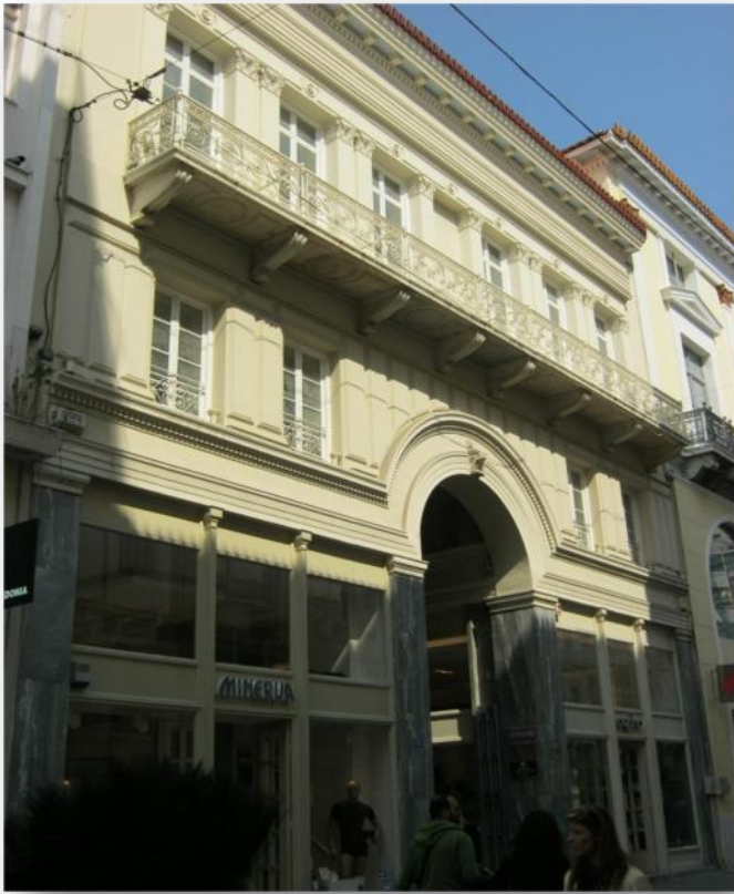
Εικόνα 5: ΟΨΗ ΤΟΥ ΚΤΗΡΙΟΥ
