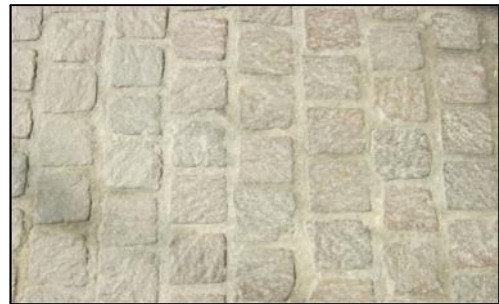
Εικόνα 31: ΠΛΑΚΟΣΤΡΩΣΗ ΜΕ ΚΥΒΟΛΙΘΟΥΣ
