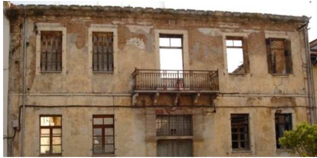
Εικόνα 70: Κατάσταση κουφωμάτων
