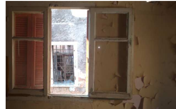
Εικόνα 58: Παράθυρο στον όροφο στη ΝΔ πλευρά.
