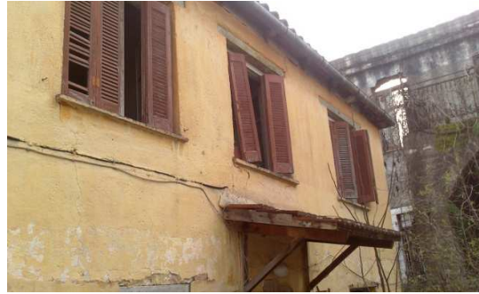
Εικόνα 12 : Βορειοδυτική όψη ορόφου βοηθητικού κτιρίου
