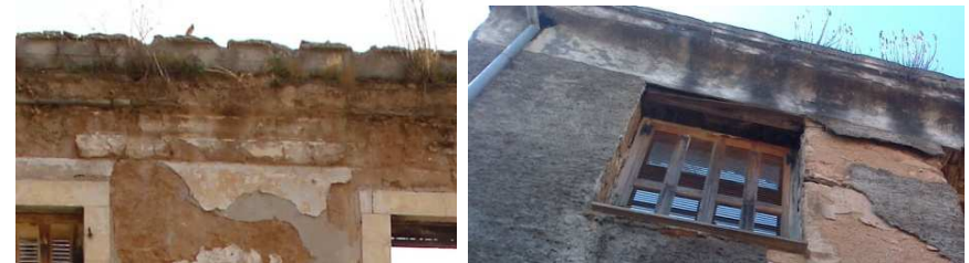
Εικόνα 71-72: Γείσο στην κύρια όψη και πίσω όψη .
