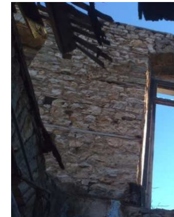
Εικόνα 34 : Εμφανής τοιχοποιία και ξυλοδεσιές στην εσωτερική πλευρά του κτιρίου
