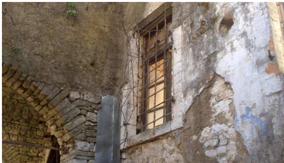
Εικόνα 47: Παραθυρο οροφου ΒΑ πλευράς.
