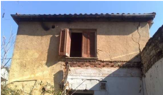
Εικόνα 35 : Εμφανής τοιχοποιία από τούβλο στον όροφο.
