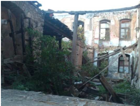
Εικόνα 17 : εσωτερική Βορειοανατολική όψη κτιρίου.
