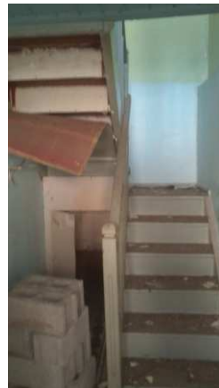
Εικόνα 44 : Ξύλινη σκάλα για την ανάβαση στον όροφο στο κτίριο (Κ2)
