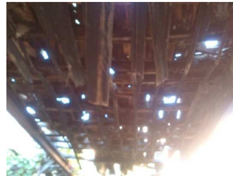
Εικόνα 68: Τμήμα οροφής σε 2/οροφη κατοικία.
