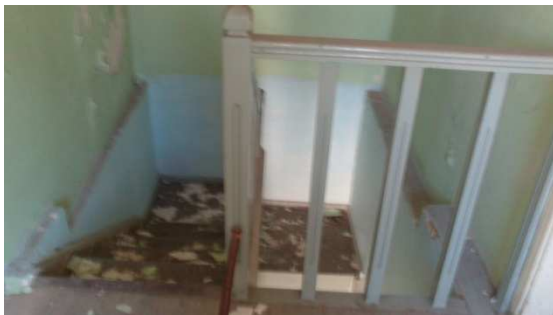
Εικόνα 55: Άποψη κλίμακας από τον όροφο .
