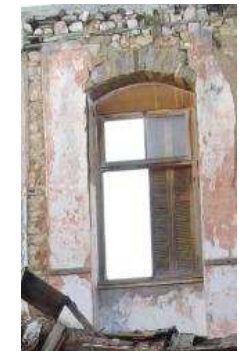
Εικόνα 48: Εσωτερική όψη με ανακουφιστικό τόξο
