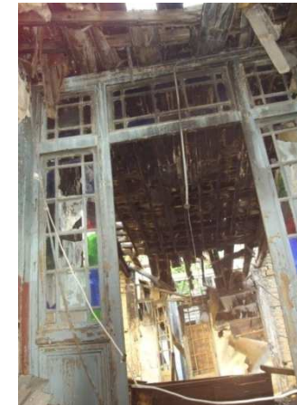
Εικόνα 53: Πόρτα στο εσωτερικό χώρο.
