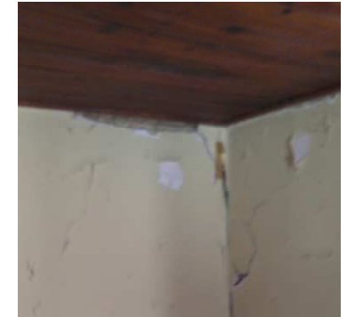
Εικόνα 69: Τμήμα οροφής στο 2/οροφο βοηθ. κτίριο
