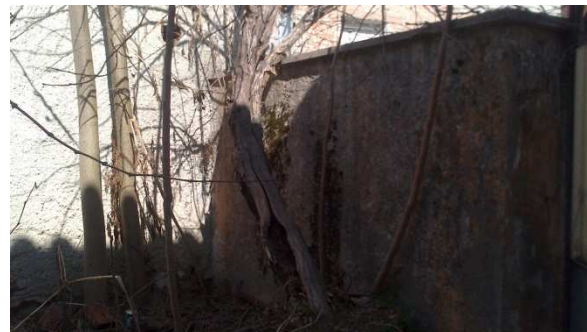
Εικόνα 51: Τοιχοποιία – περίφραξη προς την οδό Τούτσισα
