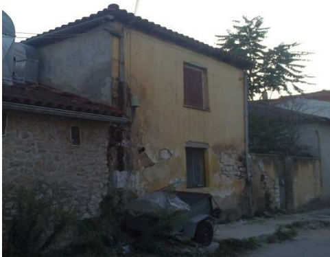
Εικόνα 11 : Βορειοανατολική όψη 2/οροφου βοηθ. κτιρίου
