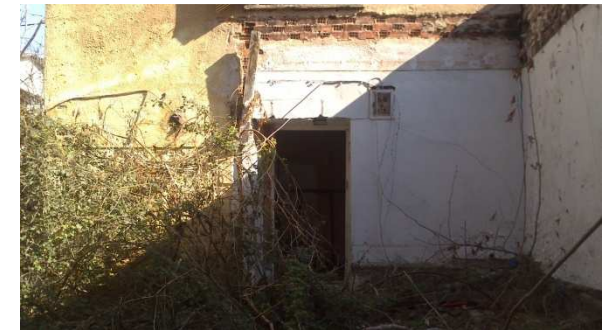
Εικόνα 15: Νοτιοδυτική όψη ισόγειου βοηθητικού κτιρίου
