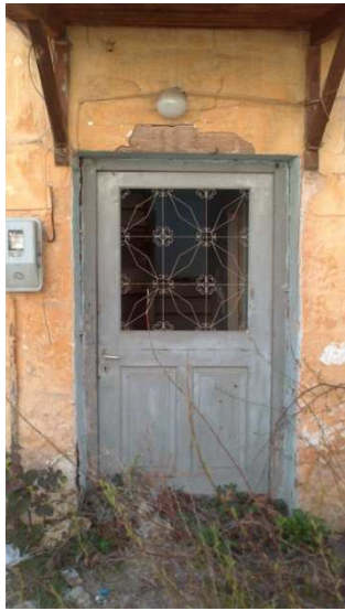
Εικόνα 31: Πόρτα εισόδου στον 2/οροφο βοηθ. χώρο.
