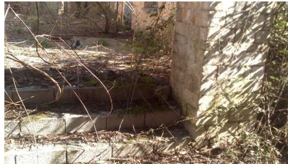
Εικόνα 42: Σκαλοπάτια που αντικαταστάθηκαν από τσιμεντότουβλα.
