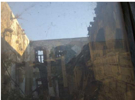
Εικόνα 19 : εσωτερική Βορειοδυτική όψη κτιρίου .
