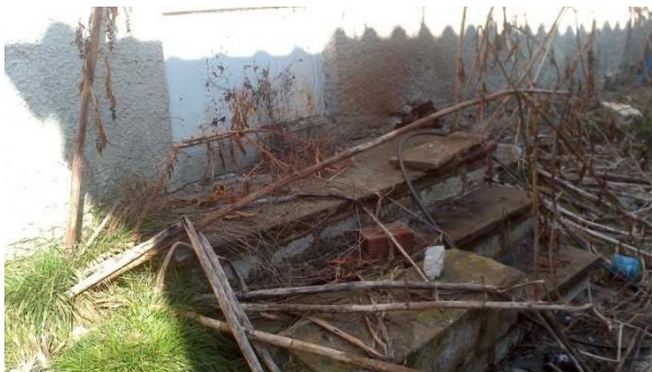
Εικόνα 48: Σκαλοπάτια για την είσοδο στο ισόγειο βοηθ. χώρο
