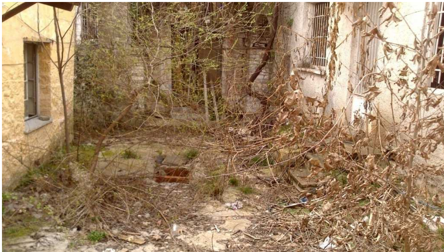
Εικόνα 63 : Άποψη περιβάλλοντος χώρου-αυλή.
