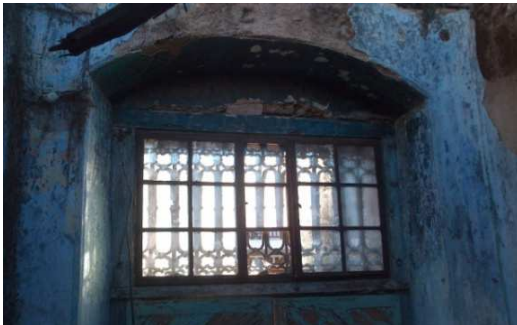
Εικόνα 25 : Φεγγίτης από την εσωτερική πλευρά.
