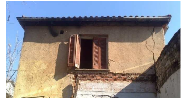
Εικόνα 14: Νοτιοδυτική όψη ορόφου βοηθητικού κτιρίου
