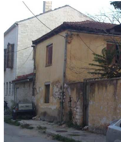
Εικόνα 30 : Διώροφο κτίριο Κ2
