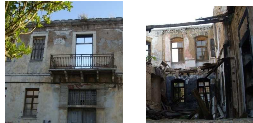
Εικόνα 39-40 : Επιχρισμένοι τοίχοι εξωτερικά και εσωτερικά του κτιρίου.
