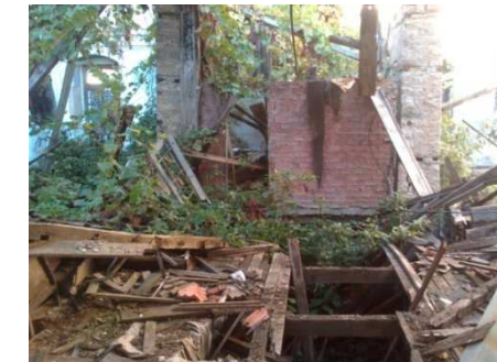
Εικόνα 23 : Δημιουργία χώρου ως στο εσωτερικό του Κτιρίου.
