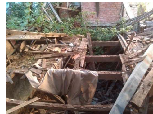
Εικόνα 24 : Κατεστραμμένο δάπεδο στο ισόγειο.
