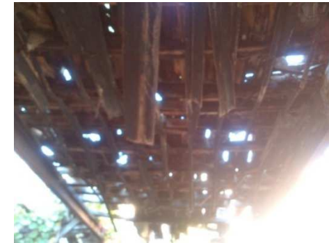
Εικόνα 22 : Τμήμα οροφής στη είσοδο της Ν.Δ. όψης.
