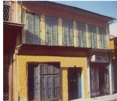
Εικόνα 12 : Κτίριο με χρήση κατοικία και κατάστημα στο ισόγειο.
