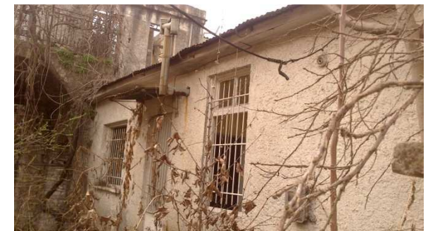
Εικόνα 16: Νοτιοανατολική όψη ισόγειου βοηθ./κου κτιρίου
