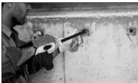
Τοποθέτηση νέας ράβδου σε starter bar system της Lenton(Form Saver)
