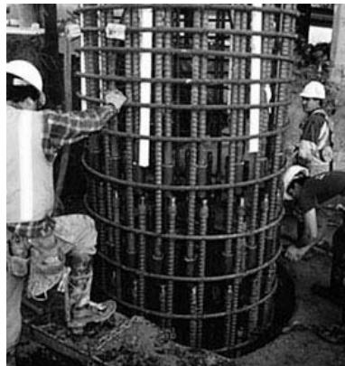
Προκατασκευασμένος κλωβός οπλισμού με χρήση position couplers
