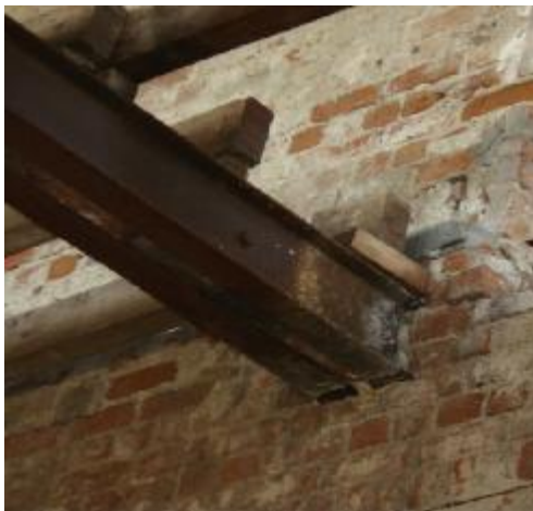
Εικ.35 Η μεταλλική δοκός του πατώματος του ορόφου στην ανατολική πτέρυγα
