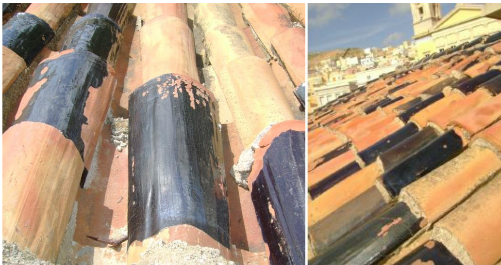
Εικόνα 40 Κάποια από τα κεραμίδια της στέγης φαίνεται ότι σε κάποια από τις φάσεις των επισκευών αντικαταστάθηκαν με νέα κοινά βιομηχανοποιημένα χωρίς εφύαλωση. Τόσο τα νεότερα όσο και τα αρχικά ήταν βυζαντινού τύπου όμοια σε μέγεθος.
