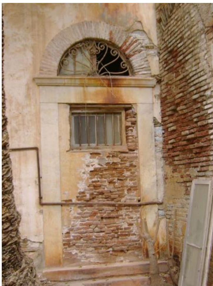
Εικόνα 12 Ο δυτικός τοίχος του κυρίως κτίσματος
