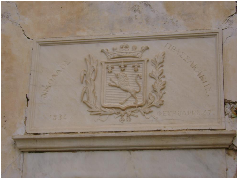
Εικόνα 10 Μαρμάρινη πλάκα με την χρονολογία του κτιρίου
