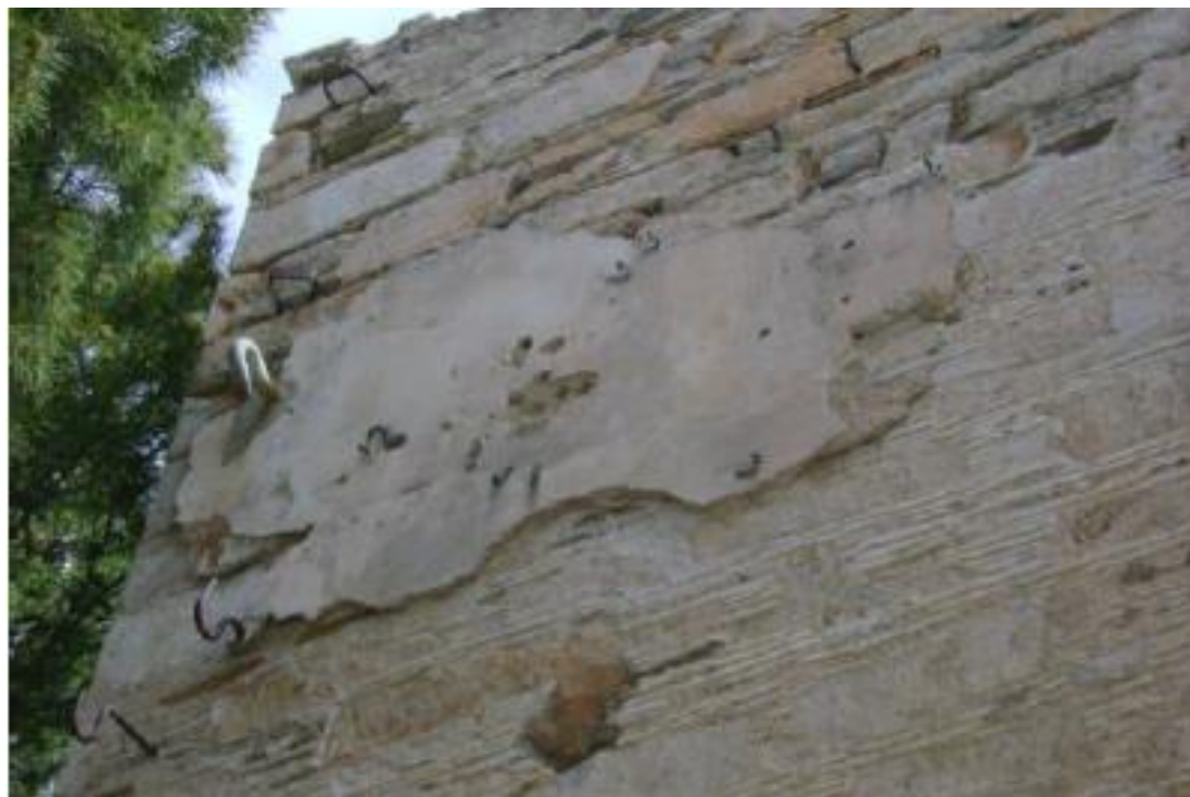
Εικόνα 10 Φαινόμενα αποσάθρωσης παρατηρούνται και στο κονίαμα δομής σε όλους ανεξαιρέτως τους εξωτερικούς τοίχους.
