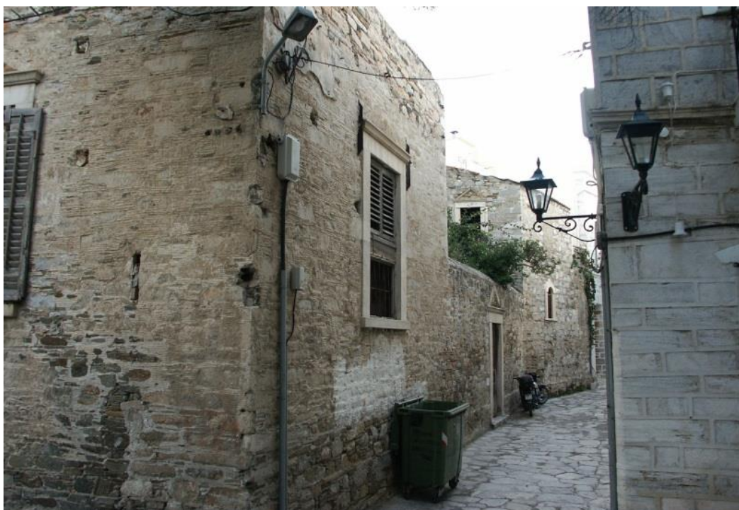
Εικόνα 19 Βορειοδυτική όψη του κτίσματος
