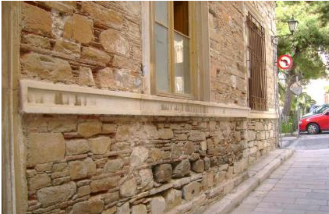
Εικόνα 31 Στις εξωτερικές όψεις όλα τα πλαίσια των ανοιγμάτων είναι κατασκευασμένα από ίδιο λευκό μάρμαρο
