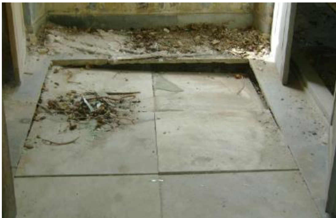
Εικόνα 9 Στους περισσότερους βοηθητικούς χώρους τα δάπεδα είναι επίσης καλυμμένα με λίθινες πλάκες,
