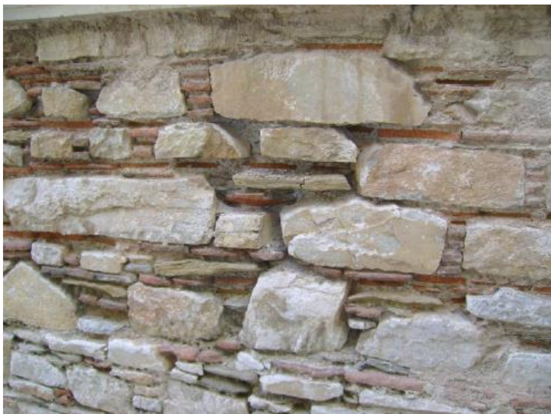
Εικόνα 21 Οι τοιχοποιίες αποτελούνται από αργούς πλακοειδείς λίθους μεσαίου μεγέθους (διαστάσεων περίπου 50X20X20 εκ.).
