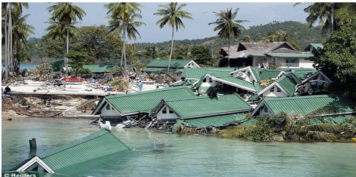
Φωτογραφία 10: Καταστροφές σε ξύλινες κατασκευές.
