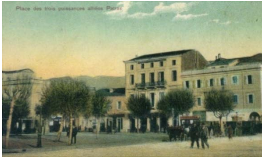
Εικόνα 60. Το "Μέγα ξενοδοχείον των Ξένων" είναι το ψηλό κτίριο, επί της Αγ. Ανδρέου και δε-ξιά το παράρτημα του. Μεσοπολεμικά ονομάστη-κε «ΔΕΛΦΟΙ» και δεν είχε παράρτημα. Στο κάτω μέρος της κάρτας είναι η επέκταση της πλατείας μετά την κατεδάφιση του τελωνείου το 1907.
