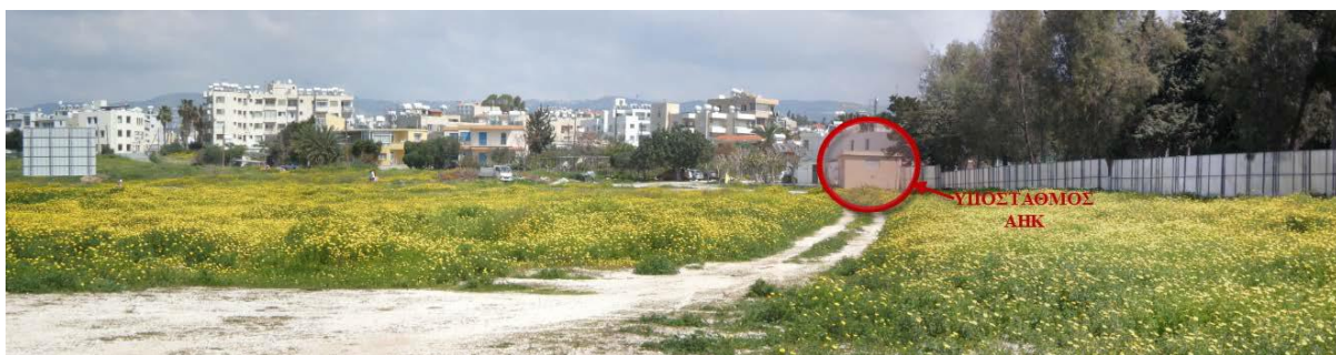
Εικόνα 4: Στην πιο πάνω φωτογραφία φαίνεται η νοτιοανατολική πλευρά του εργοταξιακού χώρου (Τεμ.315). Στην ίδια φωτογραφία φαίνεται ο υφιστάμενος υποσταθμός της ΑΗΚ.
