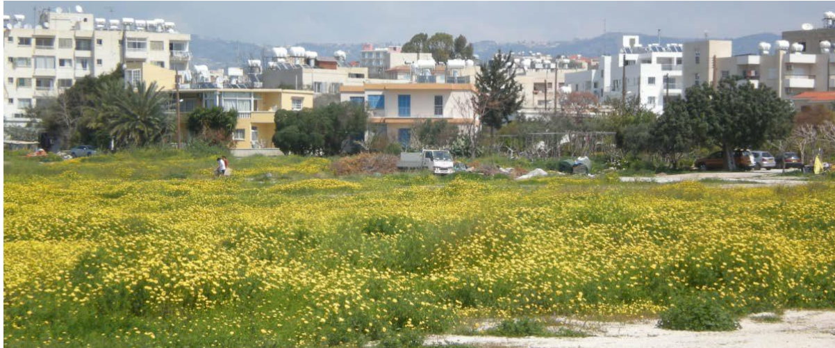
Εικόνα 5: Στην πιο πάνω φωτογραφία φαίνεται η ανατολική πλευρά του εργοταξιακού χώρου (Τεμ.362). Στην ίδια φωτογραφία φαίνονται ιδιωτικές κατοικίες οι οποίες γειτνιάζουν στα δυτικά με τον εργοταξιακό χώρο(Τεμ.362).
