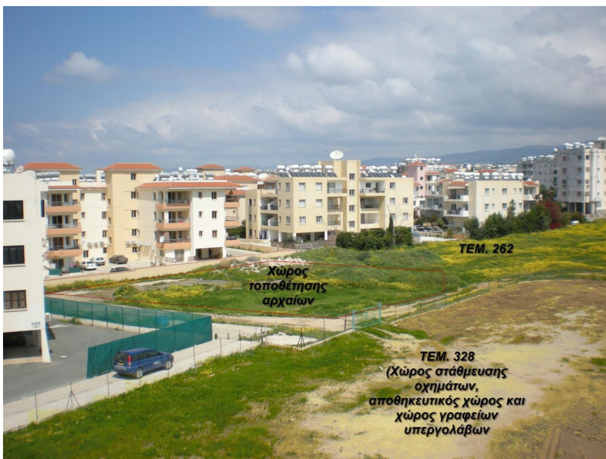
Εικόνα 9: Στην πιο πάνω φωτογραφία φαίνεται το τεμάχιο 328 (σκιασμένο με κίτρινο χρώμα) του οποίου η βόρεια και η δυτική πλευρά γειτνιάζουν με τμήμα του τεμαχίου 362 (βορειοδυτική πλευρά). Το εν λόγω τεμάχιο έχει μισθωθεί από τους κυρίως εργολάβους και χρησιμοποιήθηκε ως χώρος στάθμευσης για το προσωπικό των εργολάβων, υπεργολάβων και αυτοεργοδοτούμενων που απασχολούνταν στο εργοτάξιο, καθώς και ως αποθηκευτικός χώρος και χώρος γραφείων για τους υπεργολάβους. Στην ίδια φωτογραφία φαίνεται τμήμα του τεμαχίου 262 (κόκκινο περίγραμμα) το οποίο περιφράχθηκε και τοποθετήθηκαν τα αρχαία που βρεθήκαν εντός του εργοταξίου.
