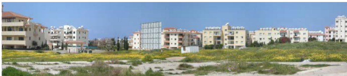
Εικόνα 8: Στην πιο πάνω φωτογραφία φαίνεται μέρος του τεμαχίου 362 (βορειοδυτική πλευρά). Επίσης στην ίδια φωτογραφία διακρίνονται πολυκατοικίες και συγκροτήματα διαμερισμάτων τα οποία είναι ανεγερμένα εντός των τεμαχίων Τεμ. 270, Τεμ 269, Τεμ.329, Τεμ.336 και Τεμ.263 τα οποία γειτνιάζουν στα βορειοδυτικά με τον εργοταξιακό χώρο (Τεμ.362).
