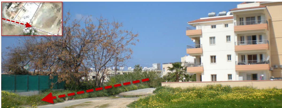
Εικόνα 11: Στην πιο πάνω φωτογραφία φαίνεται το δυτικό άκρο του τεμαχίου 262. Επίσης επισημάνεται με βέλος ο δημόσιος δρόμος μέσω του οποίου εξασφαλίστηκαν η πρόσβαση προς τον χώρο στάθμευσης οχημάτων προσωπικού και τον χώρο αποθήκευσης υλικών του εργοταξίου.
