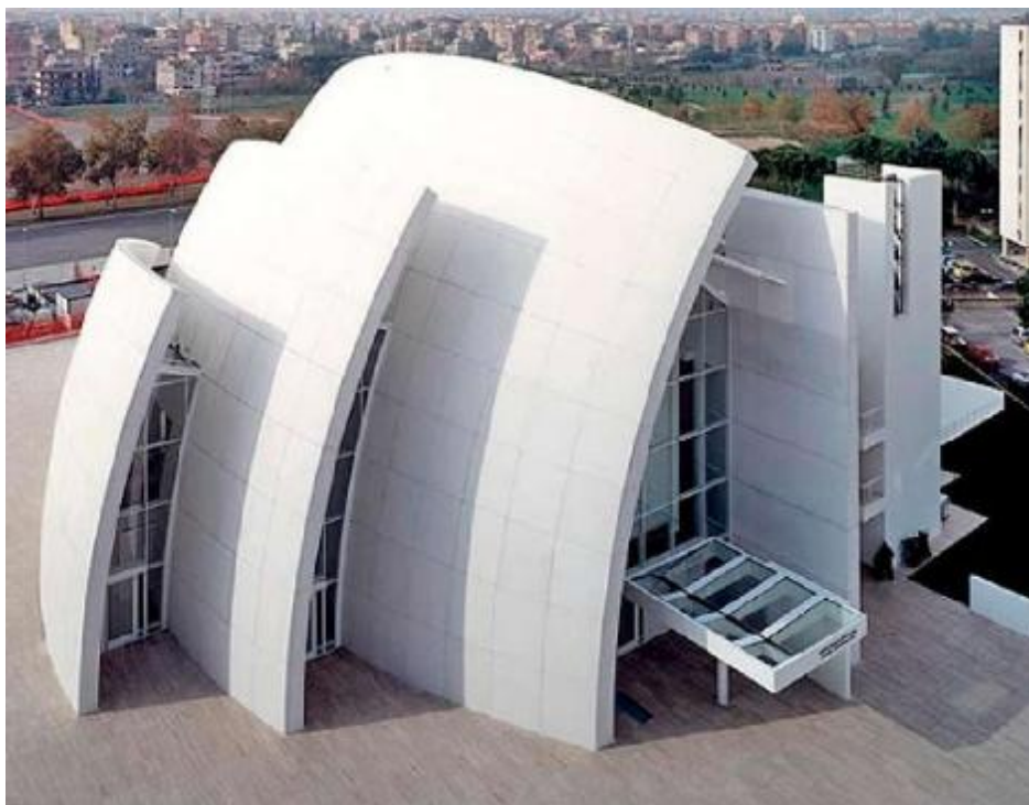
Εικόνα 2. 1: Το αστραφτερό άσπρο σκυρόδεμα του εικονιζόμενου ναού στη Ρώμη, αναμένεται να παραμείνει καθαρό, με τη βοήθεια της πρόσμιξης TiO_2
