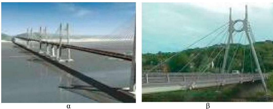
Εικόνα 2. 8 α & β: Χαλύβδινες γέφυρες με μεγάλα φατώματα
