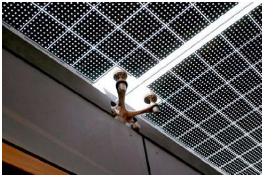
Εικόνα 3. 17: Ταβάνι με διάταξη που έχει ως βάση νανο- κάψουλες παραφίνης, οι οποίες αλλάζουν από τη στερεά στην υγρή φάση, καθώς την ημέρα υγροποιούνται από την ηλιακή ακτινοβολία και το βράδυ αποδίδουν τη θερμότητα.
