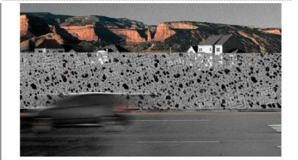
Εικόνα 3. 27: Τοιχεία του αυτοκινητόδρομου κατασκευασμένα από φωτοκαταλυτικό σκυρόδεμα
