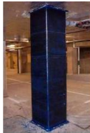
Εικόνα 2. 5 α&β: Δοκοί (α) και κολώνα (β) τυλιγμένες με φύλλα ινών
