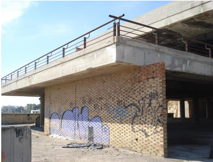
Εικόνα 26: Στάθμη Δ - Δείγμα χαρακτηριστικών διαχωριστικών τοίχων από οπτόπλινθους.
