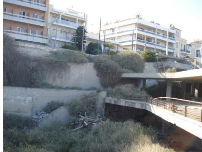
Εικόνα 37: Άναρχη βλάστηση από την ανατολική πλευρά του κτιρίου, στο μέρος των κλιμάκων προς τον περιφερειακό της Καστέλλας.
