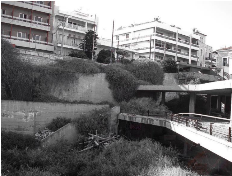
Εικόνα 23: Οι κλίμακες στην Ζ' στάθμη με πλήρη κάλυψη άναρχης βλάστησης.
