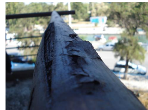
Εικόνα 35: Κιγκλιδώματα, διόγκωση του σιδήρου της κουπαστής.
