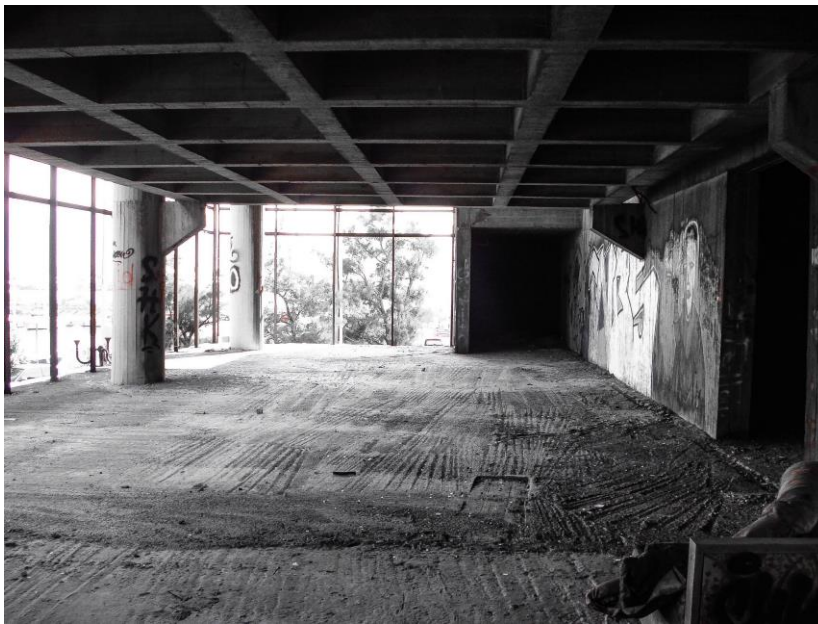
Εικόνα 21: Στάθμη Β' ο υφιστάμενος χώρος του φουαγιέ με την είσοδο του αμφιθεάτρου. Πλάκες τσέλνερ στην οροφή που σχηματίζεται από το μεσοπάτωμα ( Στάθμη Γ').
