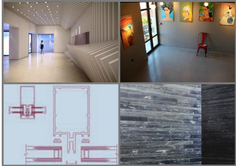
Εικόνα 46: Πάνω αριστερά υπόδειγμα πατητής τσιμεντοκονίας, λευκού χρώματος και δεξιά γκρι. Κάτω αριστερά υπόδειγμα σύνδεσης υαλοπετασμάτων και δεξιά η πέτρινη σύνθεση της επικάλυψης της επιφάνειας του κτιρίου.
