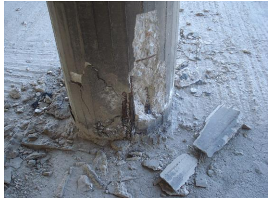
Εικόνα 29: Ρηγμάτωση και αποκόλληση σκυροδέματος με αποκάλυψη οπλισμού και ενανθράκωση του, σε ένα από τα συνηθέστερα σημεία στο κτίριο, στα υποστυλώματα.
