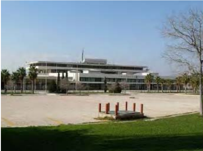
Εικ. 30. Κτήριο του Ανατολικού Αερολιμένα
