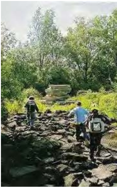
Εικ. 26. Αεροδρόμιο Maurice Rose . Χρήση αποξηλωμένων στοιχείων οπλισμένου σκυροδέματος για επαναδιαμόρφωση του τοπίου.
