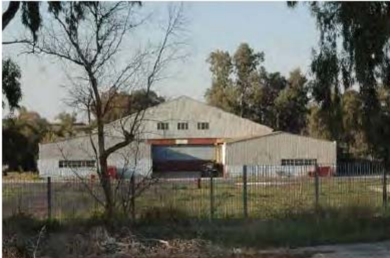
Εικ. 29. Υπόστεγο ΜΜ στην περιοχή της 129 Π.Μ.
