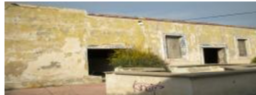
21. Κτίριο 1(νότια όψη)
