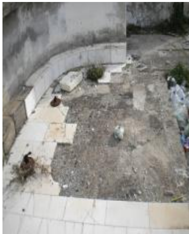
58. ρηγματώσεις σε δάπεδο 59. παρασιτική βλάστηση 60. παρασιτική βλάστηση
