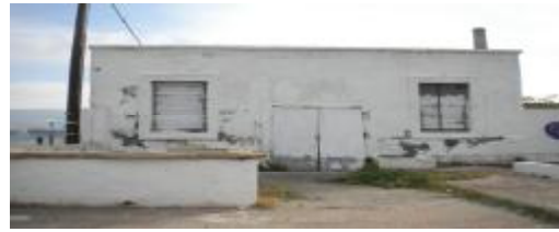
20. Κτίριο 1(βόρεια όψη)
