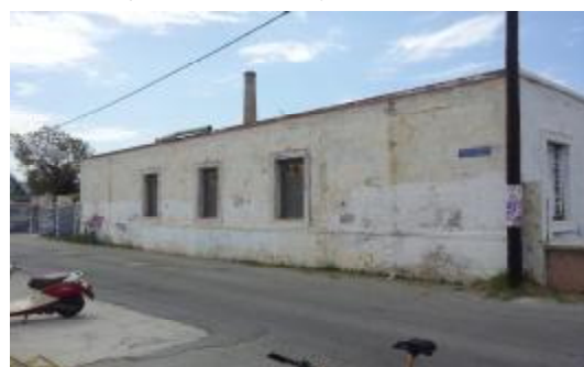
19.Κτίριο 1(δυτική όψη)
