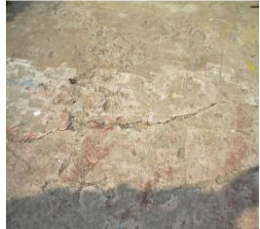
56. Υπαίθριος, ρηγματώσεις και καθιζήσεις δαπέδων 57. ρηγματώσεις σε δάπεδο
