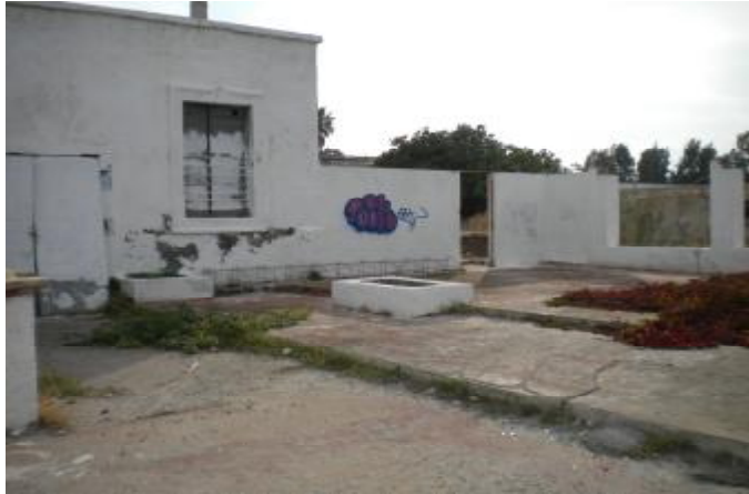
56. Υπαίθριος, ρηγματώσεις και καθιζήσεις δαπέδων 57. ρηγματώσεις σε δάπεδο
