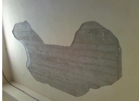
Εικόνα 101 Κτήριο Α, οροφή αίθουσας Γ
