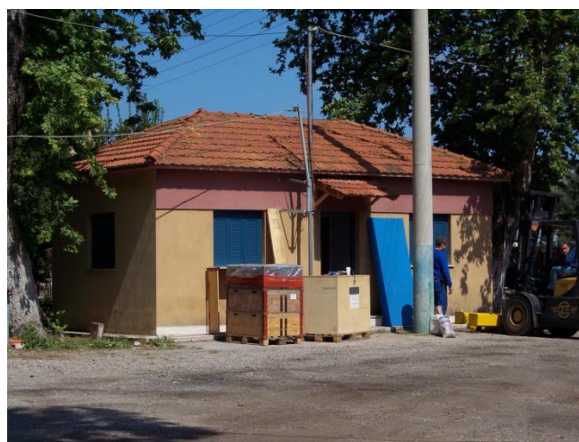
Εικόνα 061 Κτήριο Δ «Νέα Αποθήκη»
