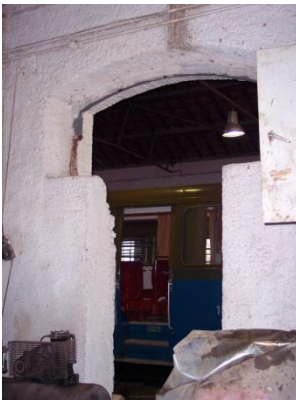
Εικόνα 076 Κτήριο Α, άνοιγμα από αίθουσα Β στη Δ
