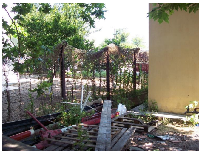
Εικόνα 062 Κτήριο Δ «Νέα Αποθήκη»
