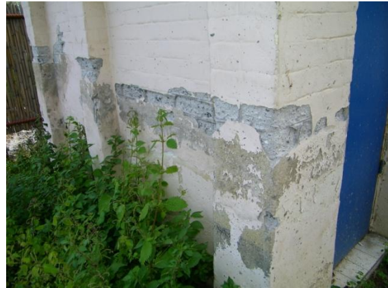
Εικόνα 099 Κτήριο Ε, εξωτερικός τοίχος
