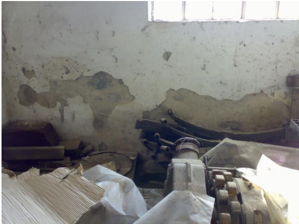
Εικόνα 082 Κτήριο Α, εξωτερικός τοίχος αίθουσας Γ
