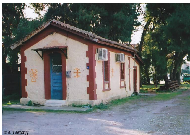
Εικόνα 037 Κτήριο αφετηρίας Διακοπτού - Αποθήκη 1
