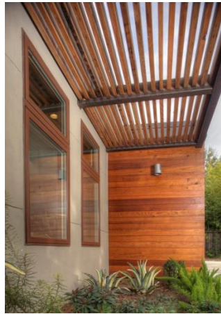
Εικόνα 095 Επένδυση κτηρίου Δ και Ζ και εξωτερικά στέγαστρα
