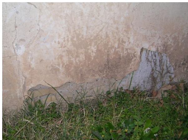
Εικόνα 095 Κτήριο Γ, εξωτερικός τοίχος
