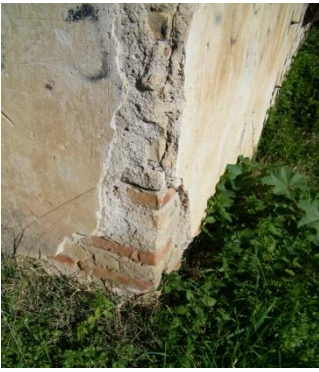
Εικόνα 096 Κτήριο Γ, εξωτερικός τοίχος
