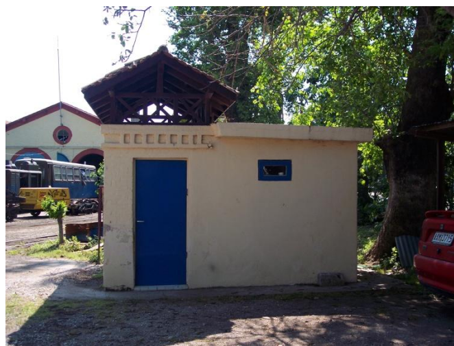
Εικόνα 063 Κτήριο Ε «Χώροι υγιεινής-Αποχωρητήρια»
