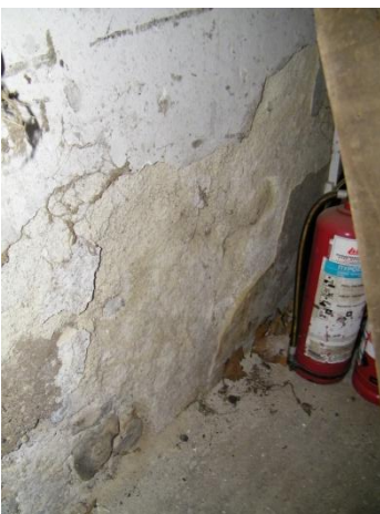
Εικόνα 102 Κτήριο Α, αίθουσα Δ
