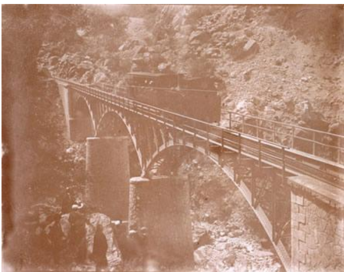
Εικόνα 020 Μεταλλική γέφυρα διαδρομής Δ-Κ
