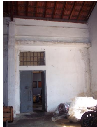
Εικόνα 083 Κτήριο Α τοίχος αίθουσας Δ προς Γ
