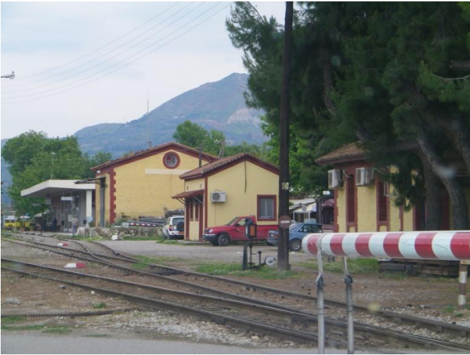
Εικόνα 028 Κτήρια αφετηρίας Διακοπτού
