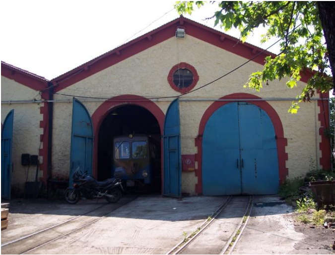
Εικόνα 046 Κτήριο Α «Κεντρικό κτήριο Αμαξοστάσιο» Αμαξοστάσιο»
