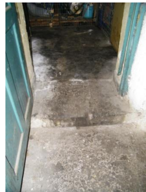
Εικόνα 079 Κτήριο Α- πόρτα προς αίθουσα Γ
