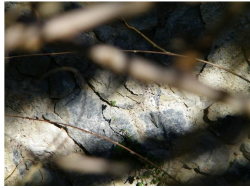
Εικόνα 097 Κτήριο Β, εξωτερικός τοίχος
