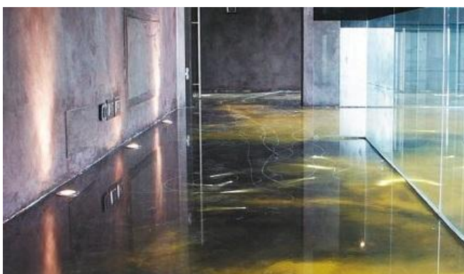
Εικόνα 094 Ενιαίο δάπεδο με οπτικές ίνες
