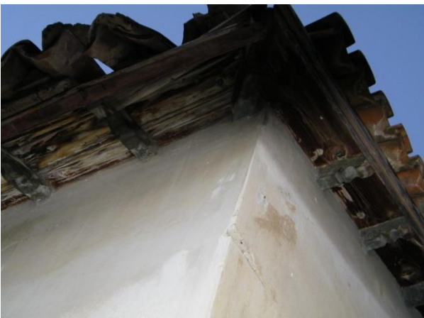
Εικόνα 094 Κτήριο Γ, όψη στέγης
