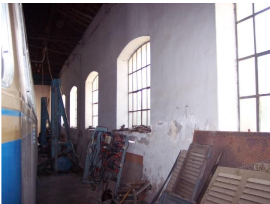
Εικόνα 084 Κτήριο Α, αίθουσα Δ
