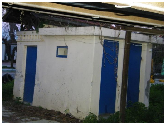
Εικόνα 065 Κτήριο Ε «Χώροι υγιεινής-Αποχωρητήρια»
