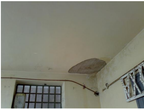
Εικόνα 080 Κτήριο Α, οροφή αίθουσας Γ
