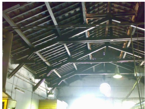
Εικόνα 067 Κτήριο Α - αίθουσα Α, στέγη.
