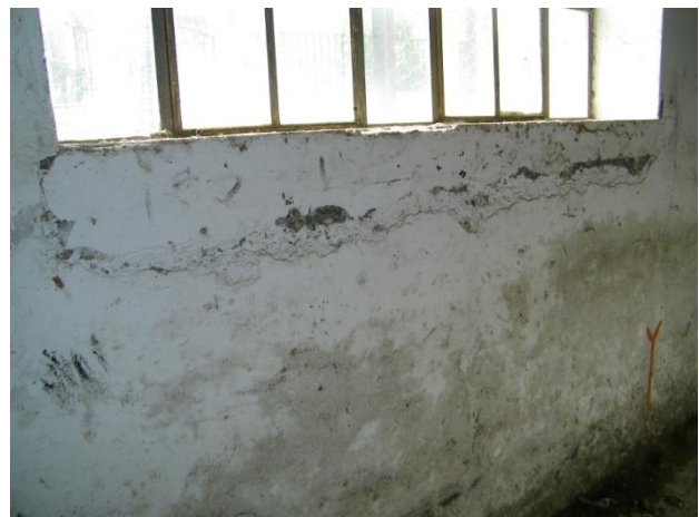
Εικόνα 103 Κτήριο Α, εξωτερικός τοίχος αίθουσας Δ
