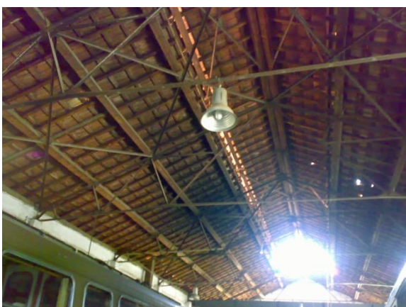
Εικόνα 086 Κτήριο Α, στέγη αίθουσας Δ
