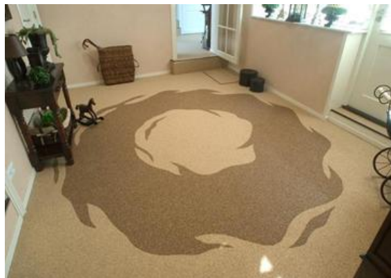
Εικόνα 095 Χυτό δάπεδο «χαλκιού»
