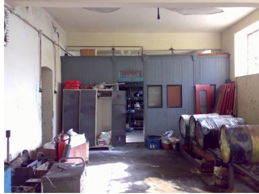
Εικόνα 081 Κτήριο Α ξύλινο εσωτερικό χώρισμα αίθουσας Γ
