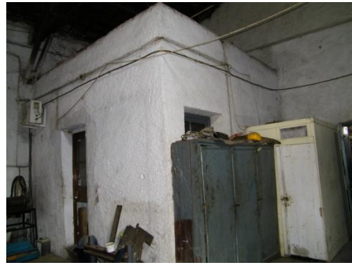
Εικόνα 073 Κτήριο Α – αίθουσα Β, γραφείο εργοδηγού
