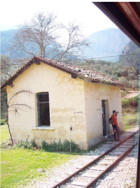
Εικόνα 030 Κτήριο στη θέση «Νιάματα»
