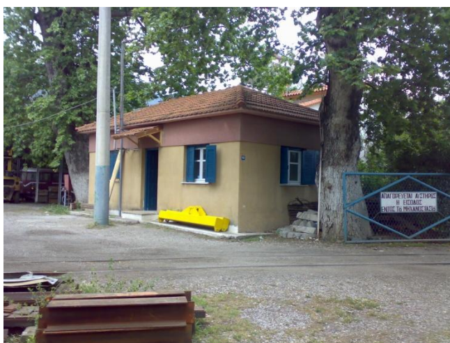
Εικόνα 060 Κτήριο Δ «Νέα Αποθήκη»
