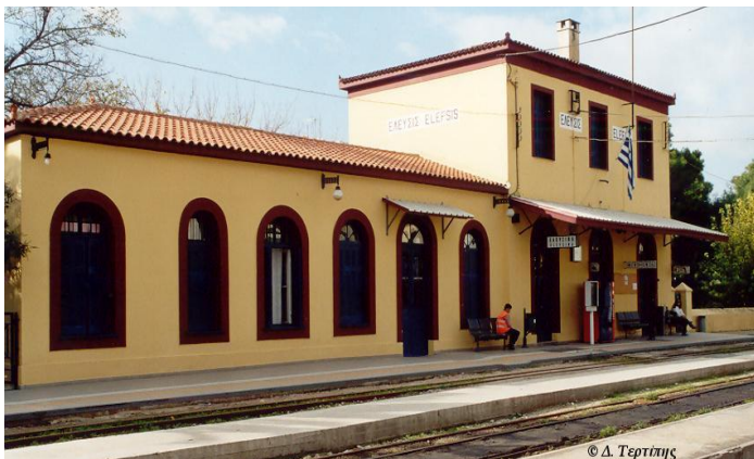
Εικόνα 008 Κτήριο σταθμού Ελευσίνας
