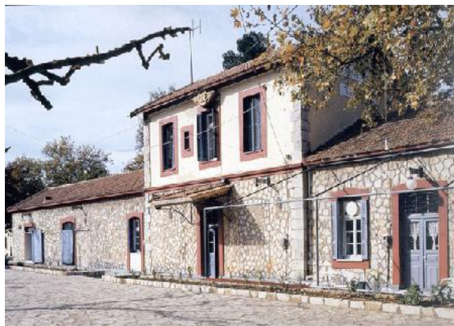
Εικόνα 035 Κτήριο σταθμού Καλαβρύτων
