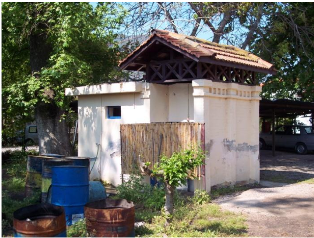
Εικόνα 064 Κτήριο Δ «Νέα Αποθήκη»
