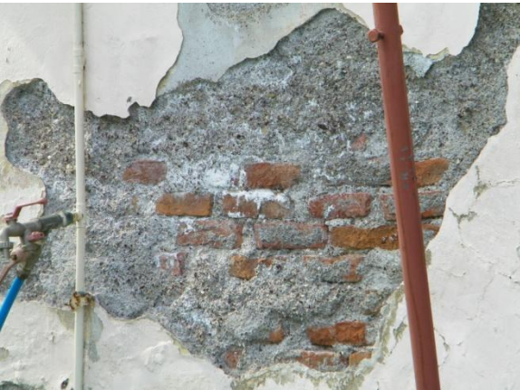
Εικόνα 092 Κτήριο Ε, εξωτερικός τοίχος
