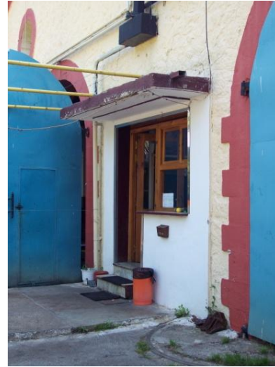
Εικόνα 047 Κτήριο Α «Κεντρικό κτήριο
