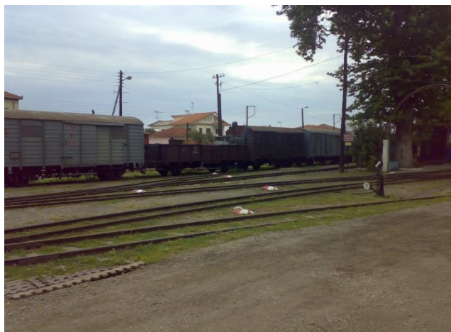
Εικόνα 041 Είσοδος μηχανοστασίου – γραμμές
