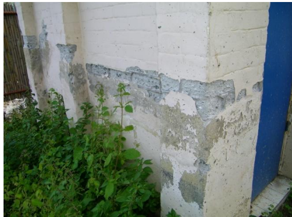
Εικόνα 093 Κτήριο Ε, εξωτερικός τοίχος
