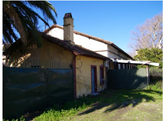
Εικόνα 053 Κτήριο Β «Φυλάκιο - Υπνωτήριο»
