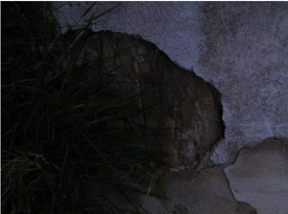
Εικόνα 100 Κτήριο Γ, εξωτερικός τοίχος
