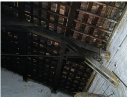
Εικόνα 072 Κτήριο Α - αίθουσα Β, στέγη
