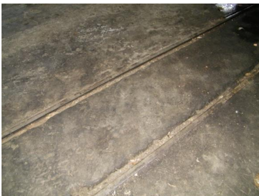
Εικόνα 078 Κτήριο Α, δάπεδο αίθουσας Β
