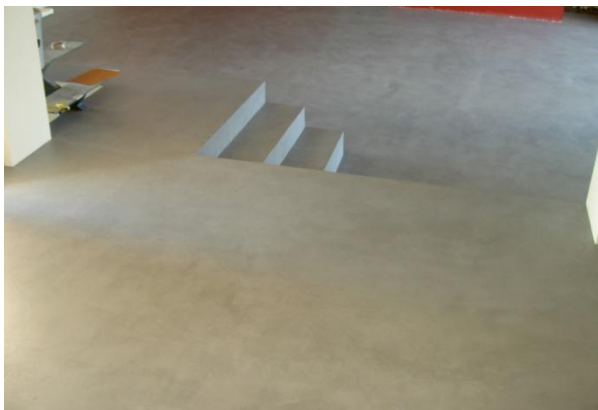
Εικόνα 094 Ενιαίο δάπεδο «πατητή τσιμεντοκονία»
