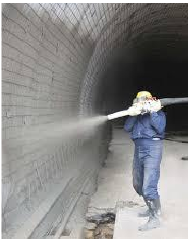
Εικόνα 2.Εκτόξευση σκυροδέματος εσωτερικά της σήραγγας.
