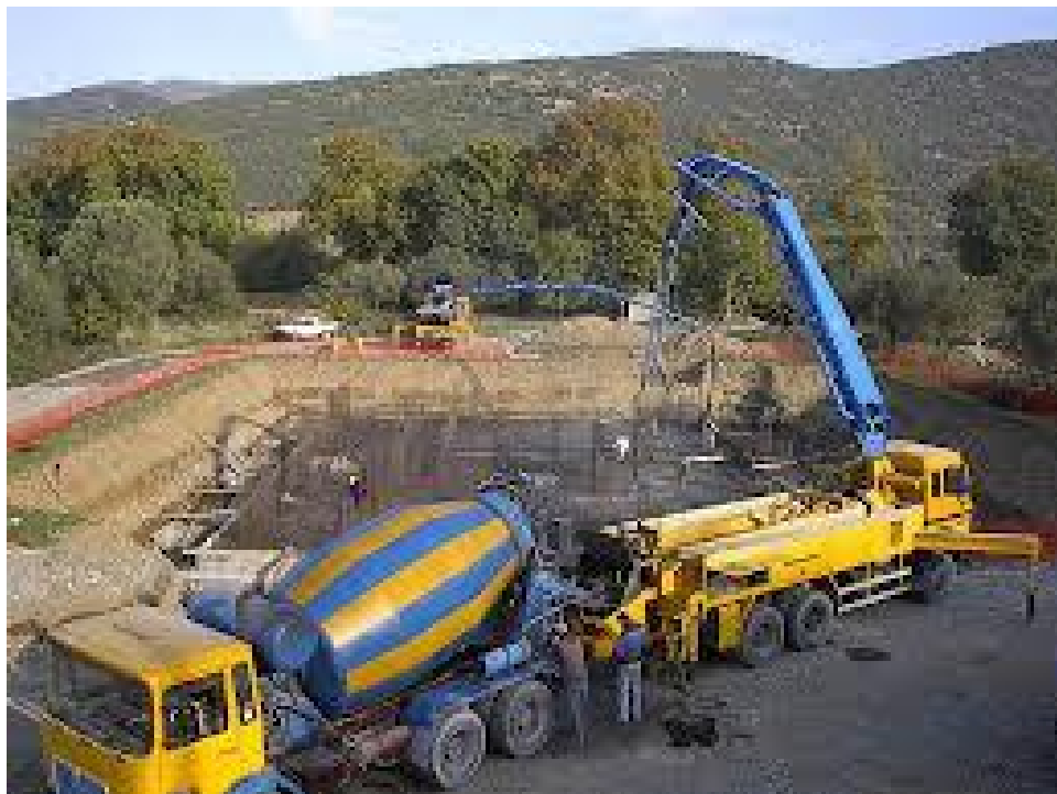
Εικόνα 4. Τρόπος σκυροδέτησης.
