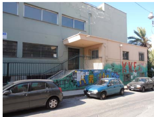
Εικόνα 6: Είσοδος (2) στη βόρεια όψη του βόρειου υφιστάμενου κτιρίου.
