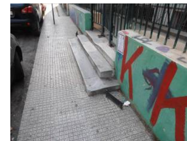
Εικόνες 28 & 29 Άποψη φθαρμένων σκαλιών βόρειου κτιρίου και κάγκελα φρεατίου φωτισμού - αερισμού. Κάγκελα ασφαλείας ανοιγμάτων.
