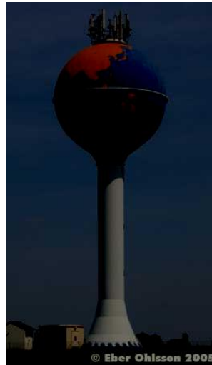
Σχήμα 1.9 Υδατόπυργος τύπου pedi-sphere με σφαιρική δεξαμενή στο Bierbeek, Βέλγιο.1
