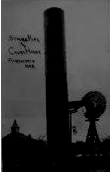
Σχήμα 1.6 Παλιός υδατόπυργος τύπου δεξαμενής σταθερής πίεσεως ύδατος.
