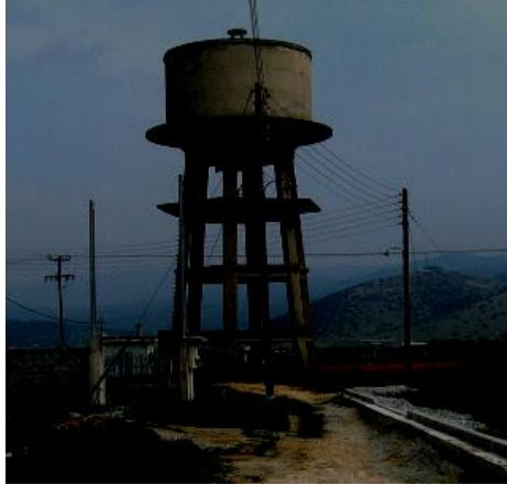
Σχήμα 1.8 Υδατόπυργος στο Δοξάτο Δράμας με κυλινδρική δεξαμενή.
