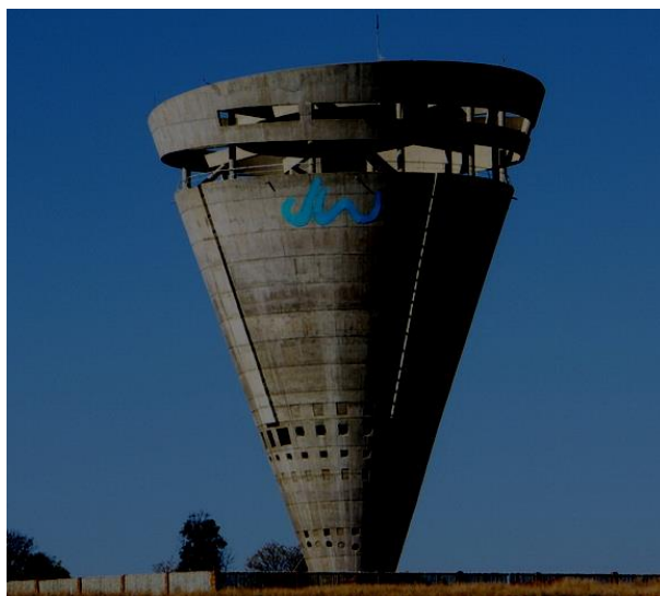
Σχήμα 1.4 Ο υδατόπυργος στο Midrand της Ν.Αφρικής με δεξαμενή χωρητικότητας 6.5 μεγαλίτρων είναι κατασκευασμένος από προενταμένο σκυρόδεμα.
