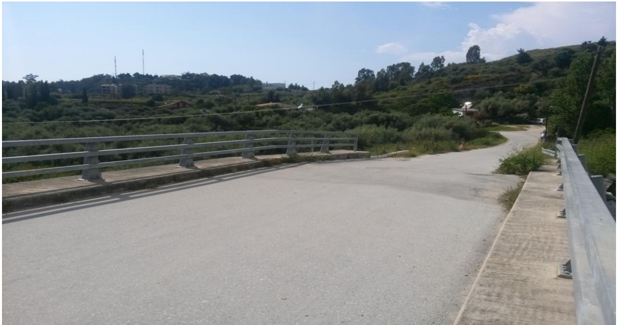
Η γέφυρα Ασυρμάτου – Αρόης όπως κατασκευάστηκε.
