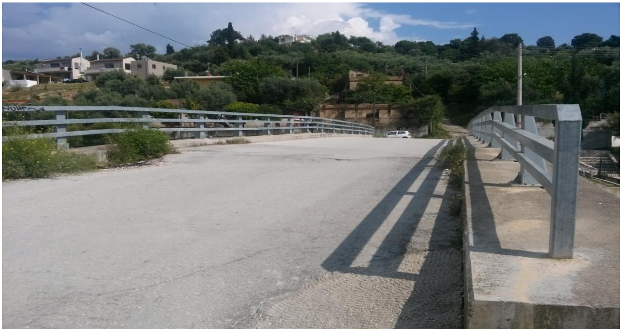
Η γέφυρα Ασυρμάτου – Αρόης όπως κατασκευάστηκε.
