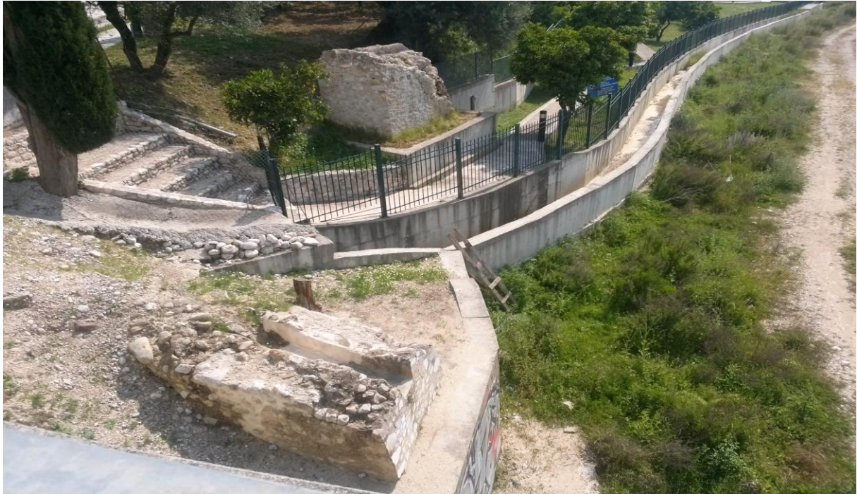
Τμήμα του Ρωμαϊκού Υδραγωγείου.
