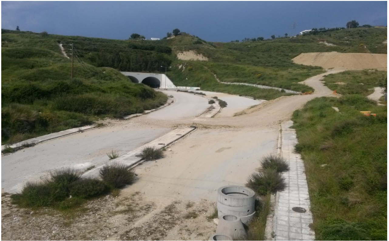
Τμήμα της Μικρή Περιμετρικής Οδού Πάτρας όπως κατασκευάστηκε.
