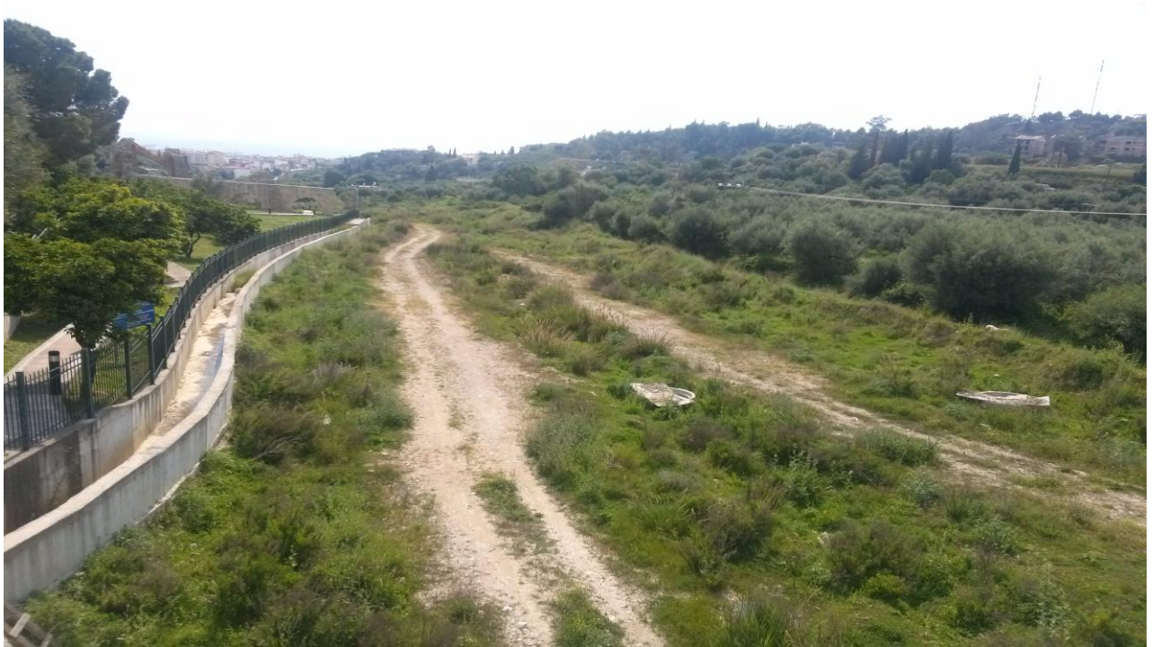
Η θέση όπου θα κατασκευαστεί το υπόλοιπο τμήμα της Μικρής Περιμετρικής Οδού Πάτρας.
