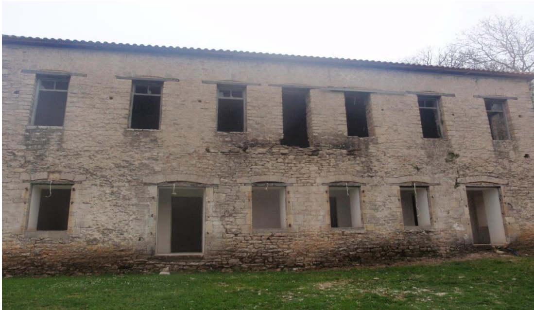
Εικόνα 14- Όψη Παλαιού σχολείου (Φωτογραφικό υλικό)
