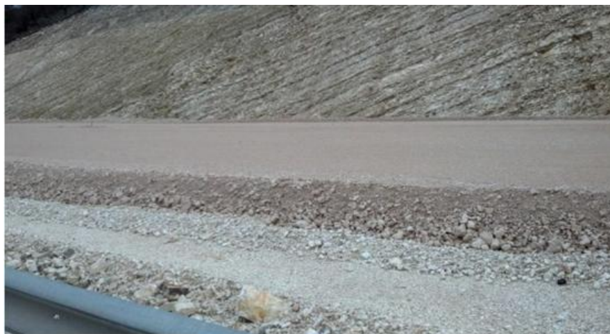
Εικόνα 3.4: Οδόστρωμα – βάση, υπόβαση
