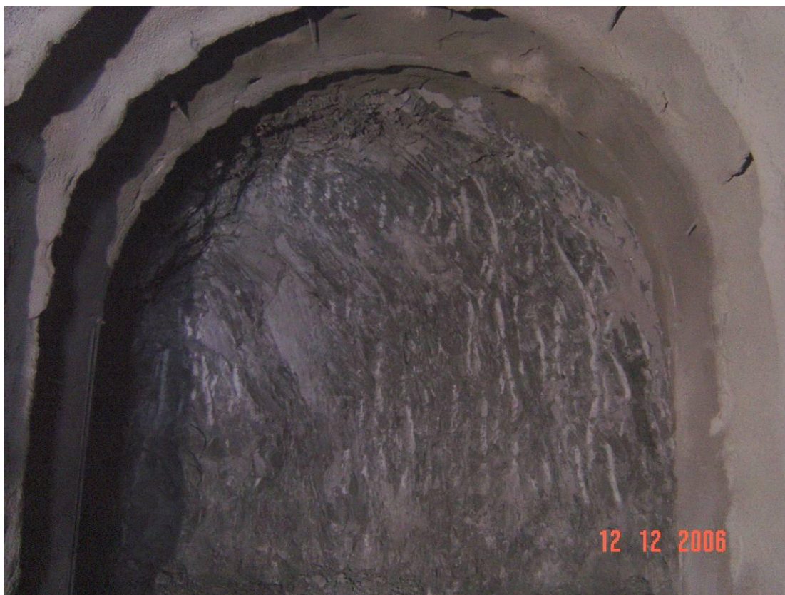
Μέτωπο εκσκαφής κατά τη διάνοιξη
