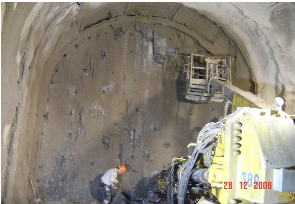
ΔΙΑΤΡΗΣΗ ΚΑΙ ΤΟΠΟΘΕΤΗΣΗ ΕΚΡΗΚΤΙΚΩΝ ΓΙΑ ΕΛΕΓΧΟΜΕΝΗ ΑΝΑΤΙΝΑΞΗ
