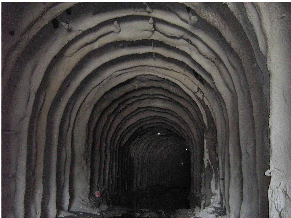
ΠΡΟΣΩΡΙΝΑ ΜΕΤΡΑ ΥΠΟΣΤΗΡΙΞΗΣ (ΑΓΚΥΡΙΑ –ΜΕΤΑΛΛΙΚΟ ΠΛΕΓΜΑ-ΔΙΚΤΥΩΤΑ ΠΛΑΙΣΙΑ –ΓΚΑΝΑΪΤ)
